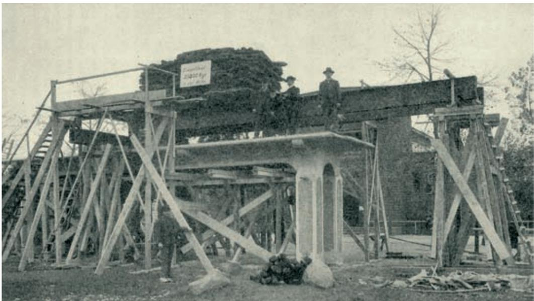
**Bild 3:** Bruchversuch der Hennebique-Brücke auf der Deutschen Städte-Ausstellung in Dresden 1903 | Foto: aus [4, S. 94]
