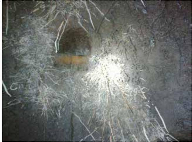
Wurzeleinwuchs in einem Kanal im Bereich eines Zulaufs.
