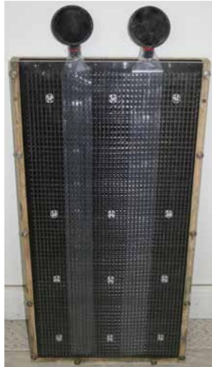
Zur Betonage vorbereitete Schalung mit Carbontextilien und Abstandhaltern.
