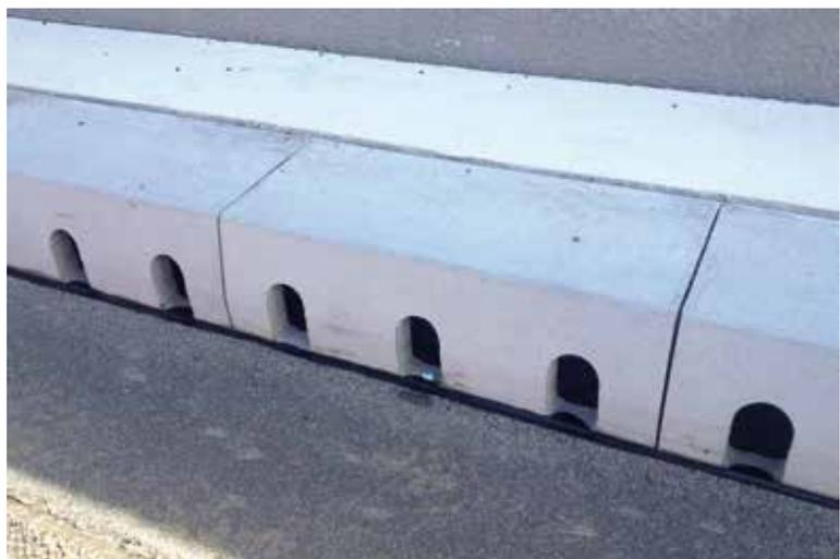
Elemente einer Linienentwässerung. Foto: Kai Schneider
