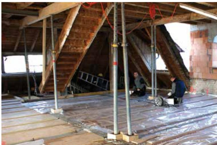
Sanierung der Villa Kalkhütte am Lindauer Yachthafen mit einer Holz-Beton-Verbunddecke. Foto: Elascor GmbH
