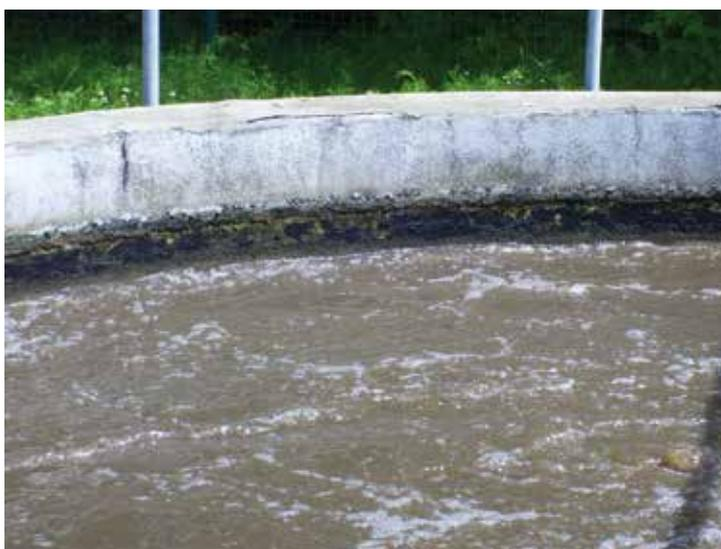
Belebungsbecken mit lokaler Korrosion (Wasserkante) und vertikaler Rissbildung.
