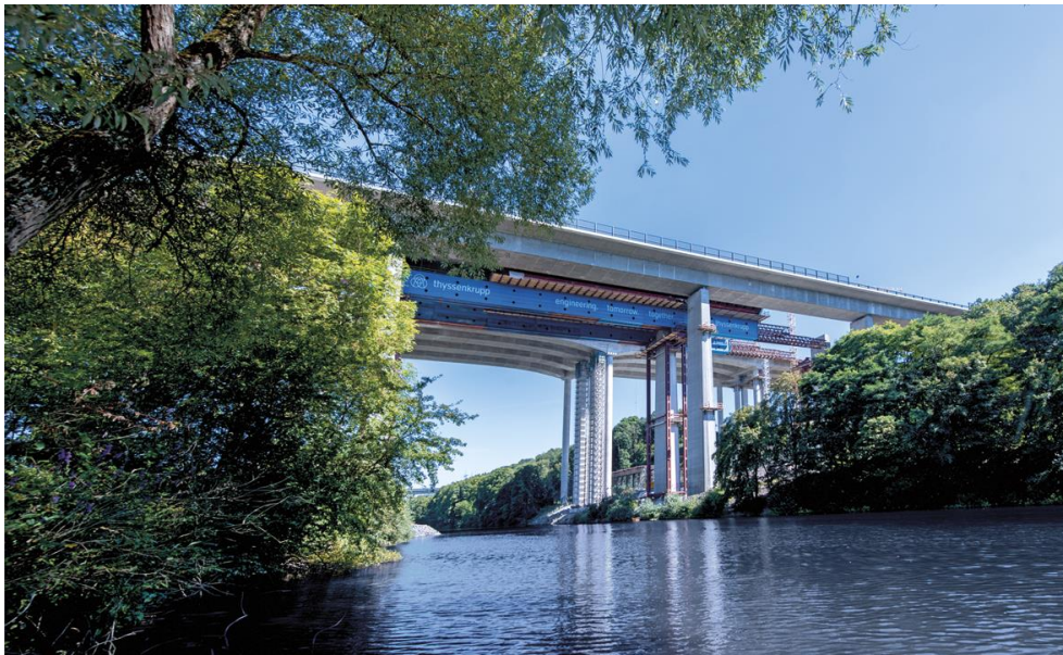
Beispiel des Abbruchs der Lahntalbrücke BAB 45 mittels Vorschubgerüst
