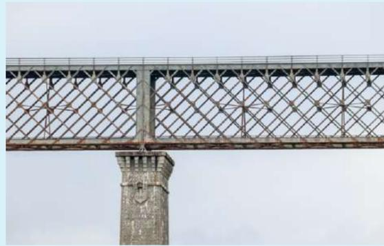
Abb. 5.24: Dreifach gekreuztes Stahlfachwerk
