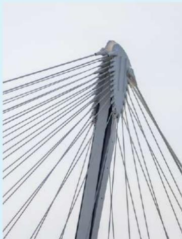
Abb. 10.28: Pylonkopf mit Kabelfächer
