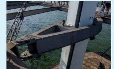
Abb. 10.20: Horizontale Dämpfer des Fachwerks am Pylon
