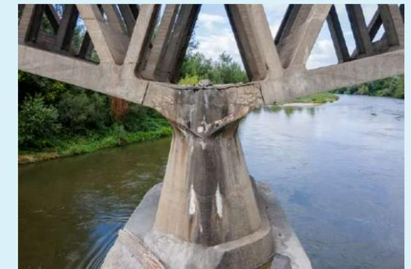
Abb. 5.13: Mittelpfeiler mit Betongelenken
