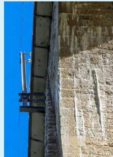
Abb. 9.53: Ausblühungen des Mörtels und starke Korrosion der Betonkappe
