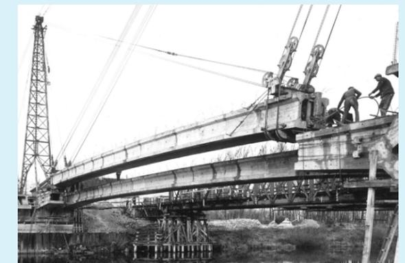
Abb. 2.17: Montage mittels Kabelkran
