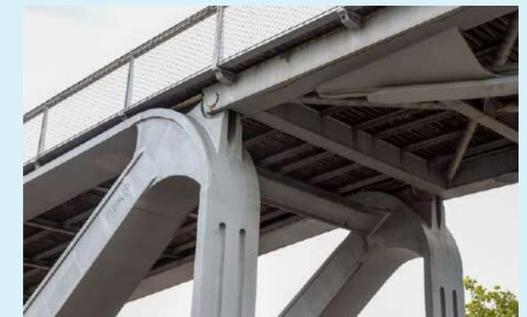
Abb. 4.28: Kraftumleitung des Spannbandes
