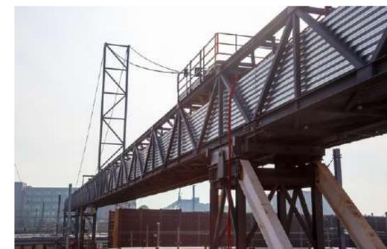
Abb. 4.5: Behelfsbrücke zum Bau der Pfeiler
