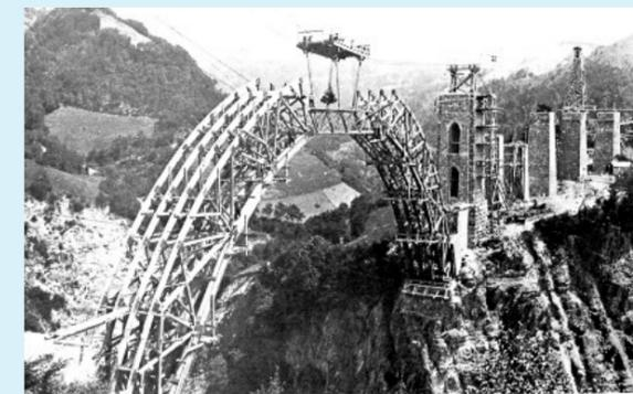
Abb. 9.39: Nutzung eines Kabelkrans zur Errichtung des Lehrgerüsts
