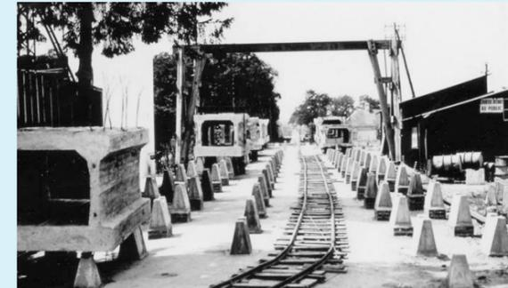
Abb. 2.15: Vorfertigung der Kastenträger im Werk
