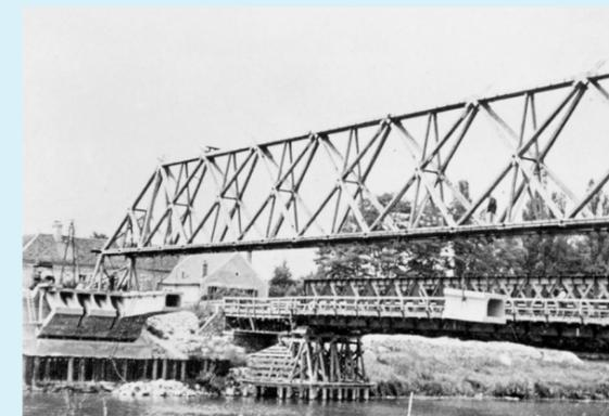
Abb. 2.16: Montage mittels Holzgerüst
