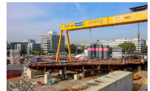
Abb. 4.6: Taktkeller mit erstem Brückensegment
