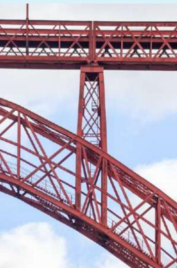
Abb. 6.18: Ständerkonstruktion
