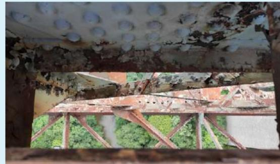
Abb. 5.18: Stark korrodierte Stahlträger
