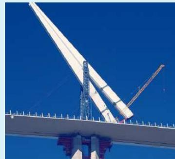
Abb. 6.23: Aufrichtung der Pfeiler
