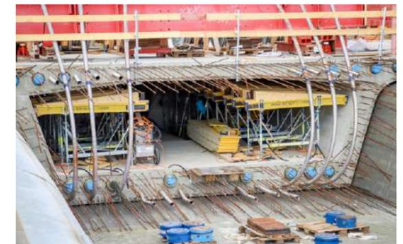
Abb. 1.14: Fugenausbildung mit Spanngliedführung
