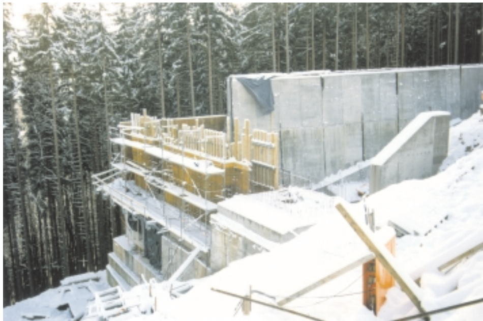
Bild 4.5: Widerlager Achse 14 in Bau
