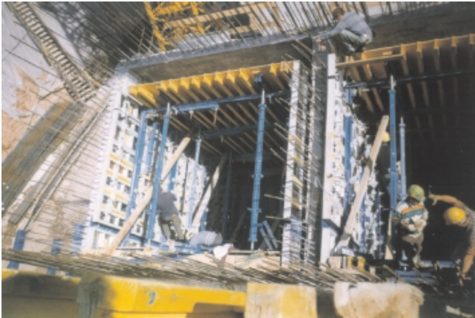
Bild 4.11: Blick in die Bogeninnenschalung
