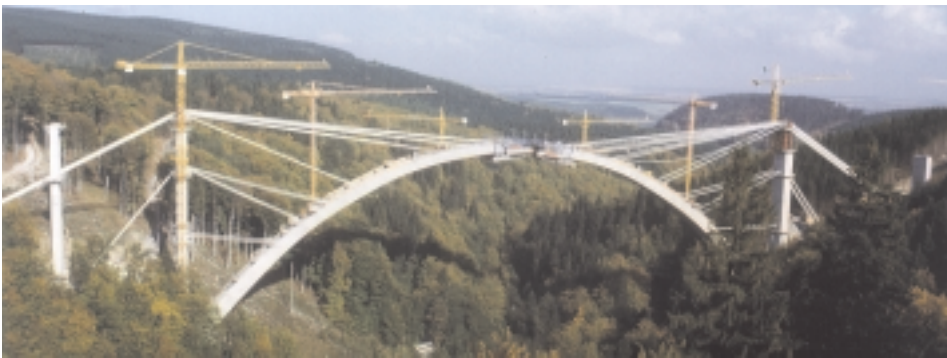
Bild 4.12: Bogen kurz vor Bogenschluß
