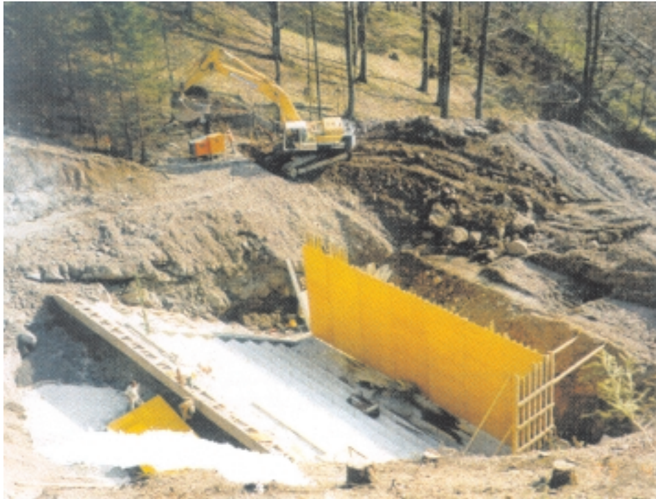
Bild 4.9: Schalung Kämpferfundament
