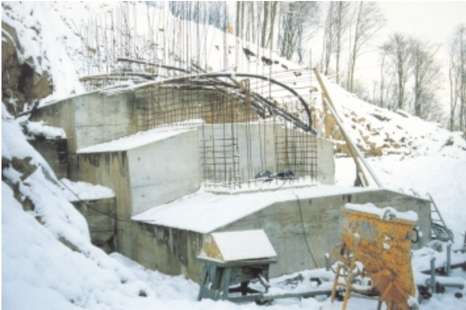
Bild 4.8: Pfeilerfundament
