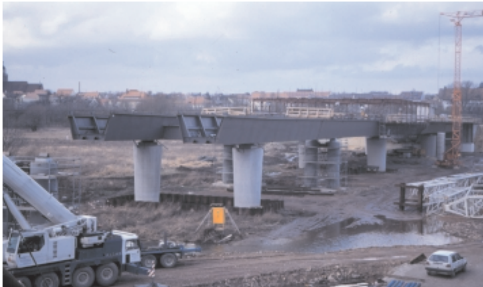
Bild 9.5: Vorlandöffnung der Elbequerung (Nordseite)
