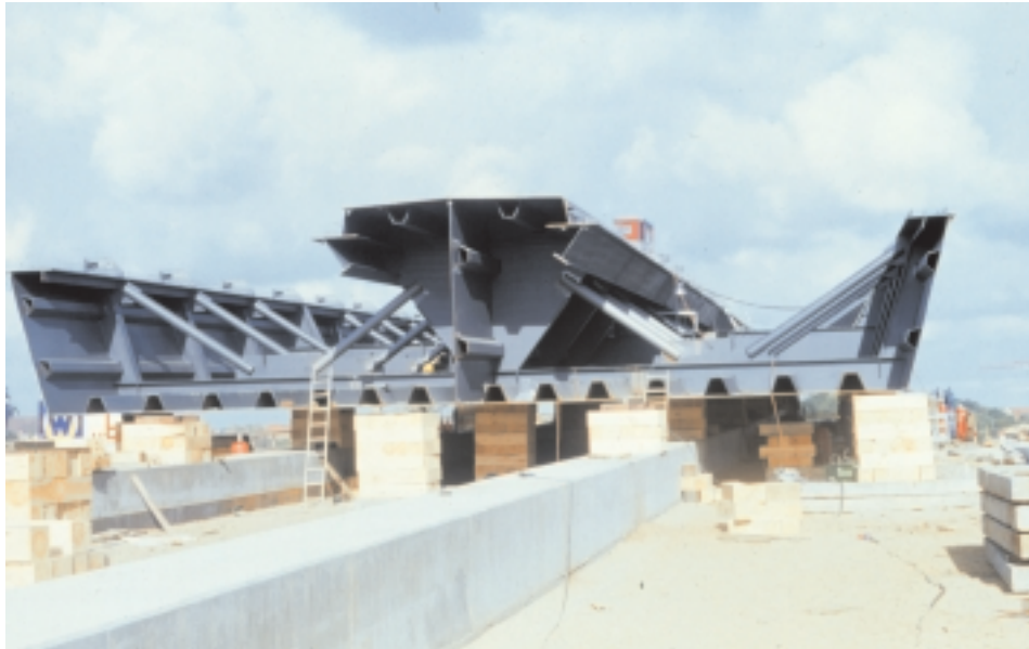
Bild 9.3: Querschnitt Stahlhohlkasten
