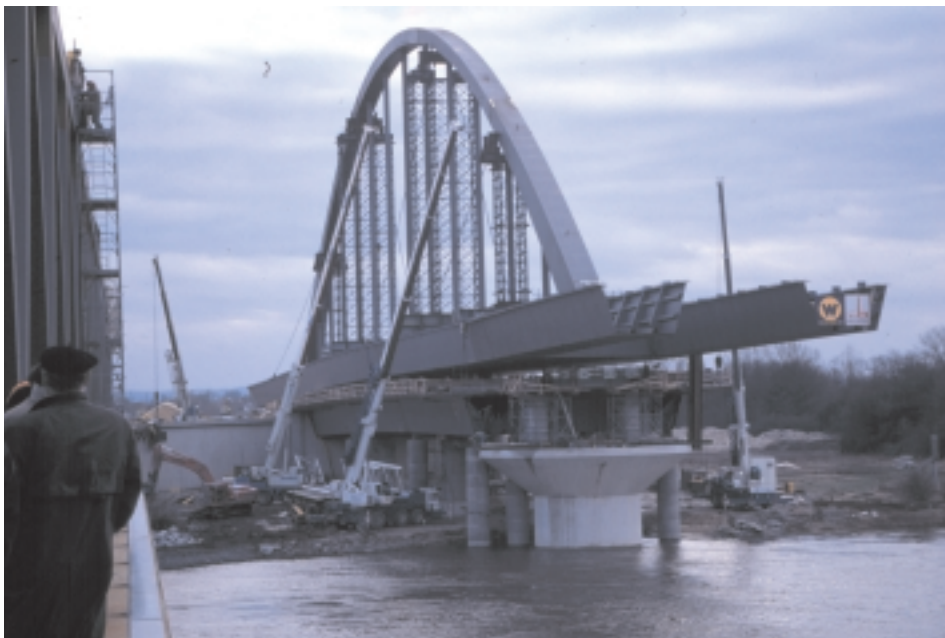
Bild 9.7: Stabbogen Straßenbrücke nach vollendeter Montage
