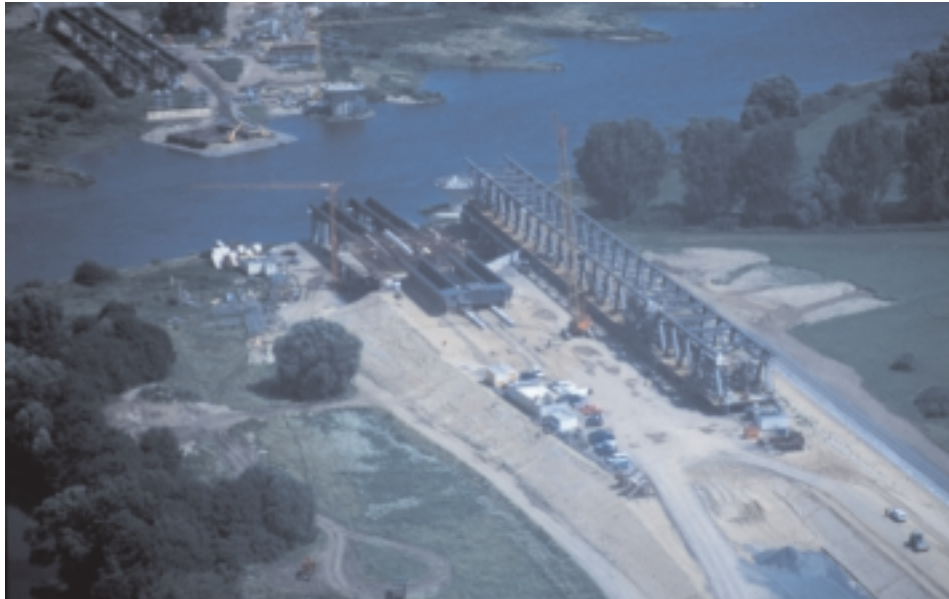
Bild 9.1: Luftbildaufnahme während der Bauzeit
