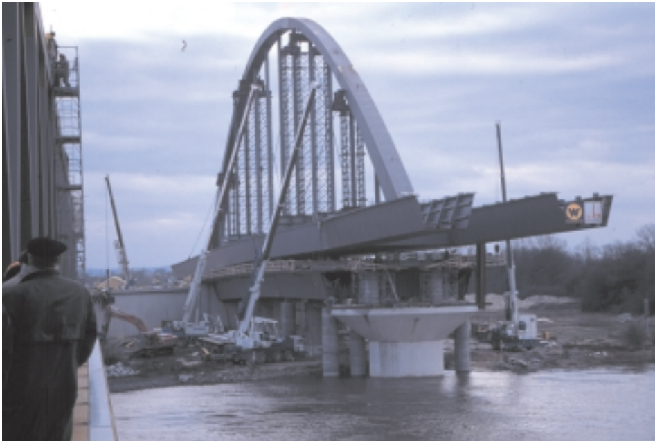
Bild 9.4: Brücke vor dem Einschwimmen
