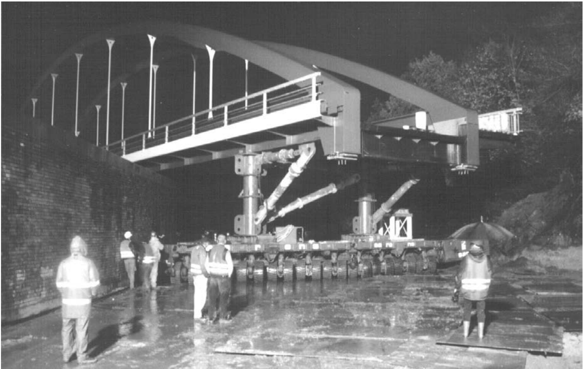
Bild 1.44: Während des Vershub mittels Tieflader, Foto: Brandenburgisches Autobahnamt
