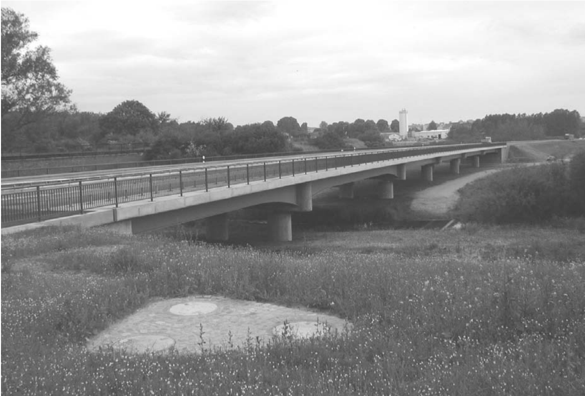
Bild 1.30: Maurinebrücke im Zuge der B 104, Foto: Straßenbauamt Schwerin
