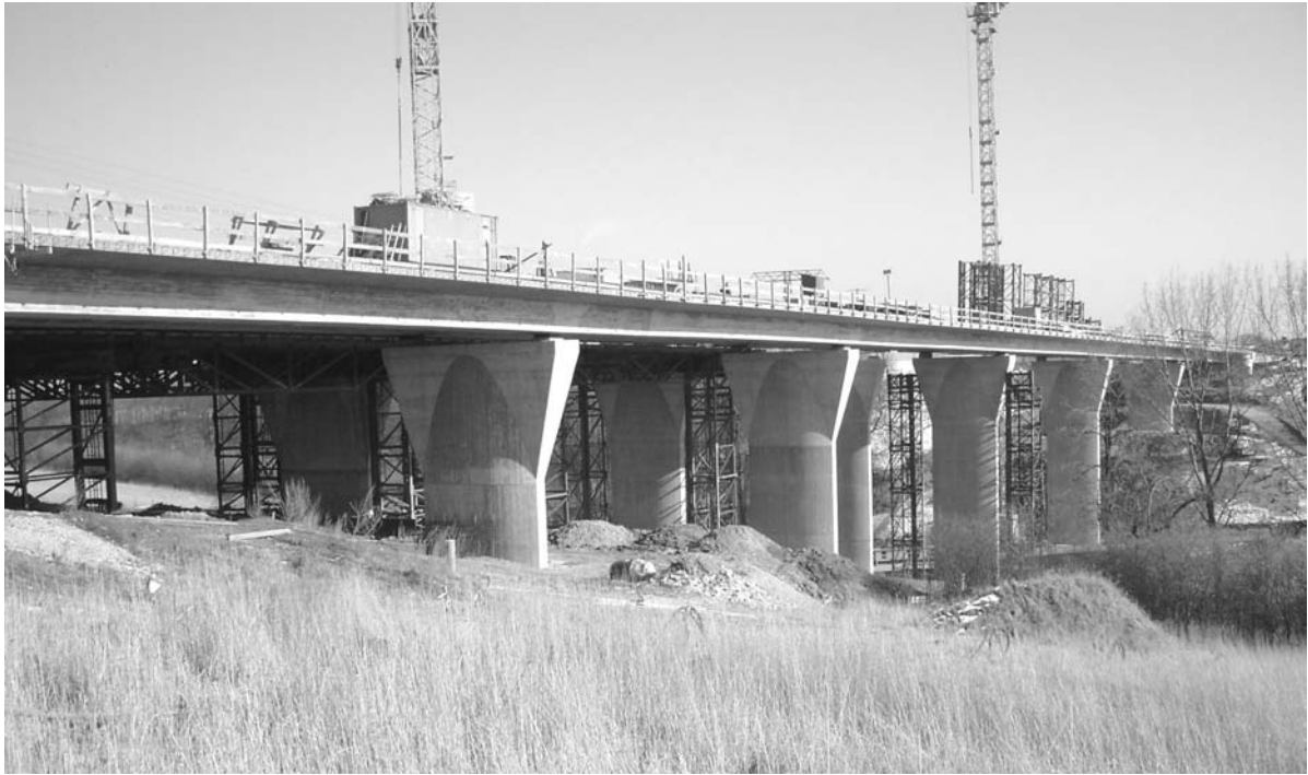
Bild 1.4: Nöthnitzgrundtalbrücke, BAB A 17
