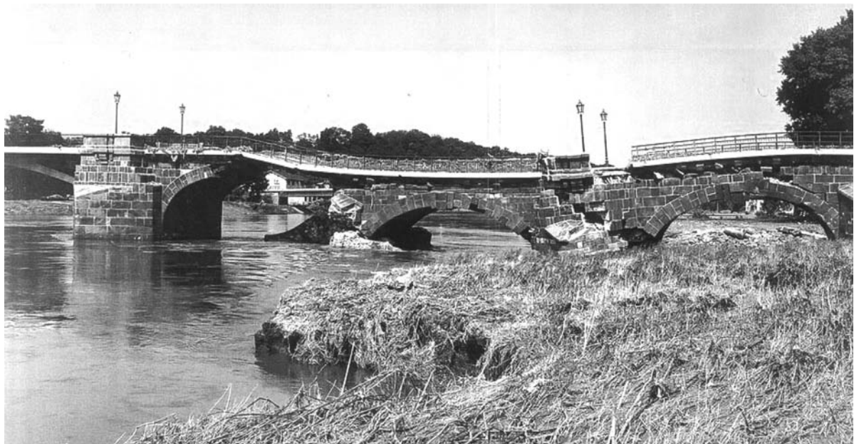
Bild 1.1: Zerstörte Muldebrücke Grimma (Pöppelmannbrücke), August 2002
