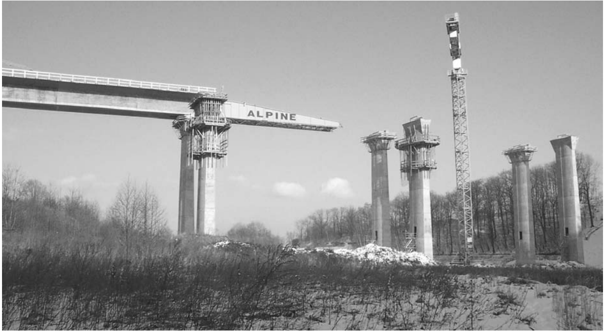
Bild 1.6: Gebergrundtalbrücke, BAB A 17
