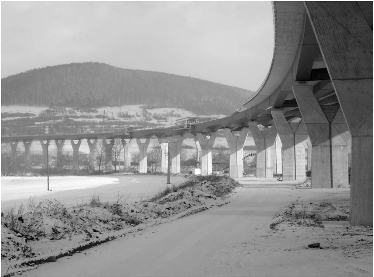
Bild 1.20: Werratalbrücke Einhausen, BAB A 71
