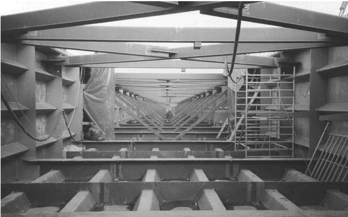
Bild 1.27: Steinbachtalbrücke – stählerner U-Querschnitt des einteiligen Überbaues, Foto: DEGES
