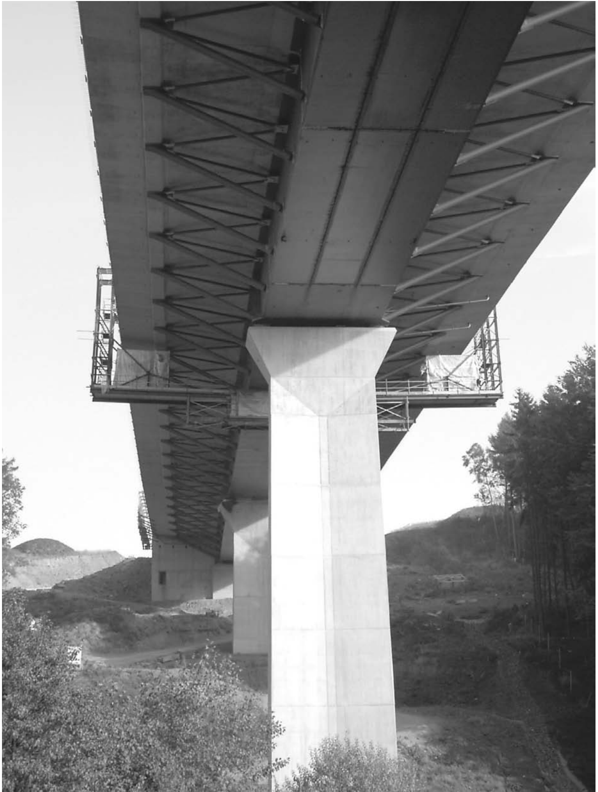
Bild 1.26: Steinbachtalbrücke im Zuge der BAB A 38 bei Bodenrode, Foto: DEGES
