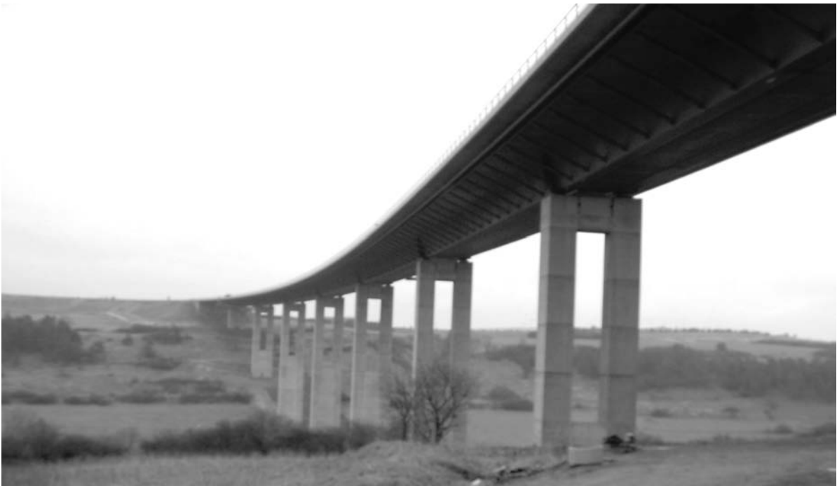
Bild 1.15: Talbrücke Schwarza – einteiliger Stahlverbundüberbauquerschnitt, Foto: DEGES
