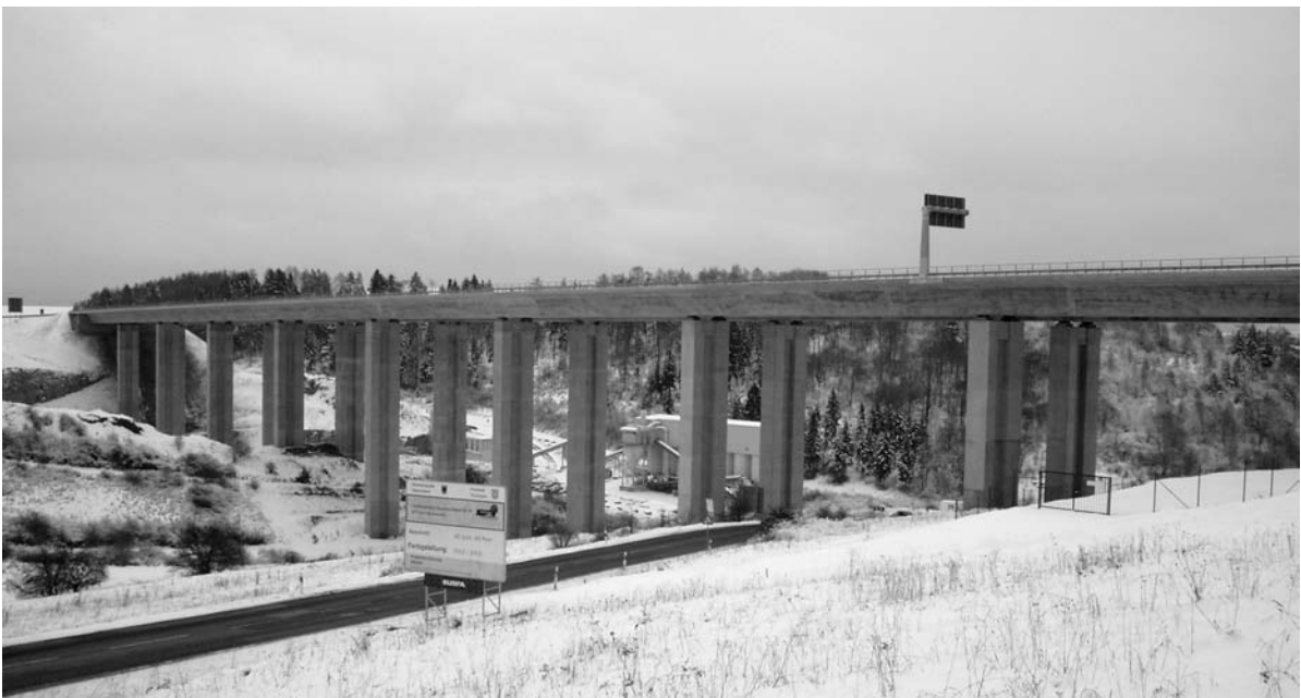
Bild 1.16: Talbrücke Schindgraben – Spannbetonhohlkästen
