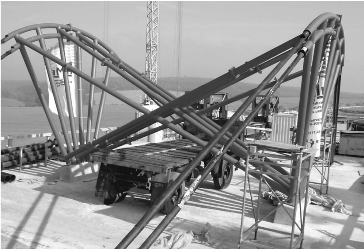
Bild 1.25: Talbrücke über den Etzelsbach – längsverfahrbare Pylonkonstruktion mit Zusatzspanngliedern im Bauzustand, Foto: DEGES
