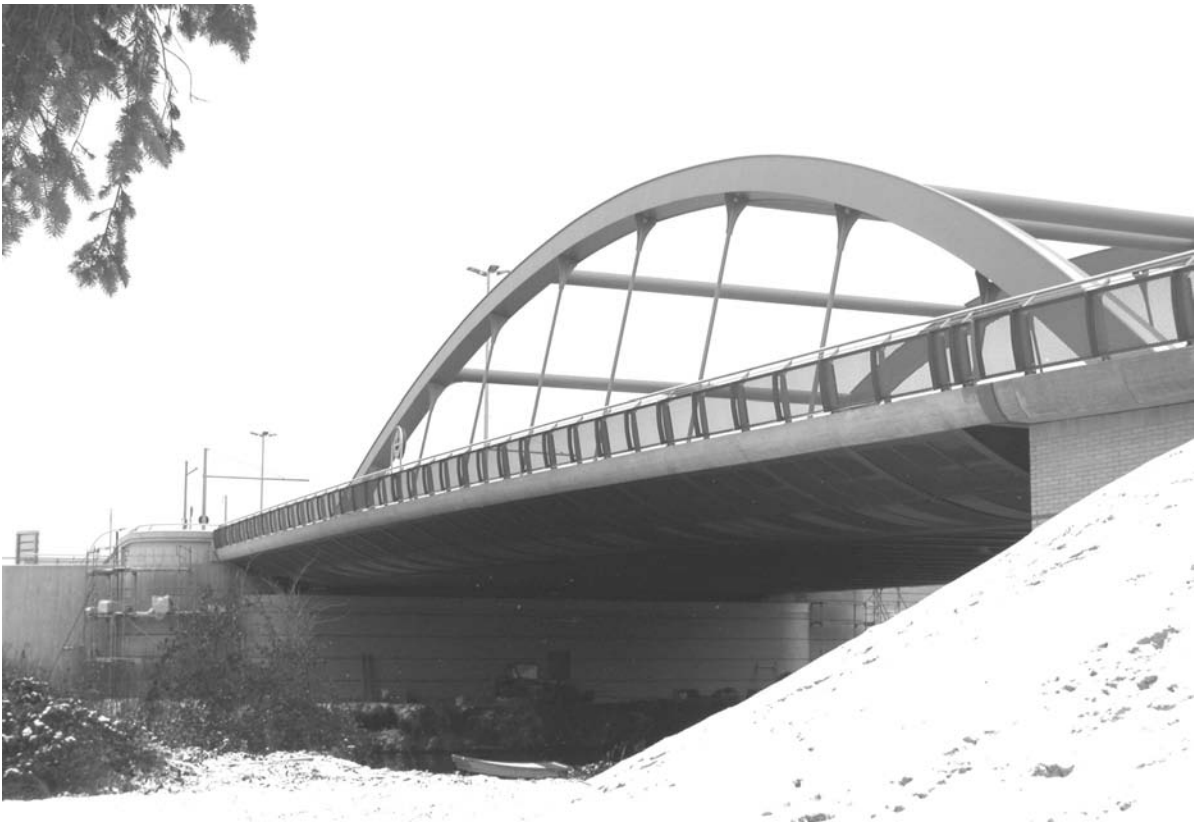
Bild 1.37: Neue Späthbrücke im Zuge der Späthstraße über den Teltowkanal, Foto: SEN Berlin
