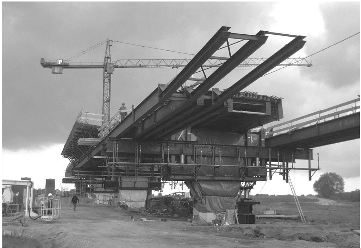
Bild 1.24: Recknitztalbrücke mit Vorschubrüstung, Foto: DEGES
