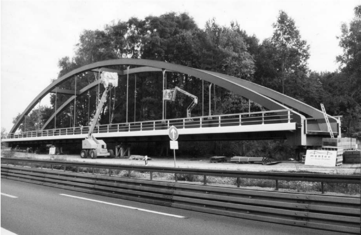
Bild 1.42: Montierter Stabbogen in Seitenlage zur BAB A 10 vor dem Vershub mittels Tieflader Foto: Brandenburgisches Autobahnamt
