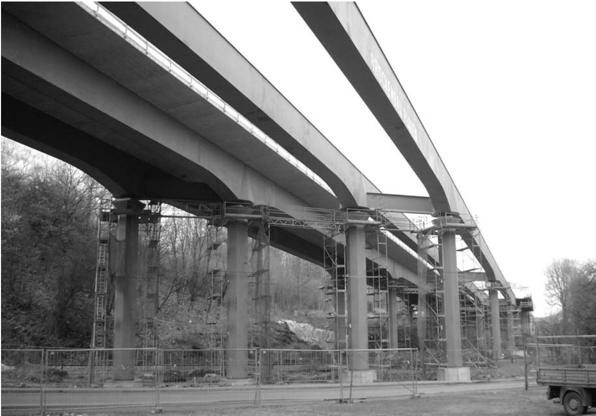
Bild 1.8: Müglitztalbrücke, BAB A 17
