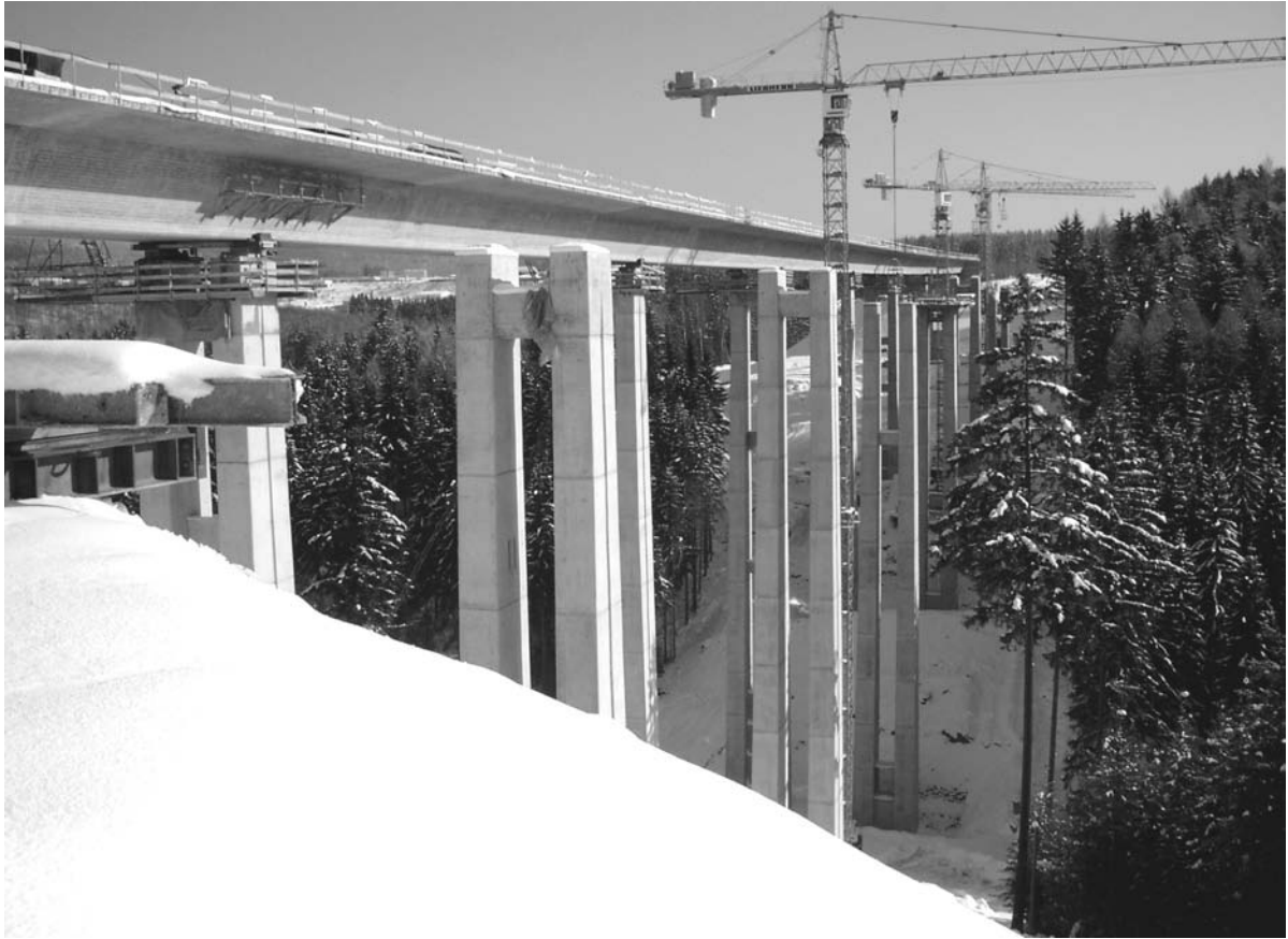
Bild 1.12: Talbrücke Langer Grund, BAB A 73
