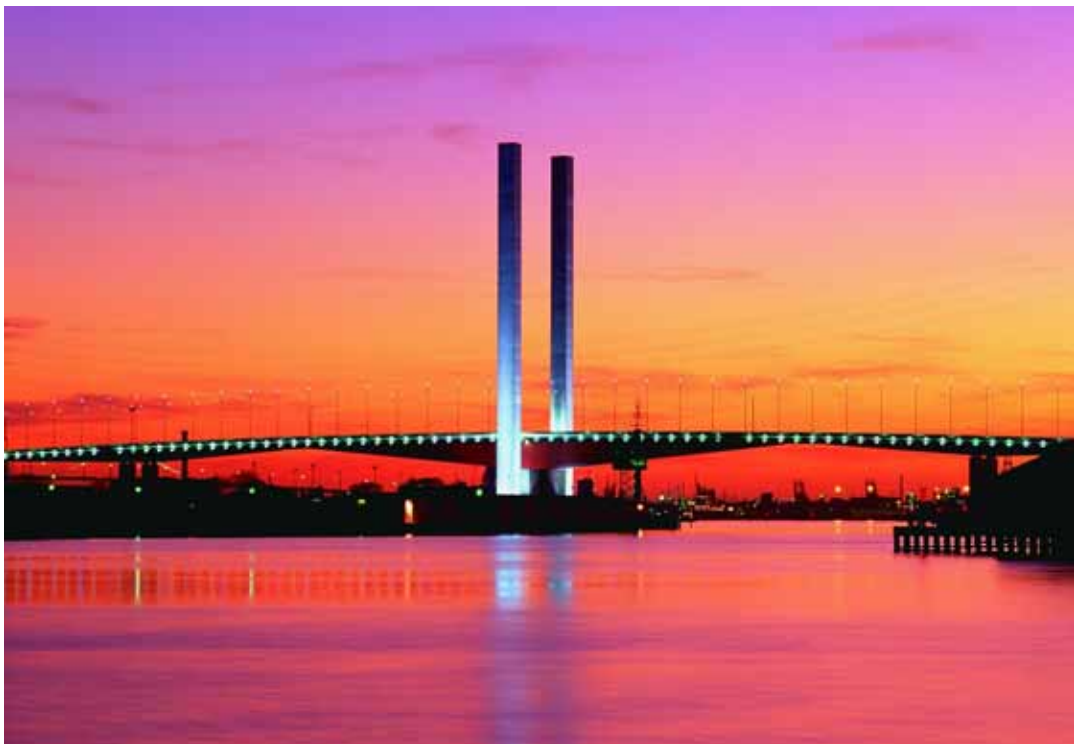
Bild 3.3: Ansicht der fertiggestellten Freivorbaubrücke über den Yarra River, Melbourne
