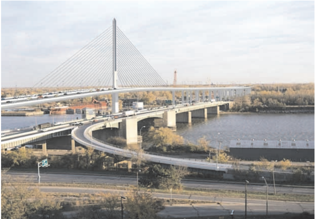
Bild 3.11: Maumee River Bridge mit Hauptbauwerk, Vorlandbrücken und bestehender Klappbrücke; Computersimulation [12]
