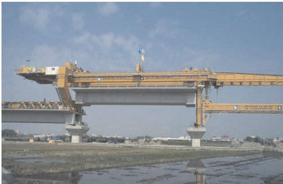
Bild 3.6: Taiwan High Speed Rail; Komplettfertigteile über 35 m Stützweite als Spannbetonhohlkasten
