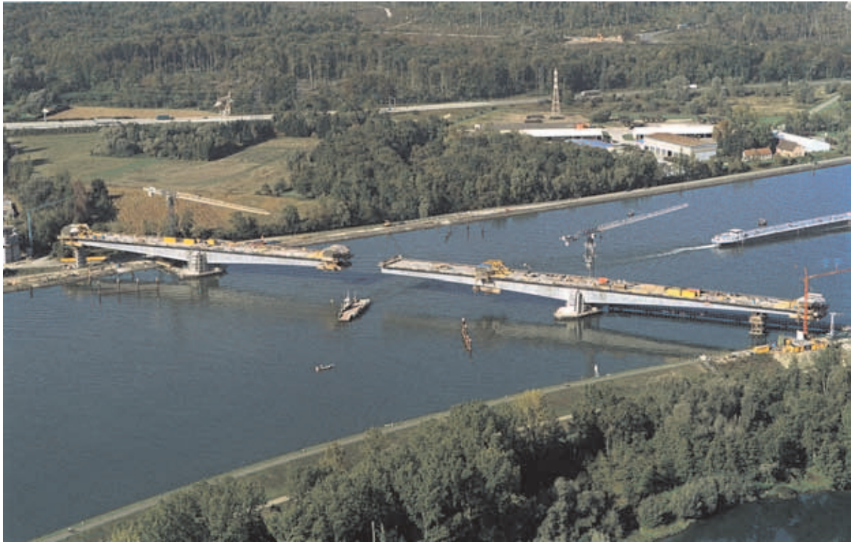
Bild 3.1: Die neue Rheinquerung bei Straßburg; Spannweite 205 m (Freivorbau in hochfestem Beton)
