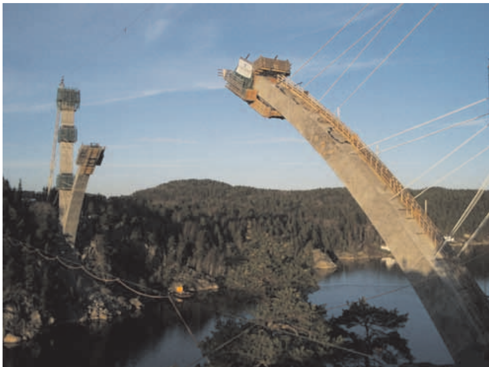
Bild 3.8: Herstellung des Bogens mit abgespanntem Freivorbau und Hilfspylonen
