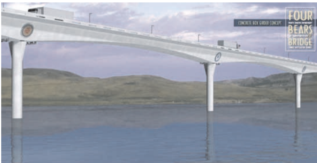
Bild 3.5: Die Four Bears Bridge, North Dakota, als Segmentfertigteilbrücke im Freivorbau [10]
