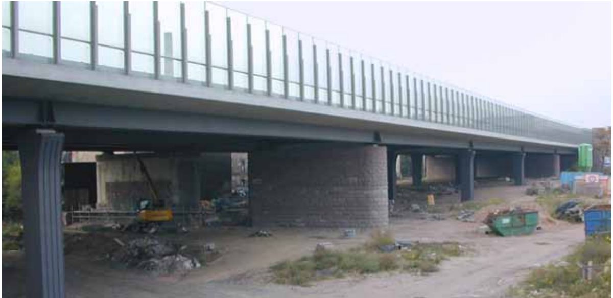
Bild 11.11: Ansicht der Brücke im Bauzustand
