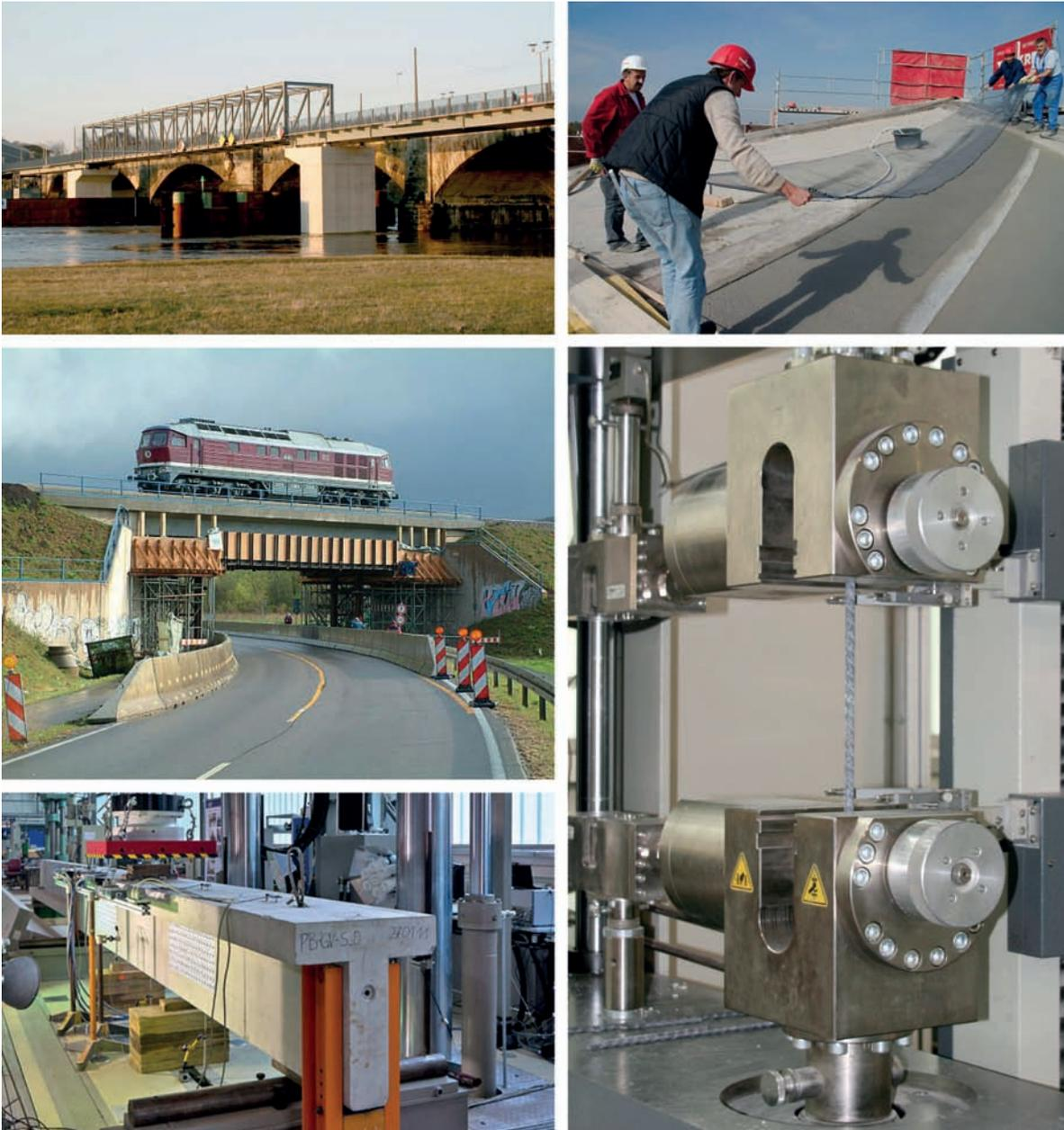
**Bild 1.7:** Wege zum Erhalt unserer Bauwerke; linke Seite, oben: Albertbrücke in Dresden und Behelfsbrücke für Fußgänger und Radfahrer während der Sanierung; Mitte: Belastungsprobe einer Eisenbahnbrücke nach der Sanierung; unten: Tragfähigkeitstest eines für Querkraft verstärkten Plattenbalkens bei 2 Mio. Lastwechseln; rechte Seite, oben: Verstärkung einer Hyparschale mit Textilbeton; unten: Materialprüfung an einem Spannstahl
