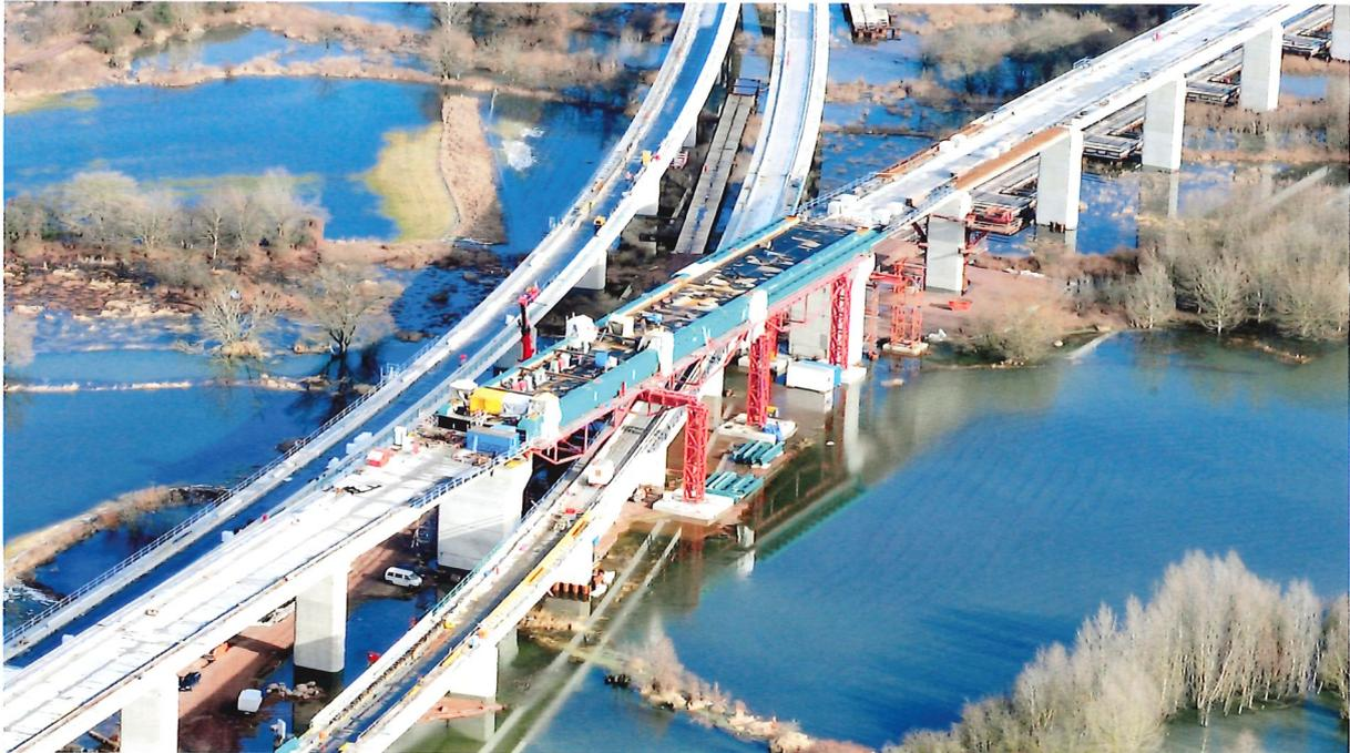
**Bild 10.11:** Montage von Fahrbahn und Versteifungsträger (Foto: DB AG)
