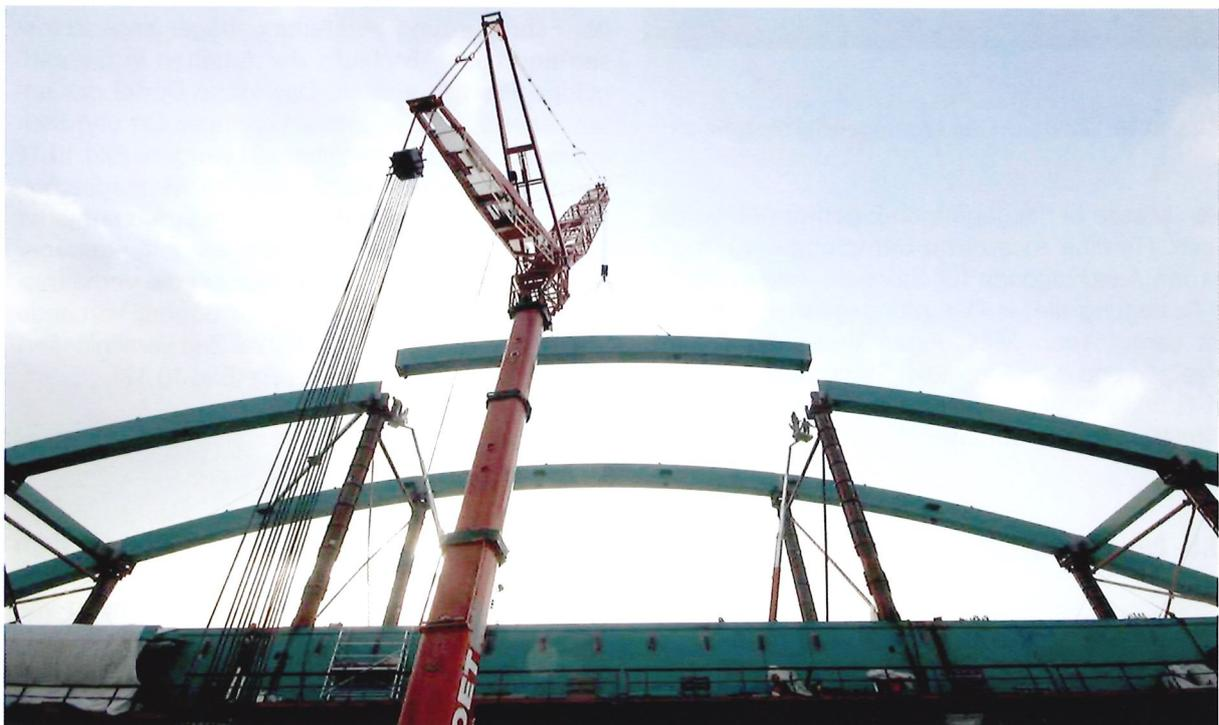
**Bild 10.12:** Bogenmontage (Foto: DB AG)
