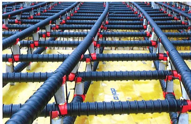
**Bild 13.6:** Spanngliedführung im Tragwerk und Detail Abstandhalter (Foto: TU Wien)
