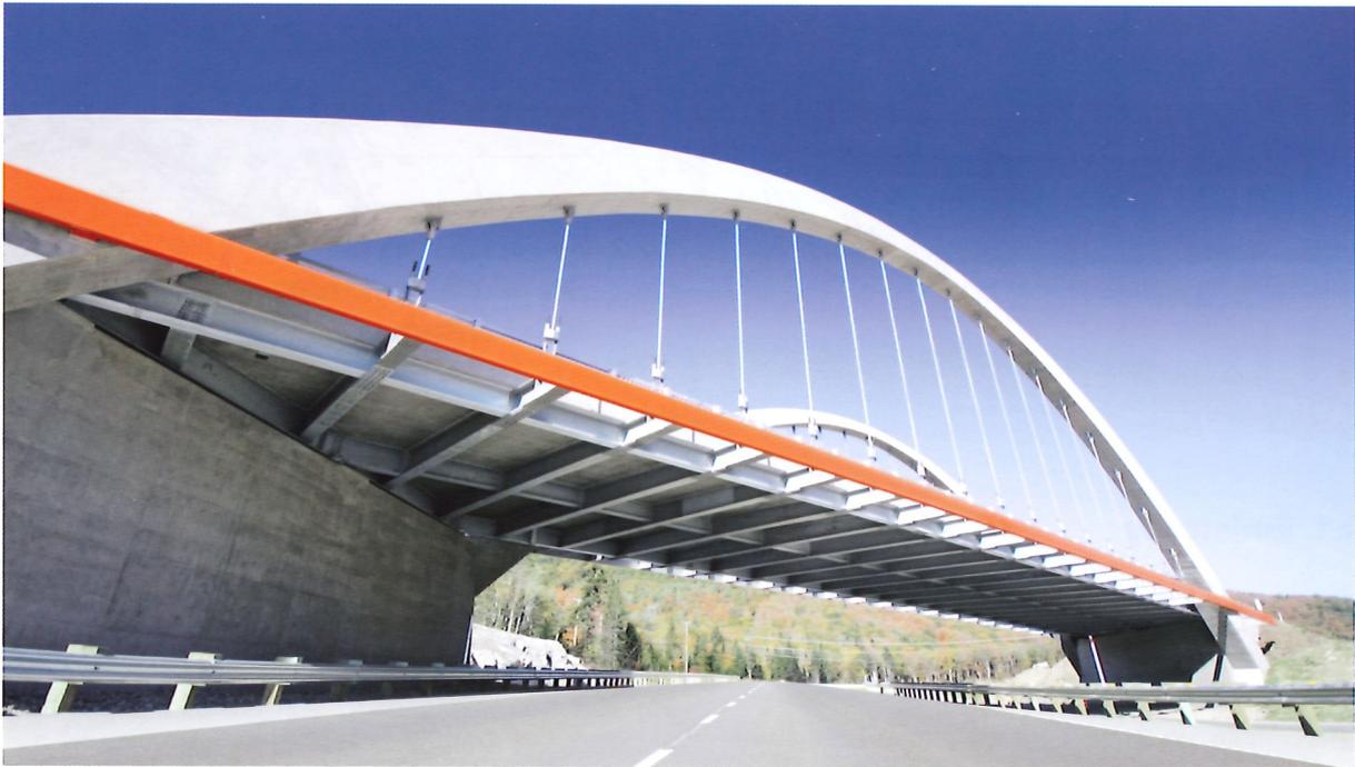
**Bild 14.1:** An der Stoneham-Brücke in Quebec kamen feuerverzinkte Stahlbauteile und feuerverzinkter Bewehrungsstahl zum Einsatz. (Foto: American Galvanizers Association)
