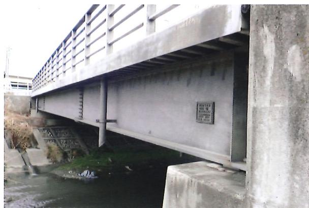
**Bild 14.6:** Baujahr 1964: Die feuerverzinkte Shin-Nukui-Brücke (Foto: HDGASA)
