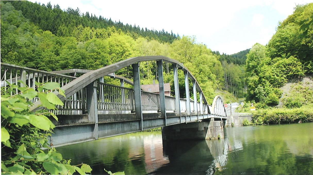
**Bild 14.7:** Baujahr 1987: Die feuerverzinkte Hölmecke-Brücke (Foto: Institut Feuerverzinken)
