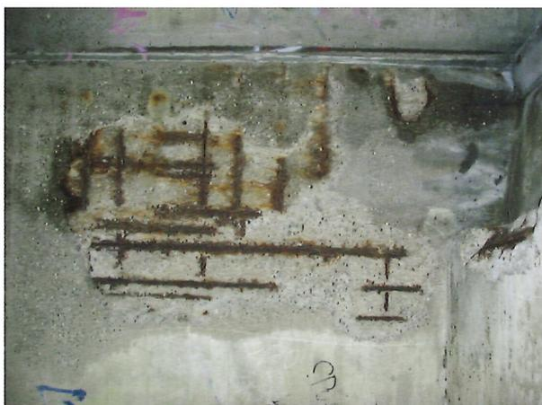
**Bild 14.9:** Bewehrungskorrosion unter einer Autobahnbrücke der A 661 bei Frankfurt (Foto: Karl-Heinz Wellmann)
