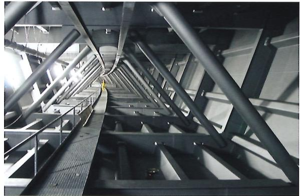
**Bild 17.9:** Stahlhohlkasten der Talbrücke Nuttlar
