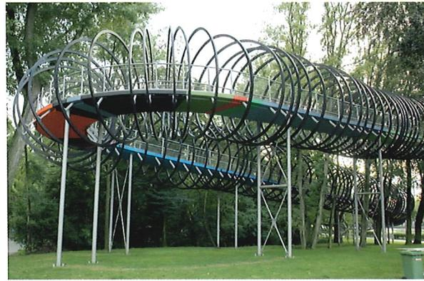
**Bild 17.14:** Spannbandbrücke, Slinky Springs to Fame
