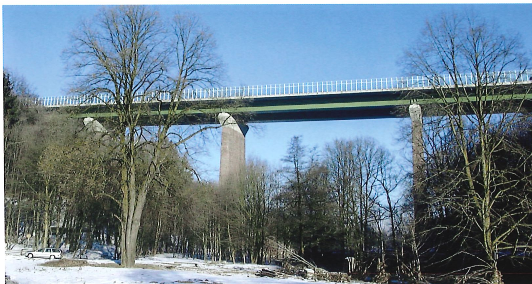
Bild 3.1: Muldebrücke Siebenlehn, BAB 4 (Foto: DEGES)
