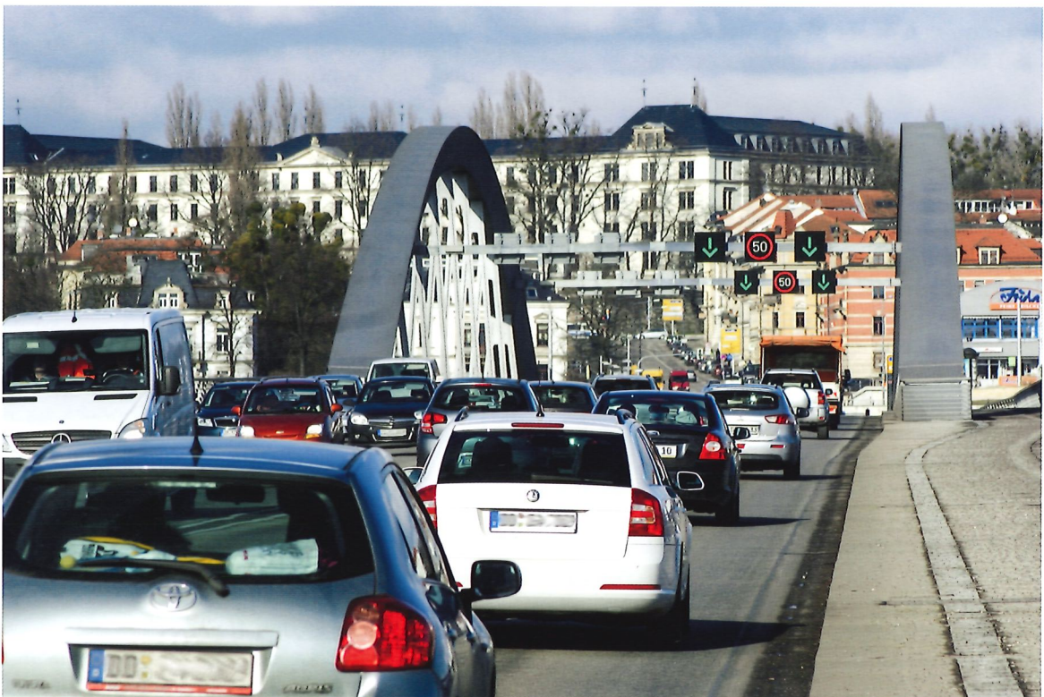
Bild 3.23: Waldschlösschenbrücke Dresden unter Verkehr (Foto: Jürgen Stritzke)
