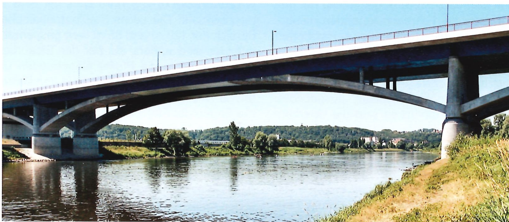
Bild 3.3: Elbebrücke Pirna, S 177 (Foto: Jürgen Stritzke)
