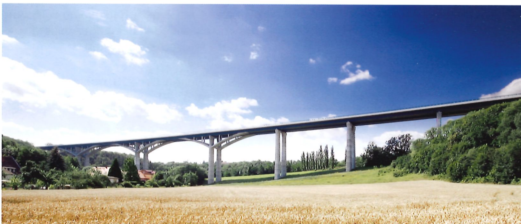
Bild 3.4: Lockwitztalbrücke, BAB 17 Dresden–Prag (Foto: LAP CONSULT)
