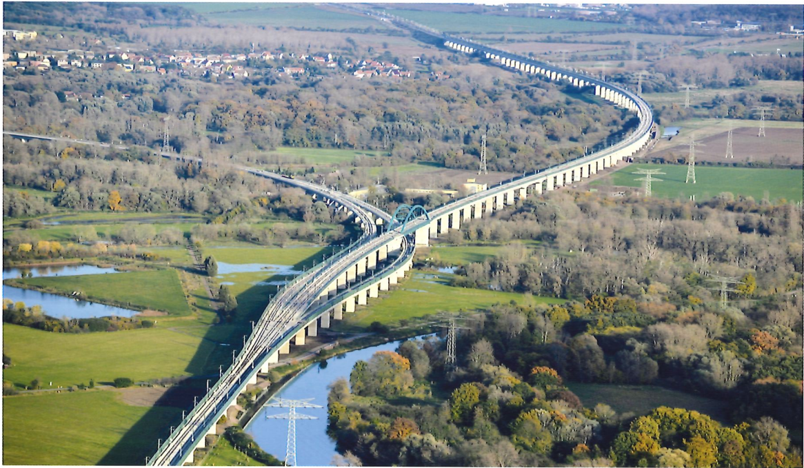
Bild 3.20: Saale-Elster-Talbrücke, NBS Erfurt–Halle/Leipzig (Foto: DB AG)
