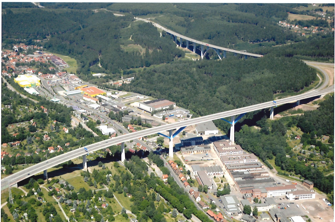
Bild 3.8: Haseltalbrücke, BAB 73 (Foto: DEGES ari)
