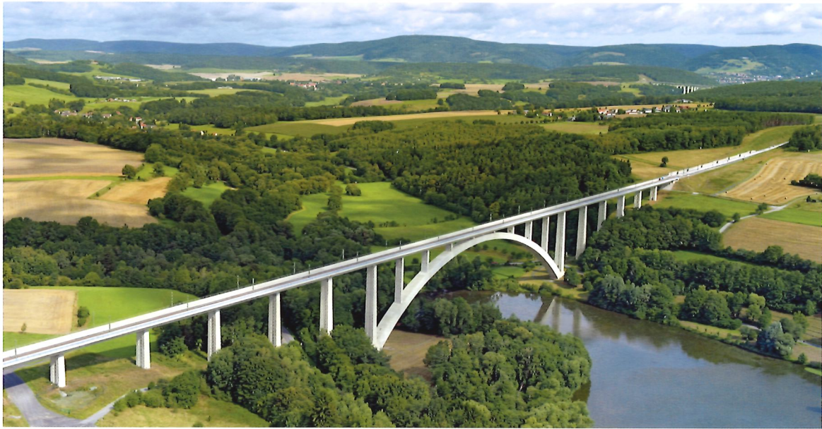
Bild 3.14: Talbrücke Froschgrundsee – NBS Ebensfeld–Erfurt (Foto: Hajo Dietz, Nürnberg)
