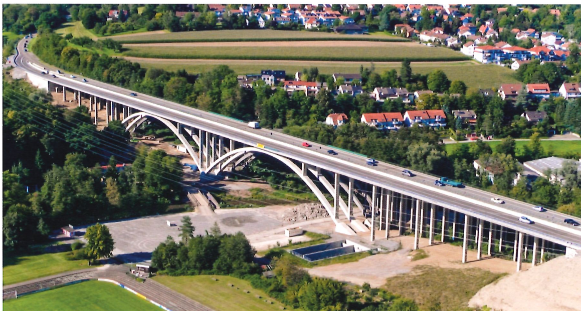
Bild 3.18: Murrtaalbrücke, B 14 (Foto: Max Bögl)
