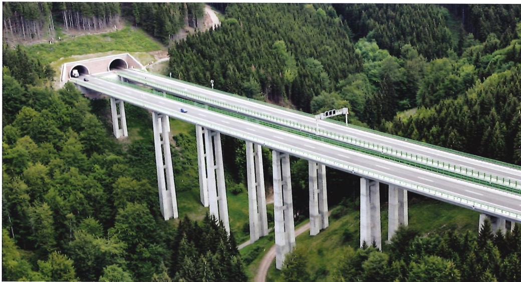
Bild 3.2: Schwarzbachtalbrücke, BAB 71 (Foto: DEGES ari)
