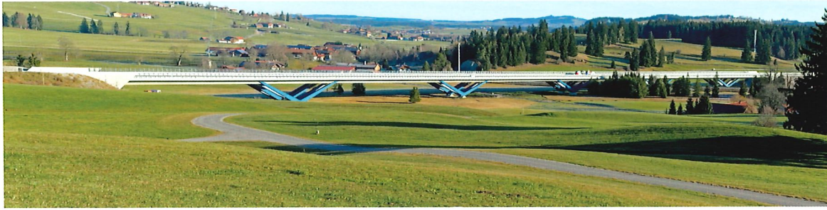
Bild 3.11: Talbrücke Enzenstetten (Foto: Autobahndirektion Südbayern)
