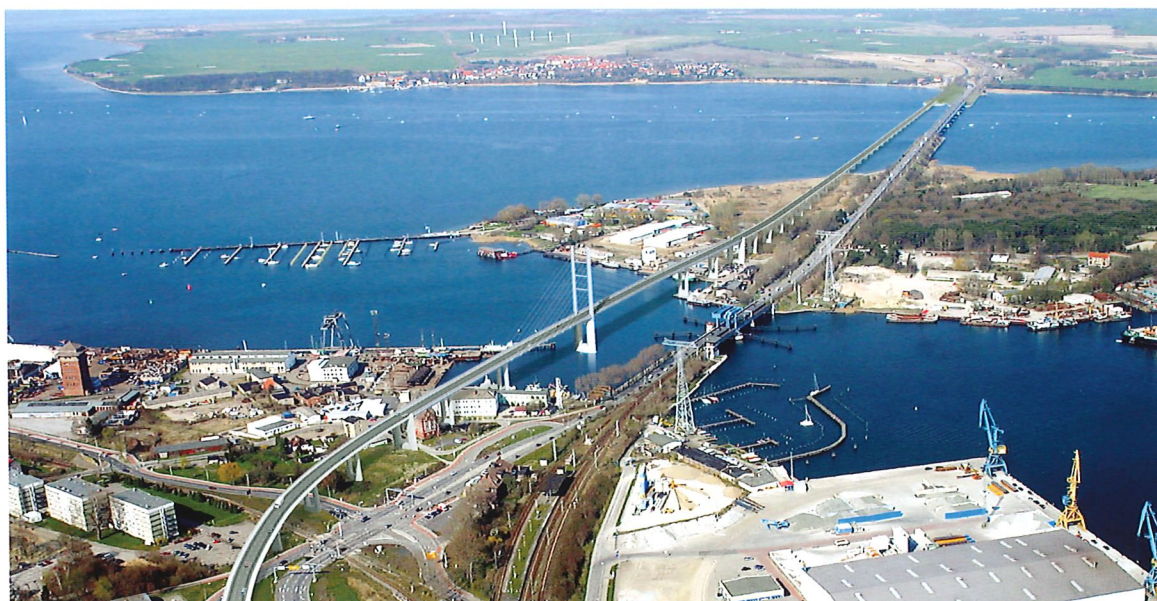
Bild 3.9: Strelasundquerung – Tor nach Rügen (Foto: DEGES)
