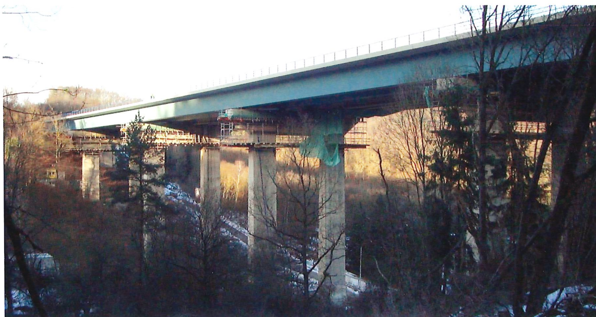
Bild 3.17: Talbrücke Windelbach, BAB 45 (Foto: Donges-SteelTec GmbH)
