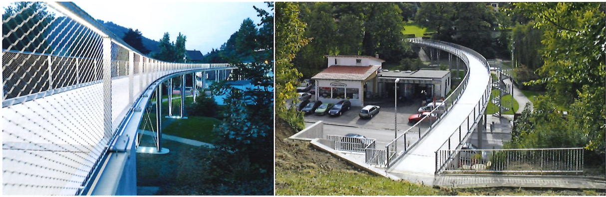
Bild 6.1: Ansicht der neuen Textilbetonfußgängerbrücke in Albstadt [Foto: Groz-Beckert]
