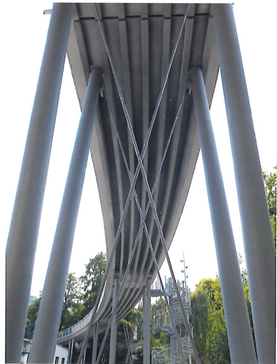
Bild 6.21: Fertigteilbrücke während der Montage [Foto: Groz-Beckert]
