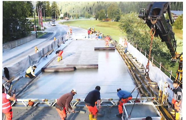
**Bild 7.19:** Gesamtübersicht, Herstellung Textilbetonschicht (BA2) (Foto: Mario Hansl)
