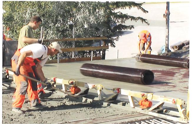
**Bild 7.17:** Arbeiten mit Abziehbohle (BA1) (Foto: Mario Hansl)
