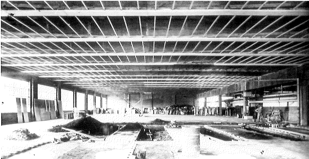
Bild 8.6: Textilfabrik mit Dachträgern aus Spannbeton im nachträglichen Verbund (1947-1948) [14]
