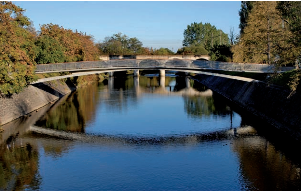
Bild 6: Fußgängerbrücke über den Fluss Svatka in Brno, Tschechien, entworfen von Jirí Straský
