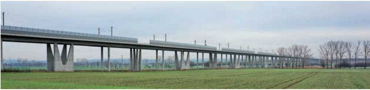
Bild 2: Eisenbahn-Hochgeschwindigkeitsbrücke Gänsebachtal, entworfen von Jörg Schlaich
