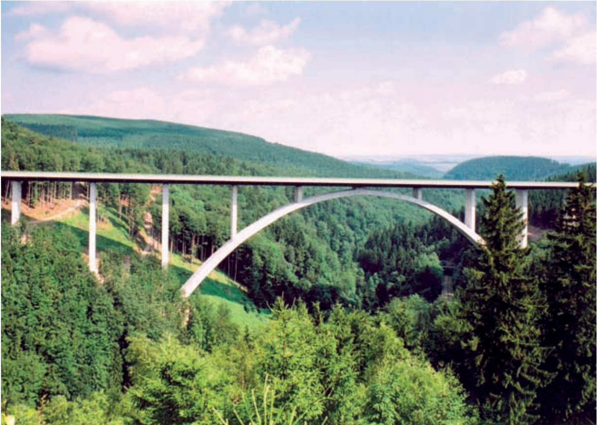
Bild 5: BAB A 71, Talbrücke Wilde Gera; Deutscher Brückenbaupreis 2006 in der Kategorie Straßen- und Eisenbahnbrücken (Foto: Foto Schüler, Zella-Mehlis)
