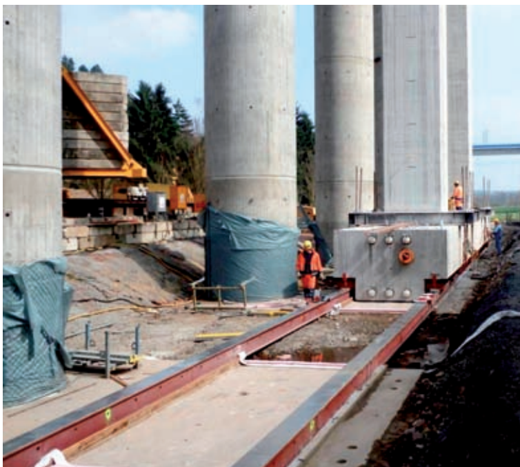
Bild 14: Querverschub der Hilfspfeiler
