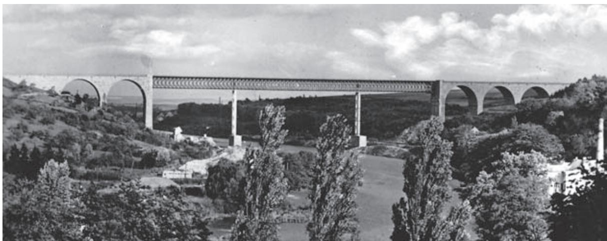
Bild 2: Lahntalbrücke mit Behelfsbrücke
