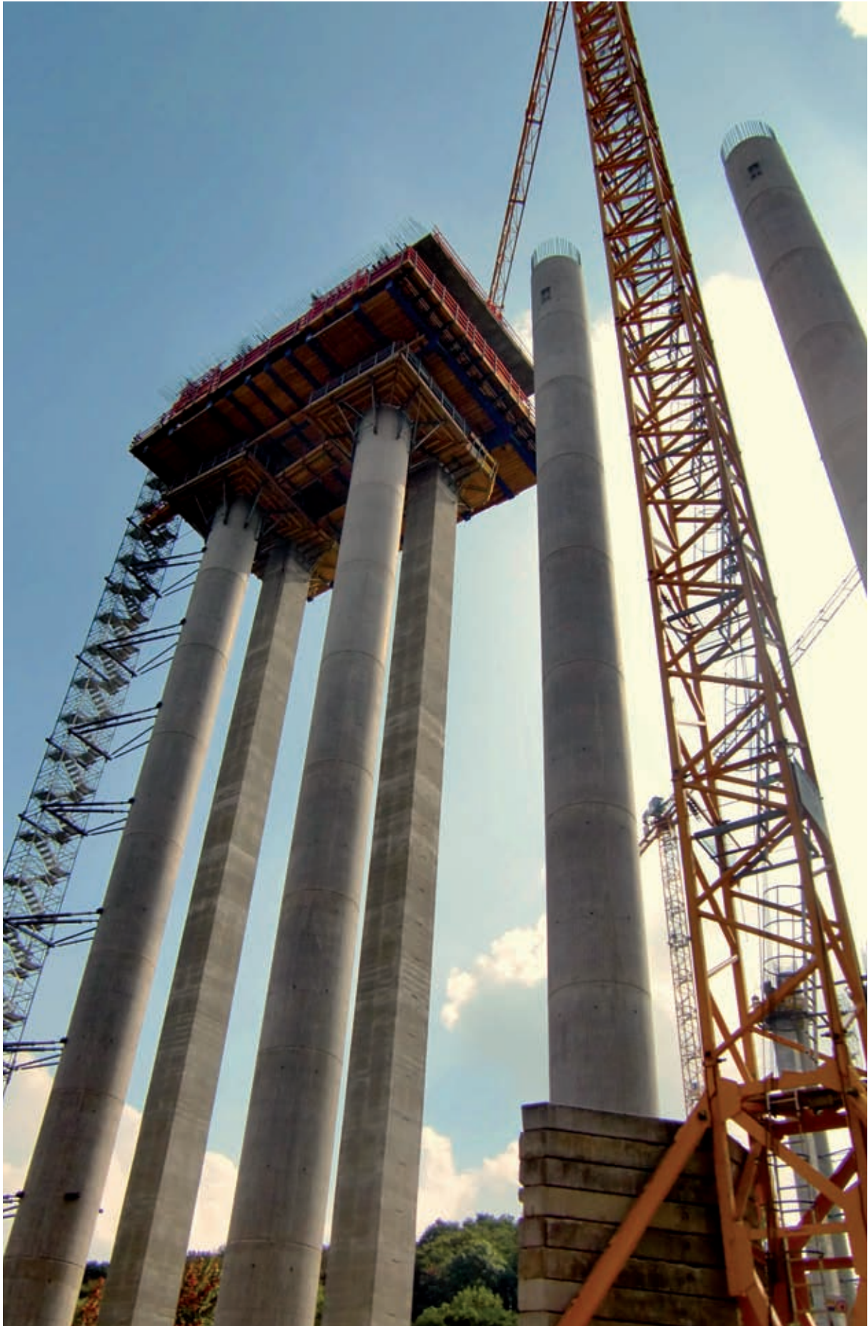
Bild 15: Herstellung der Pfeilertische in 60 m Höhe
