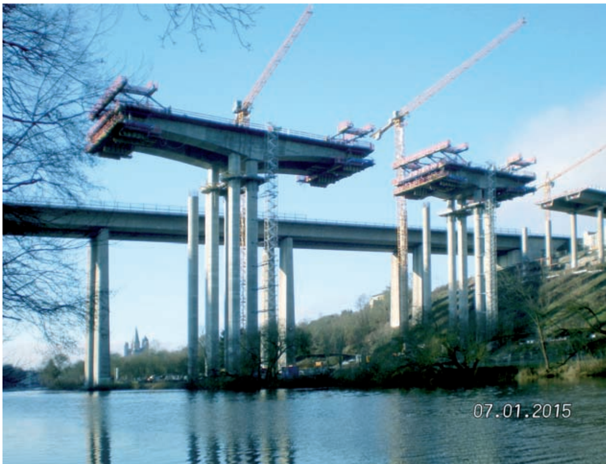
Bild 16: Freivorbau am nördlichen Lahnufer
