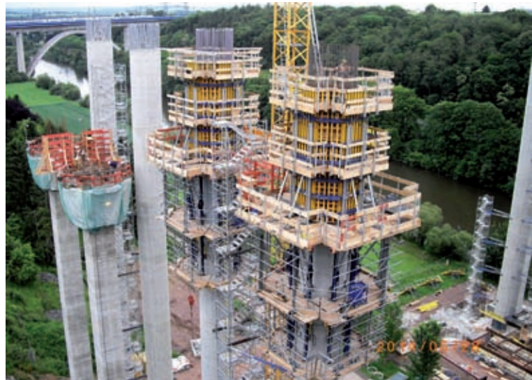
Bild 12: Pfeilerherstellung mit Kletterschalung und Gleitschalung (links)
