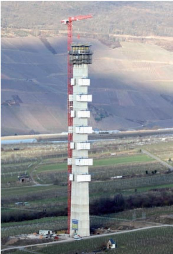
Bild 27: Windabweiser am Pfeiler Achse 6
