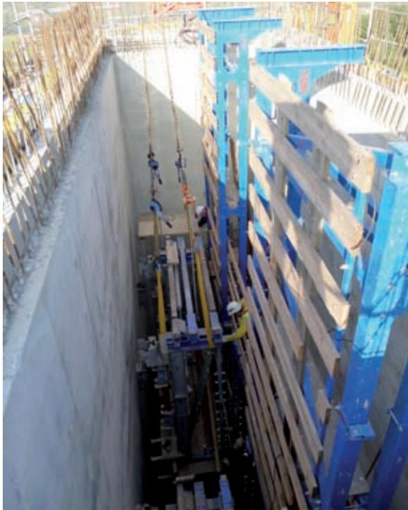
Bild 13: Ausbau Innenbühne am Pfeilerkopf
