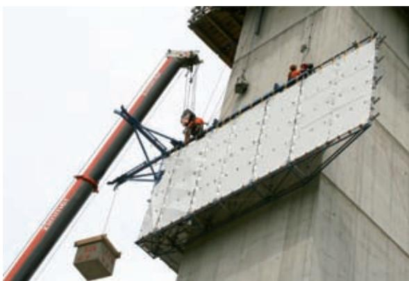
Bild 25: Einheben eines Windabweisers mit Kontergewicht
