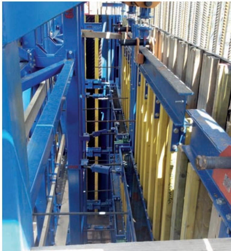
Bild 20: Arbeitsraum hinter der Innenschalung
