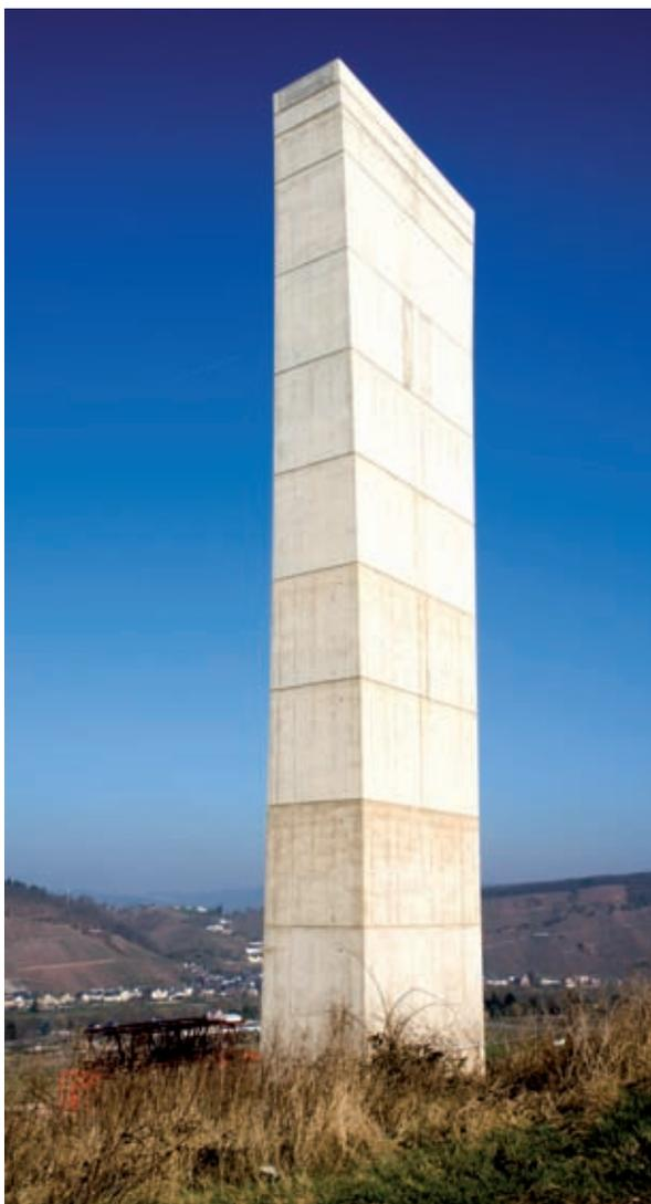
Bild 8: Oberflächenqualität des Betons
