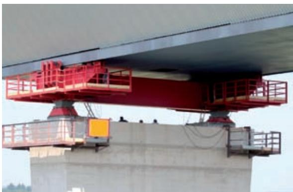
Bild 3: Verschiebbalken auf Pfeiler Achse 09
