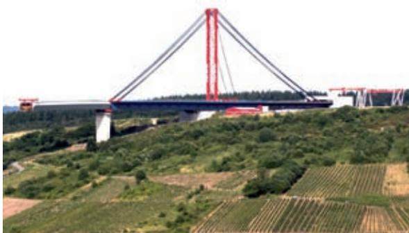
Bild 2: Überbau mit Hilfspylon, Stand Juni 2015
