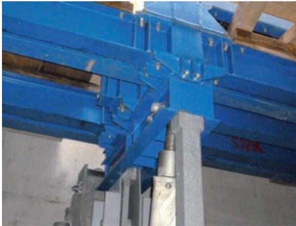
Bild 17: Drehlager unter Innenbühne
