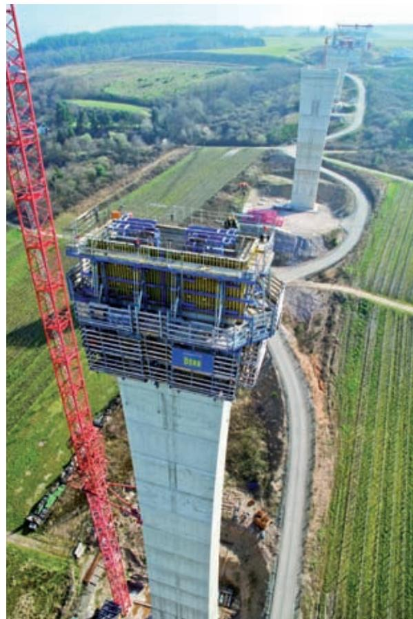
Bild 10: Kletterschalung am Pfeilerkopf
