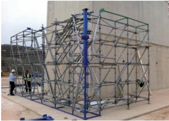
Bild 24: Montage der Windabweiser am Boden
