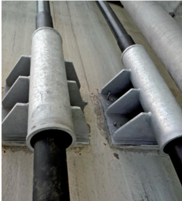
Bild 18: Umlenkung Typ F, Stahlumlenteil mit innenliegenden Hülsen (Zeichnung und Foto: Annette Jarosch, BBV)
