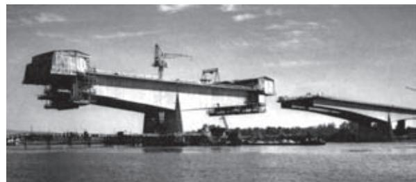
Bild 27: Freivorbau der Brücke Bendorf
