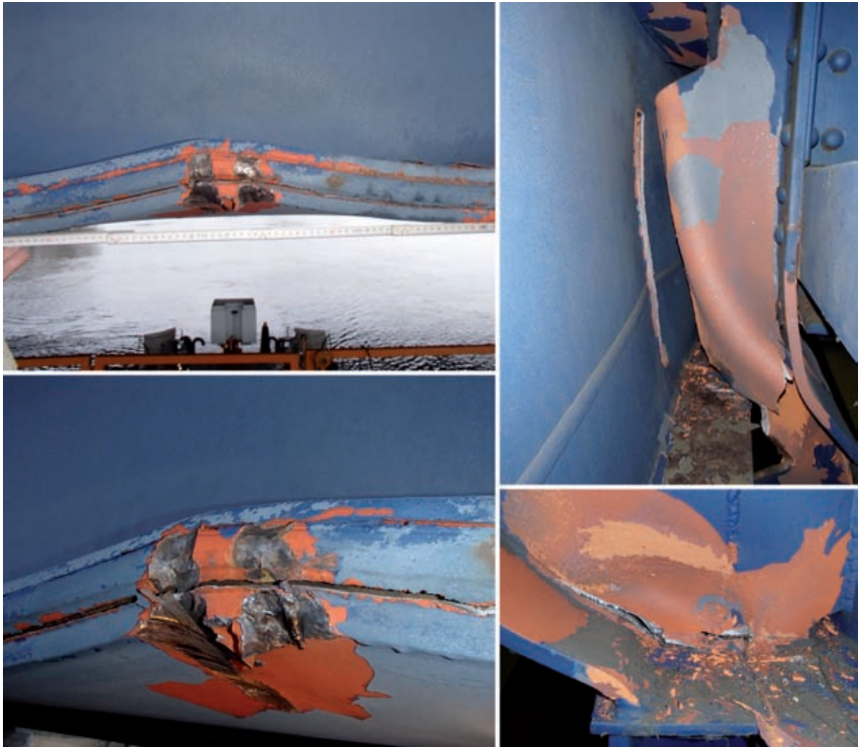
Bild 4: Schäden an Flansch und Aussteifungselementen
