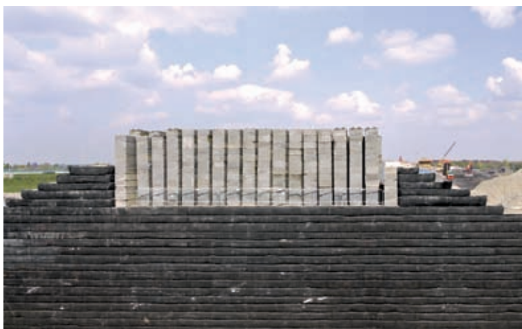
Bild 7: Vorbelastung eines KBE-Brückenwiderlagers an der Autobahn A 74, NL (Foto: Ralf Beuker, bearbeitet von Julia Klaverkamp, HUESKER)
