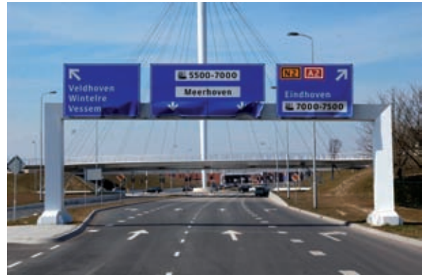
Bild 18: Beschädigtes Zufahrtsportal (© ipv Delft)
