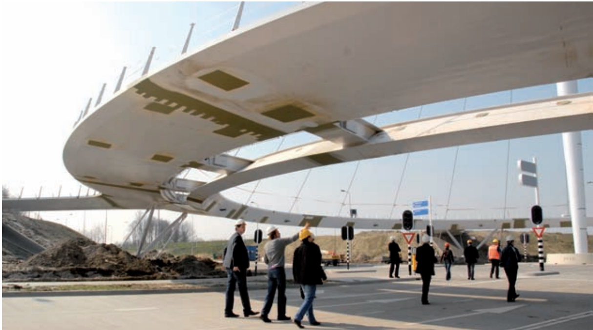
Bild 31: Brückendeck während der Realisierung
