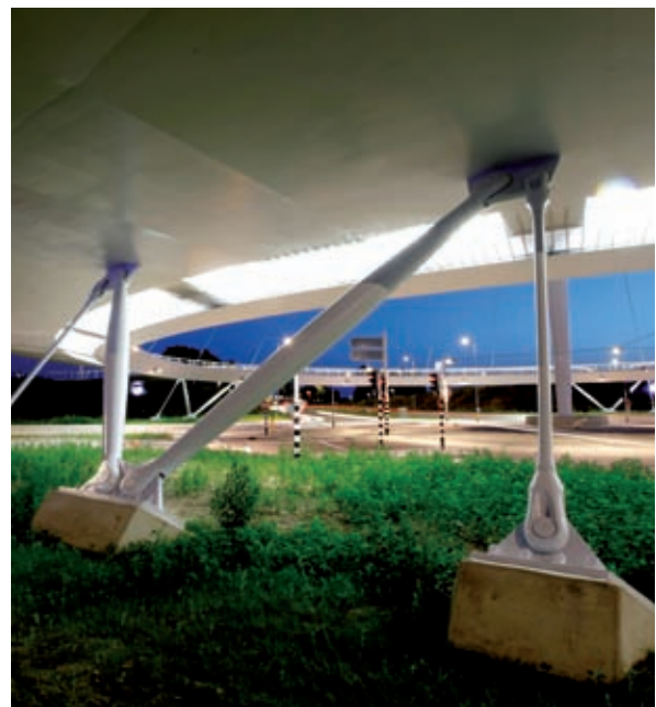
Bild 22: M-förmige Befestigungen – Realisierung
