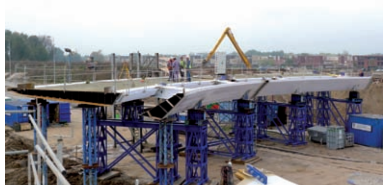
Bild 29: Realisation – Montage Brückendeck
