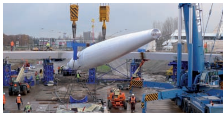
Bild 30: Realisation – Montage Pylon
