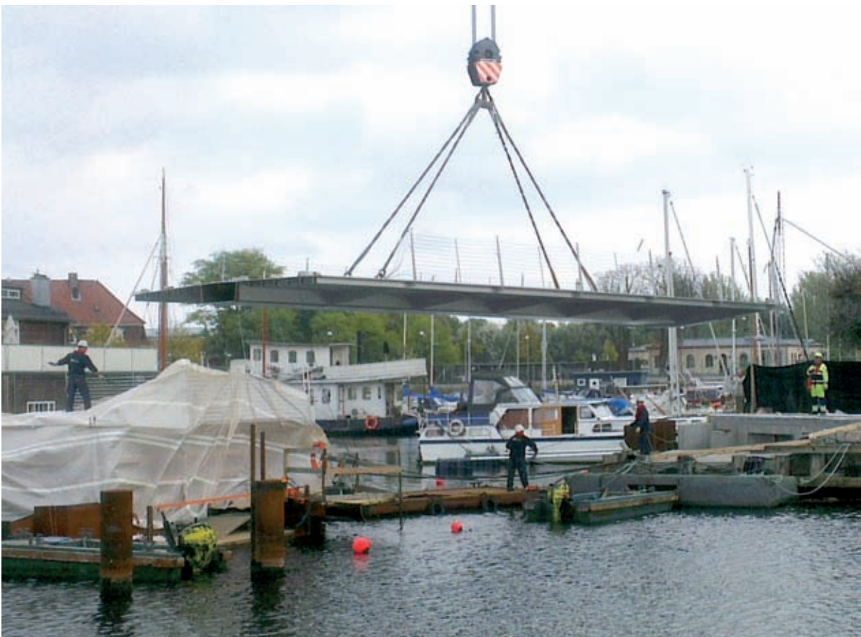
Bild 12: Montage der Brückenteile mittels Schwimmkran
