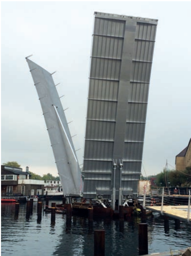
Bild 6: Brücke mit beiden Brückenklappen geöffnet (Foto: Fritz Hilgenstock)
