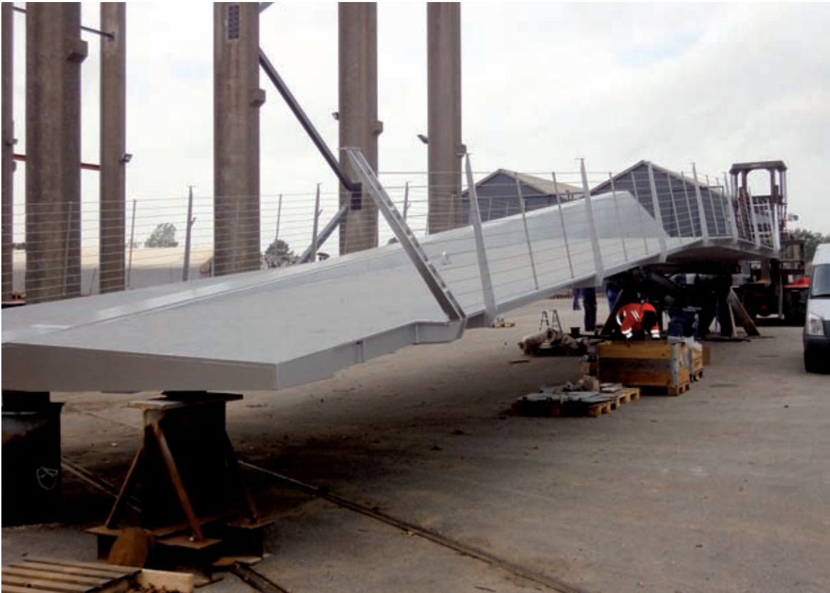
Bild 11: Fertigung der Brückenteile im Werk
