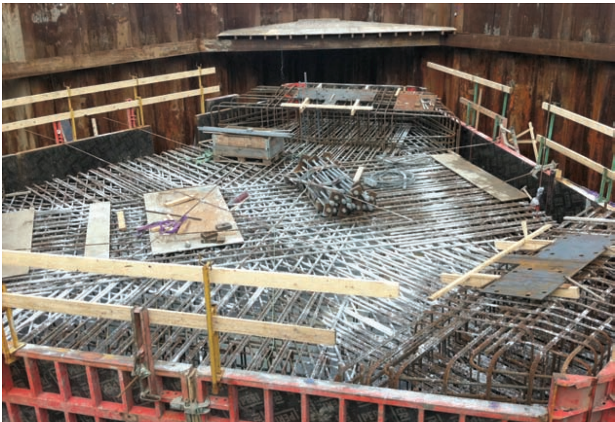
Bild 10: Herstellung der Pfahlkopfplatte der Mittelplattform
