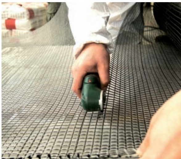
Bild 9: Händisches Zuschneiden der Bewehrung, hier: mit einem elektrischen Rollenmesser (Foto: Harald Michler)
