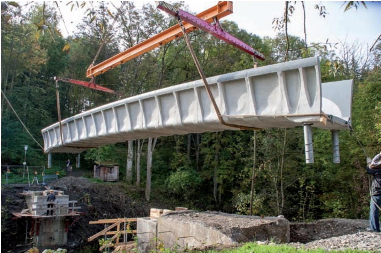
Bild 6: Brücke in Kempten – Einheben des kompletten Überbaus
