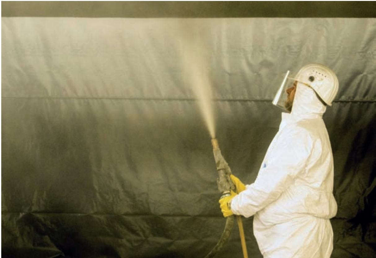
Bild 10: Sprühen des Feinbetons für eine Carbonbetonschicht
