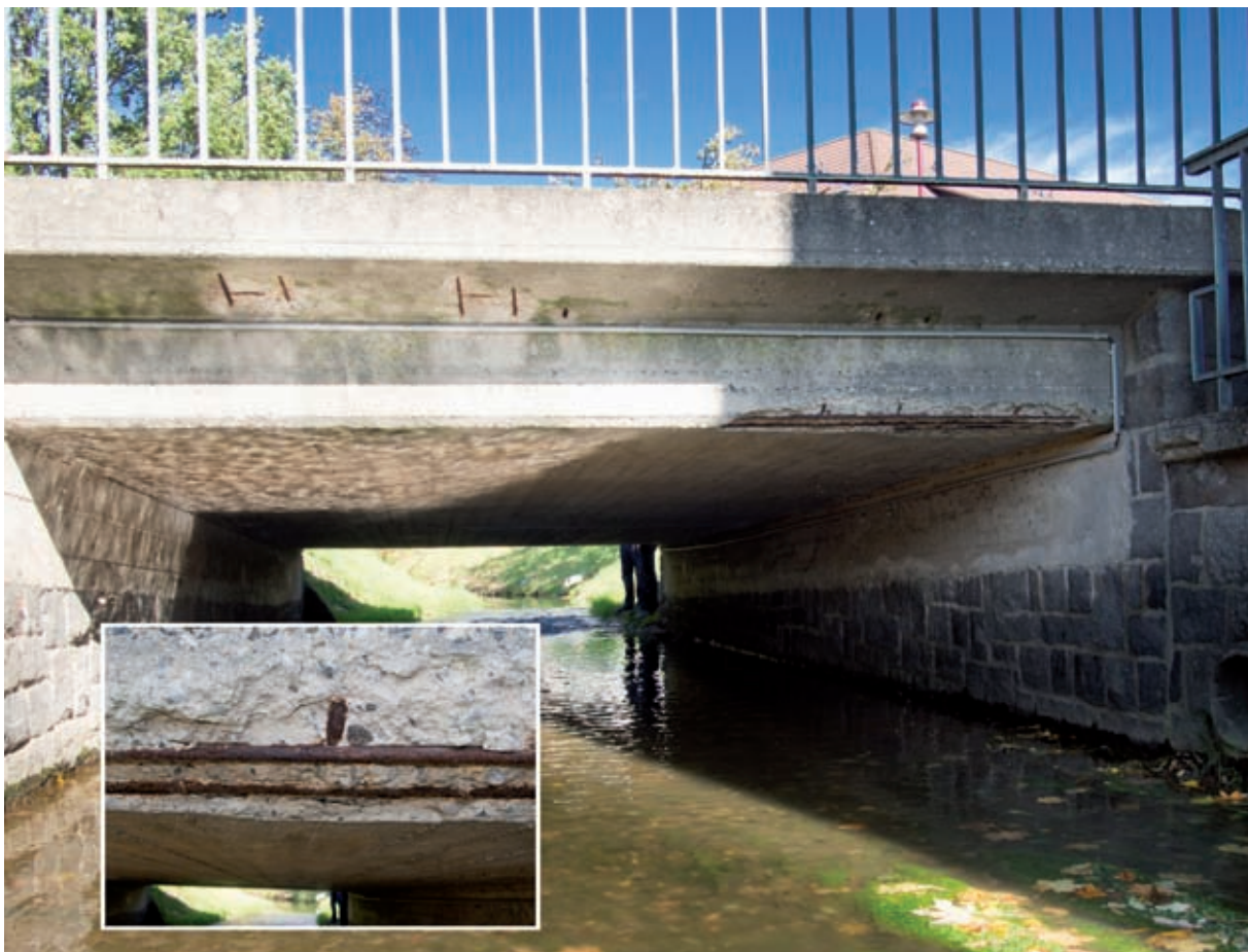
Bild 11: Brücke Bretnig (LISt) mit Detail korrodierte Bewehrung
