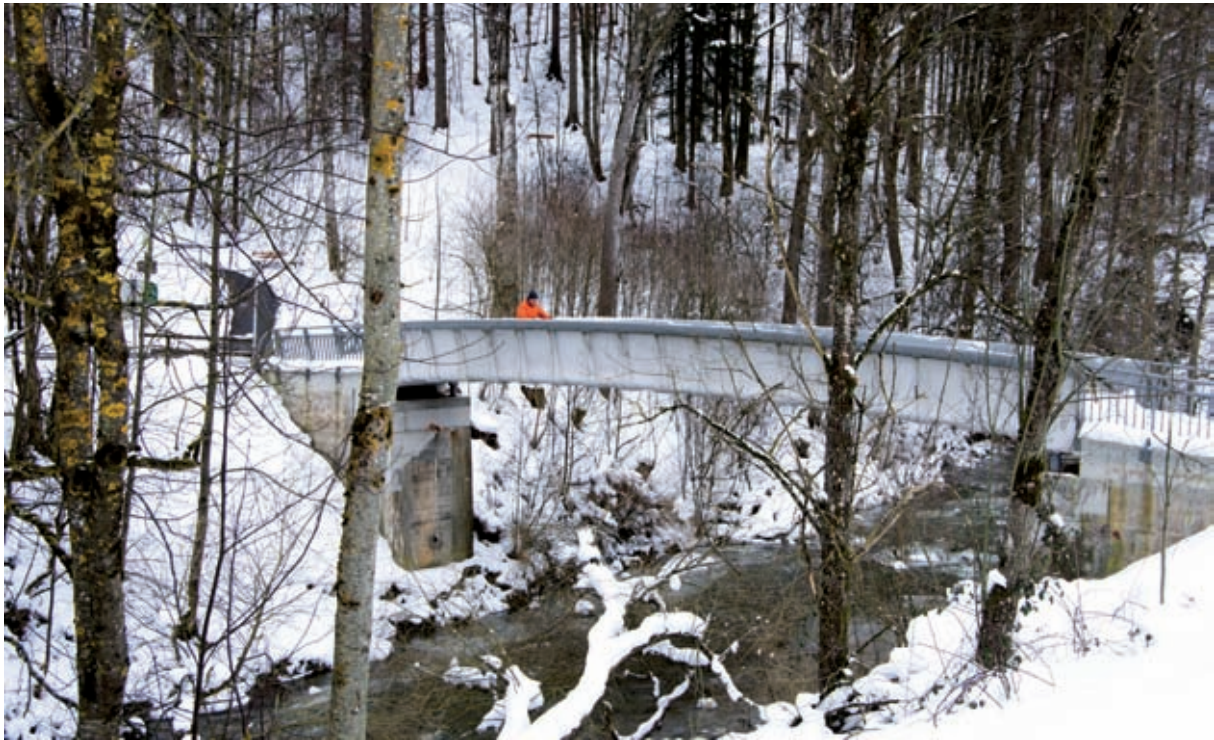
Bild 5: Brücke in Kempten
