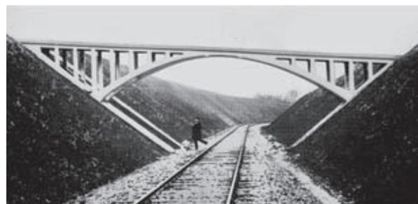
Bild 5: Frühe Bogenbrücke nach dem System Hennebique mit aufgeständerter Fahrbahn [6], dort verwiesen auf [13]
