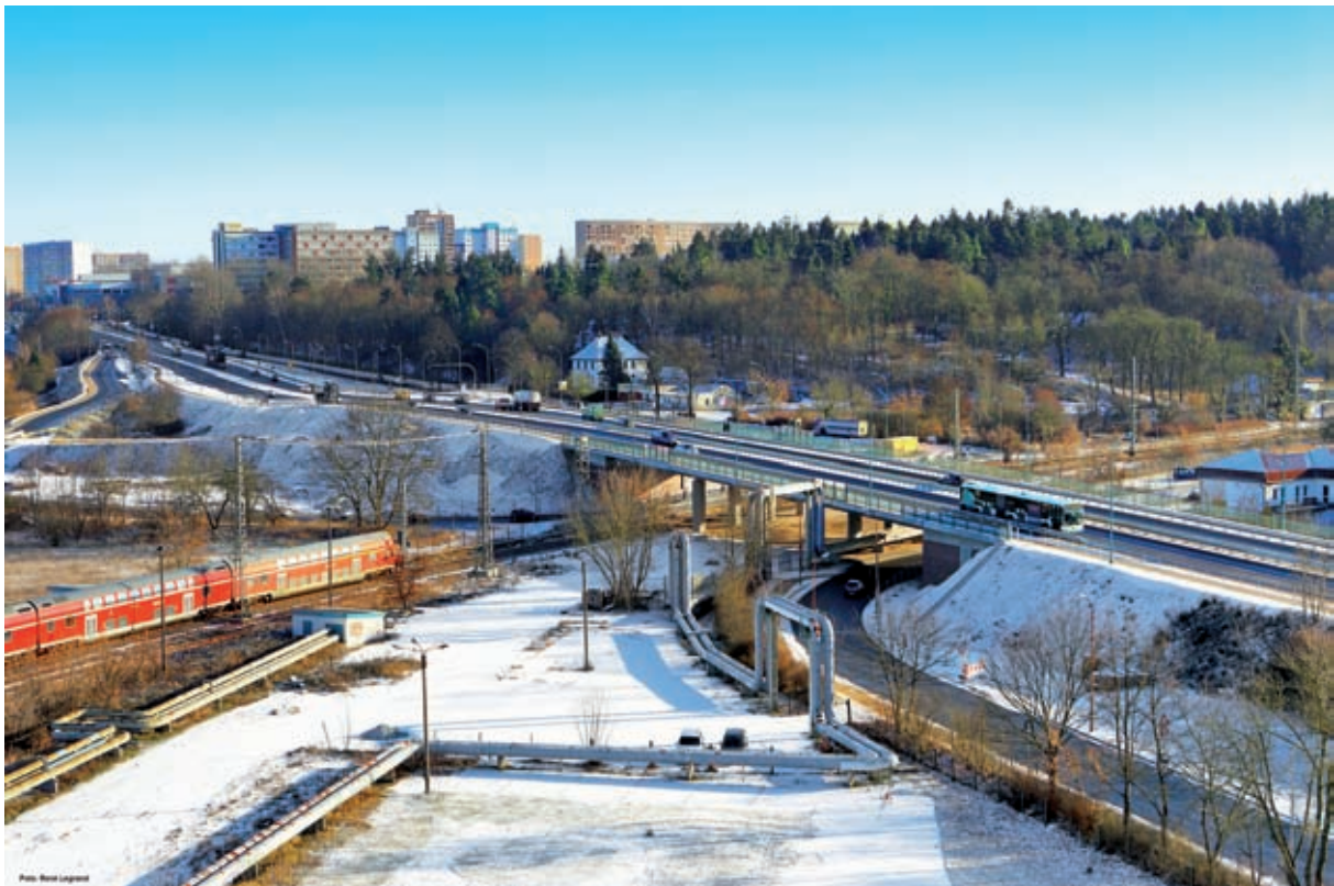
Brücke im Bauzustand
