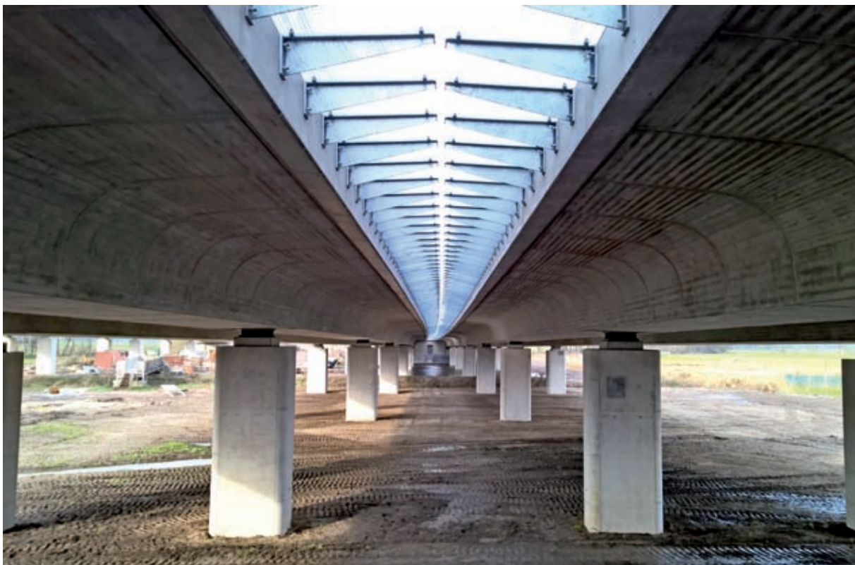
Untersicht der Brücke
