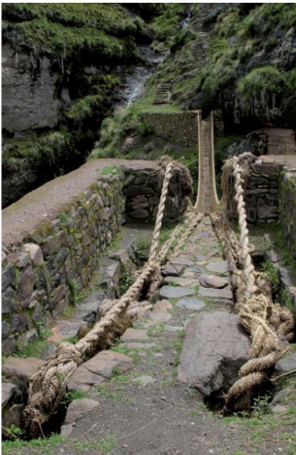
Bild 10 Die hangseitige Verankerung der Seile bei der Q'eswachaca-Brücke Foto: Dirk Bühler
