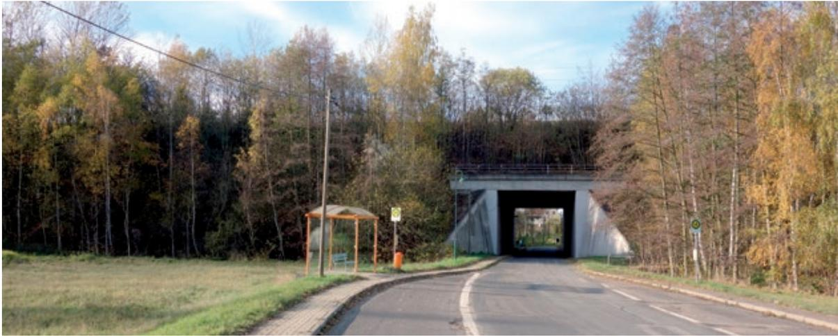
Bild 8 Das 1991 verfüllte Viadukt Crossen
