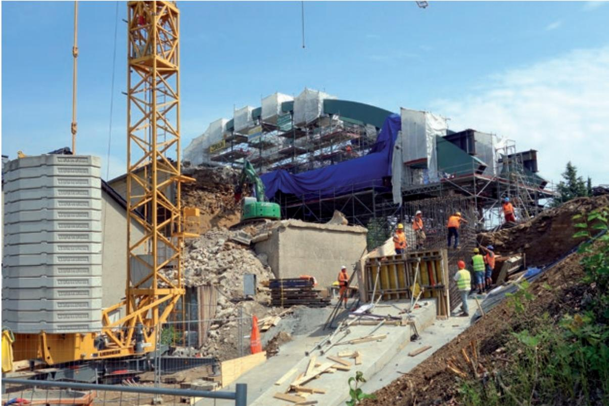
Bild 13 Baustellenimpression: Abbruch, Stahlbetonarbeiten und Stahlbauarbeiten am Überbau gleichzeitig
