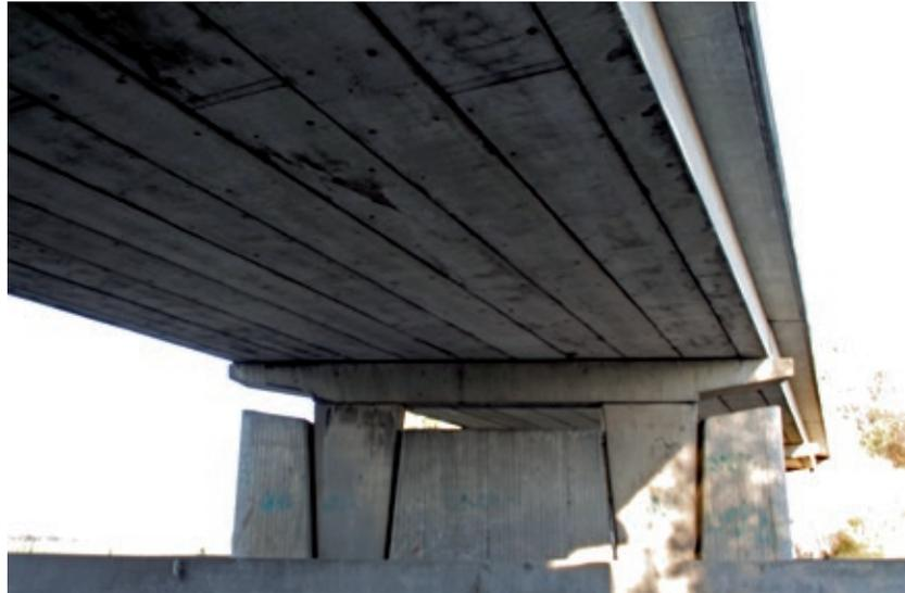
Bild 9 Untersicht einer 4feldrigen Balkenreihenbrücke über die BAB A 14 zwischen Wendischbora und Nossen (SÜ K8052)
