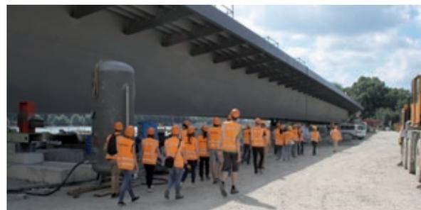
Bild 1 Schiersteiner Brücke – Vorfertigung des einzuschwimmenden Stahlbauteils an Land
