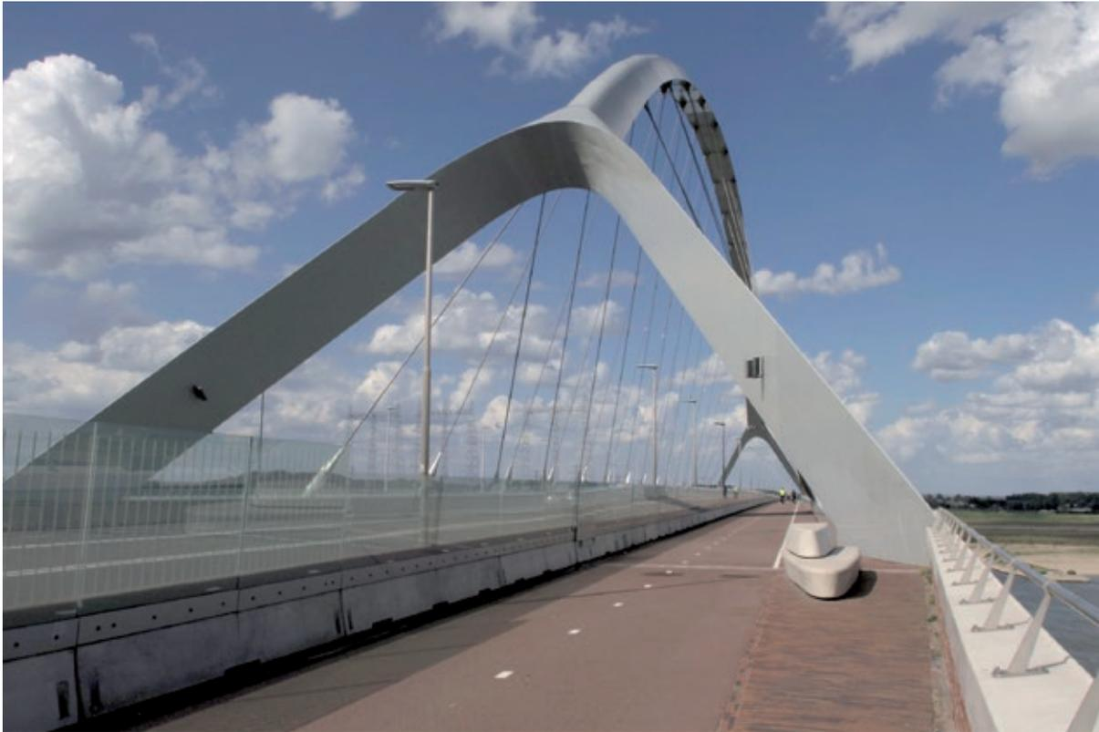
Bild 14 De Oversteek in Nijmegen – Hauptfeld mit Bogentragwerk
