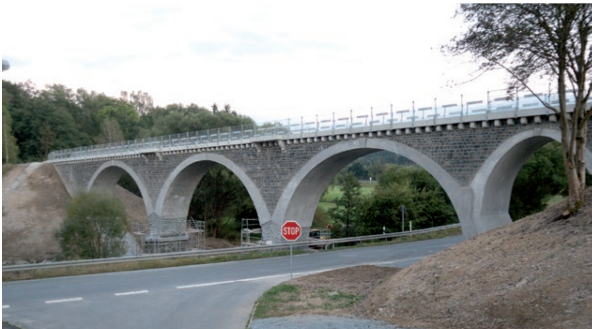
Bild 1 Mit Carbonbeton sanierte historische Betonbogenbrücke in Naila
