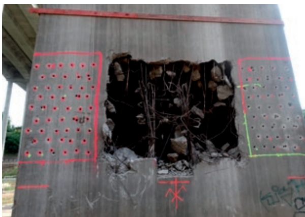
Bild 15 Front- und Stirnseite des Pfeilers mit vorbereitetem Sprengmaul und Bohrungen zum Sprengstoffbesatz
