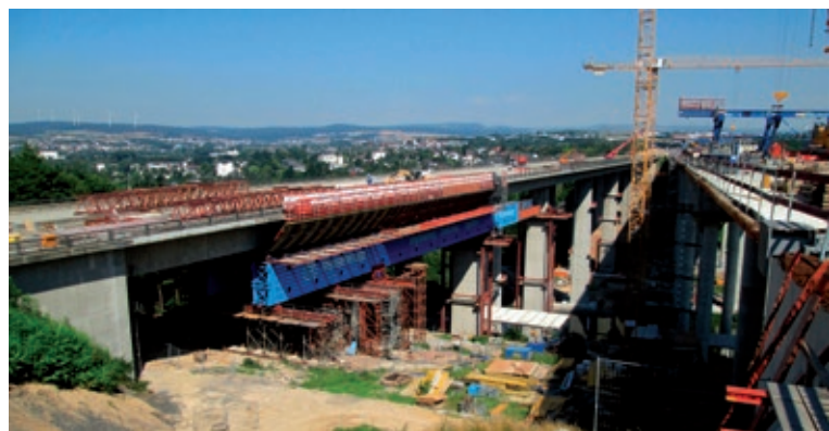
Bild 8 Fertigstellung der Vorschubrüstung mit Schutzwanne für den Abbruch des ersten Feldabschnitts von Überbaufeld 2 zu Überbaufeld 3 Foto: DEGES
