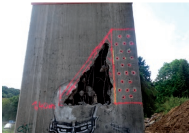
Bild 15 Front- und Stirnseite des Pfeilers mit vorbereitetem Sprengmaul und Bohrungen zum Sprengstoffbesatz
