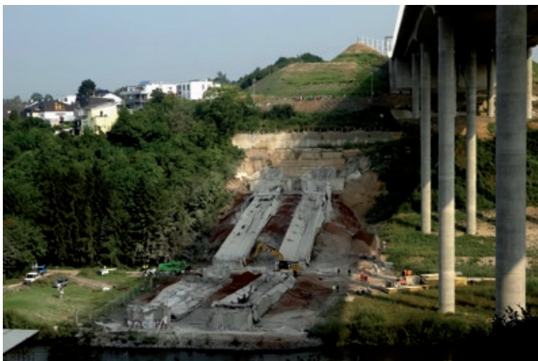
Bild 17 Ergebnis der erfolgreichen Sprengung
