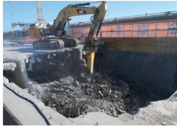
Bild 11 Rückbau des Überbaus im Schutze der Stahlwanne, die auf der Vorschubrüstung montiert ist Foto: DEGES
