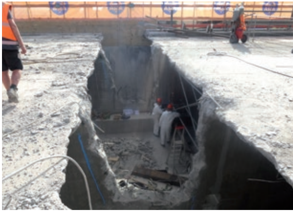
Bild 9 Arbeiten am ersten Trennschnitt im Feld 2 der Richtungsfahrbahn Köln Foto: DEGES
