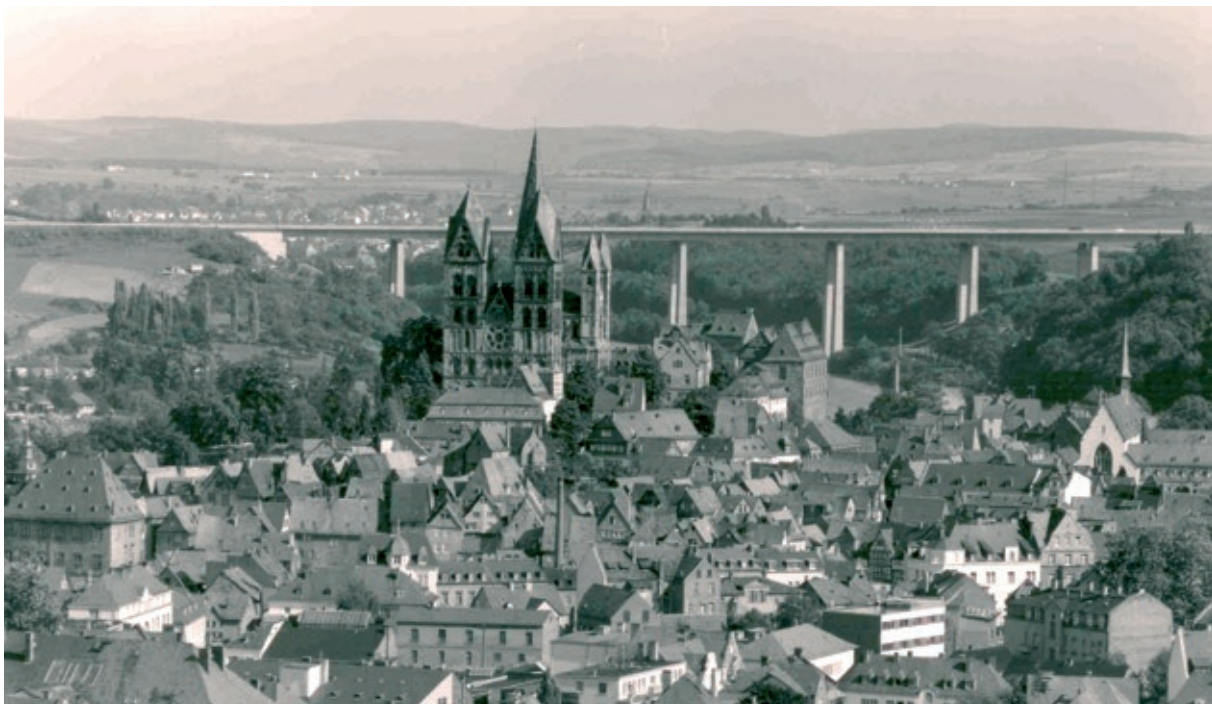
Bild 2 Ersatzbau 1964 als Spannbetonbrücke im Freivorbau errichtet
