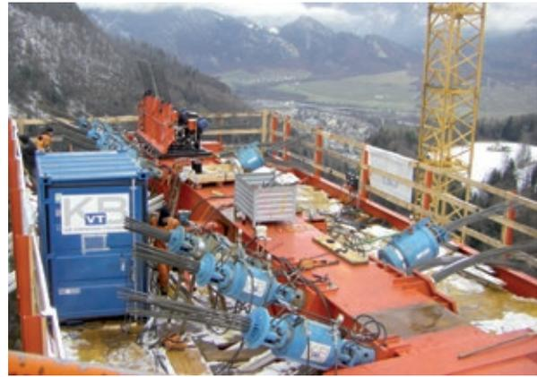
Bild 14 Spannen der Haltekabel Foto: © LAP
