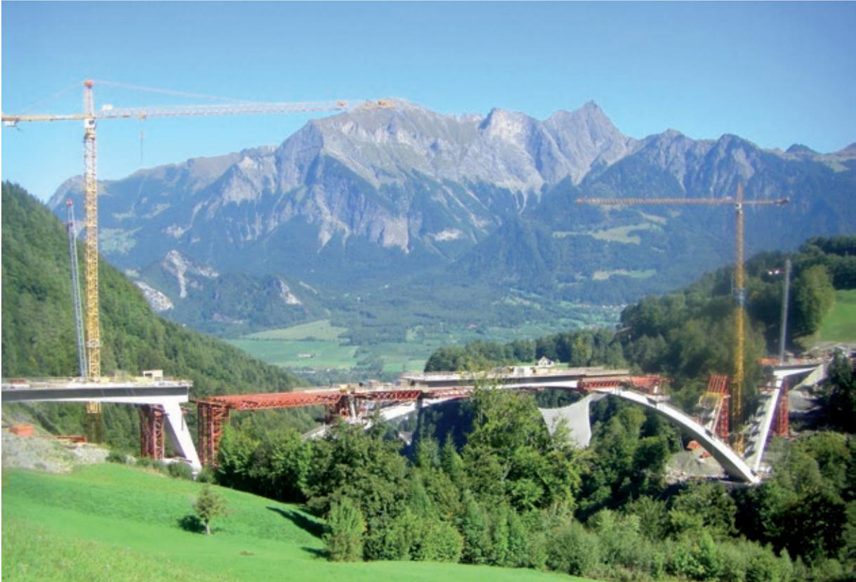
Bild 16 Herstellung des Überbaus parallel zu den Bogenständern
