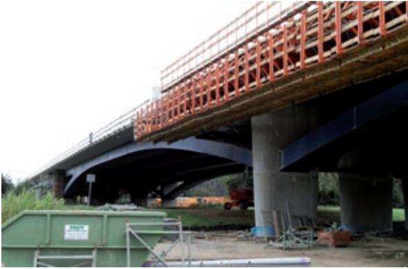
Bild 30 Stahlverbundbrücke über die Mürzitz-Elde-Wasserstraße Foto: Oliver Steinbock
