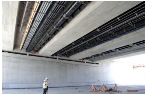
Bild 3 Untersicht einer Straßenüberführung in Berlin in Spannbetonbauweise Foto: Oliver Steinbock
