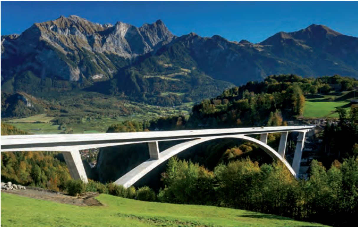
Bild 19 Die fertige Brücke
