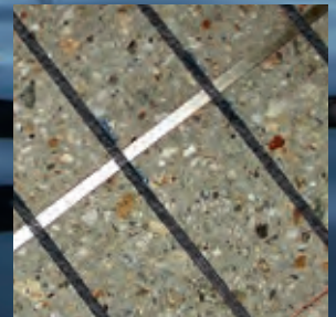
Kathodischer Korrosionsschutz Cathodic corrosion protection
