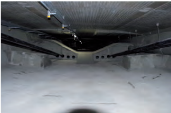
Bild 8 Hohlkastenbegehung der Rügenbrücke Stralsund Foto: Oliver Steinbock
