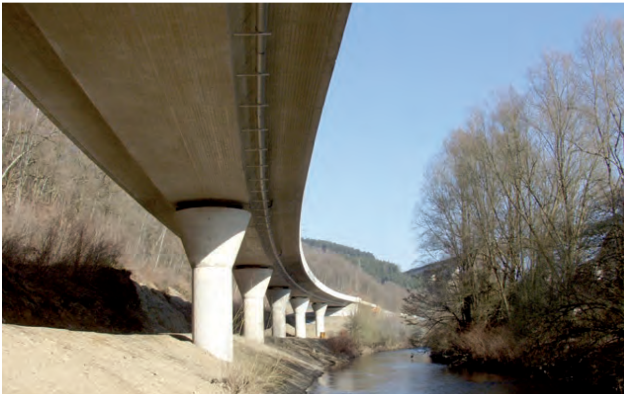
Untersicht der Hubenfeldbrücke
