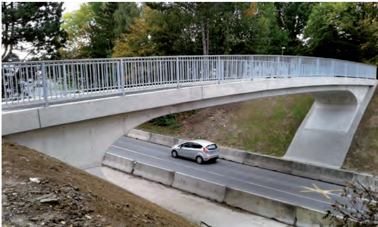
Neue Geh- und Radwegbrücke über die Giselastraße in Paderborn
