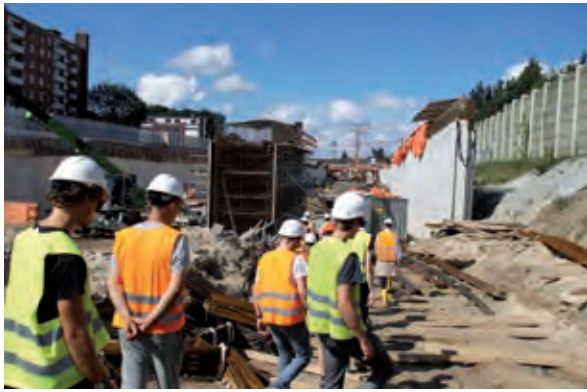
Bild 24 Besichtigung der Baustelle Stellingröder Deckel Foto: Oliver Steinbock
