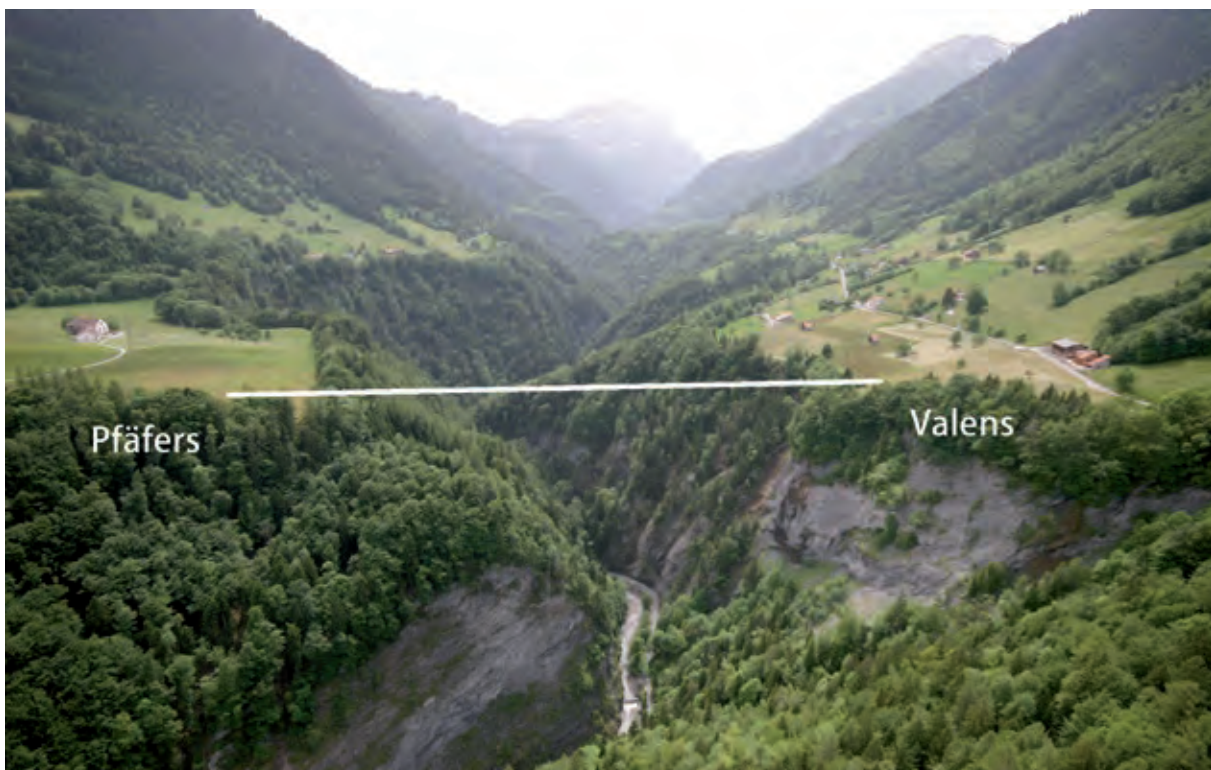
Bild 1 Ausgangssituation: die Taminaschlucht, Blick aus Nordwesten Foto: © Tiefbauamt Kanton St. Gallen
