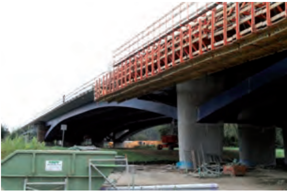
Bild 30 Stahlverbundbrücke über die Mürz-Elde-Wasserstraße Foto: Oliver Steinbock
