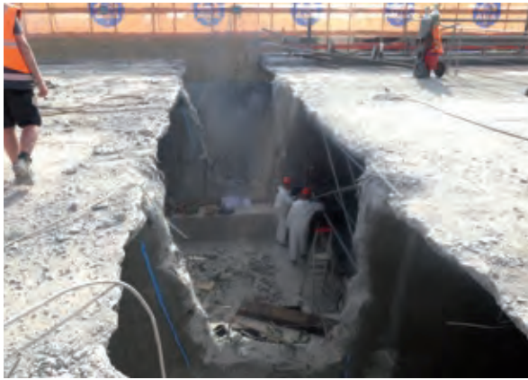
Bild 9 Arbeiten am ersten Trennschnitt im Feld 2 der Richtungsfahrbahn Köln Foto: DEGEGS
