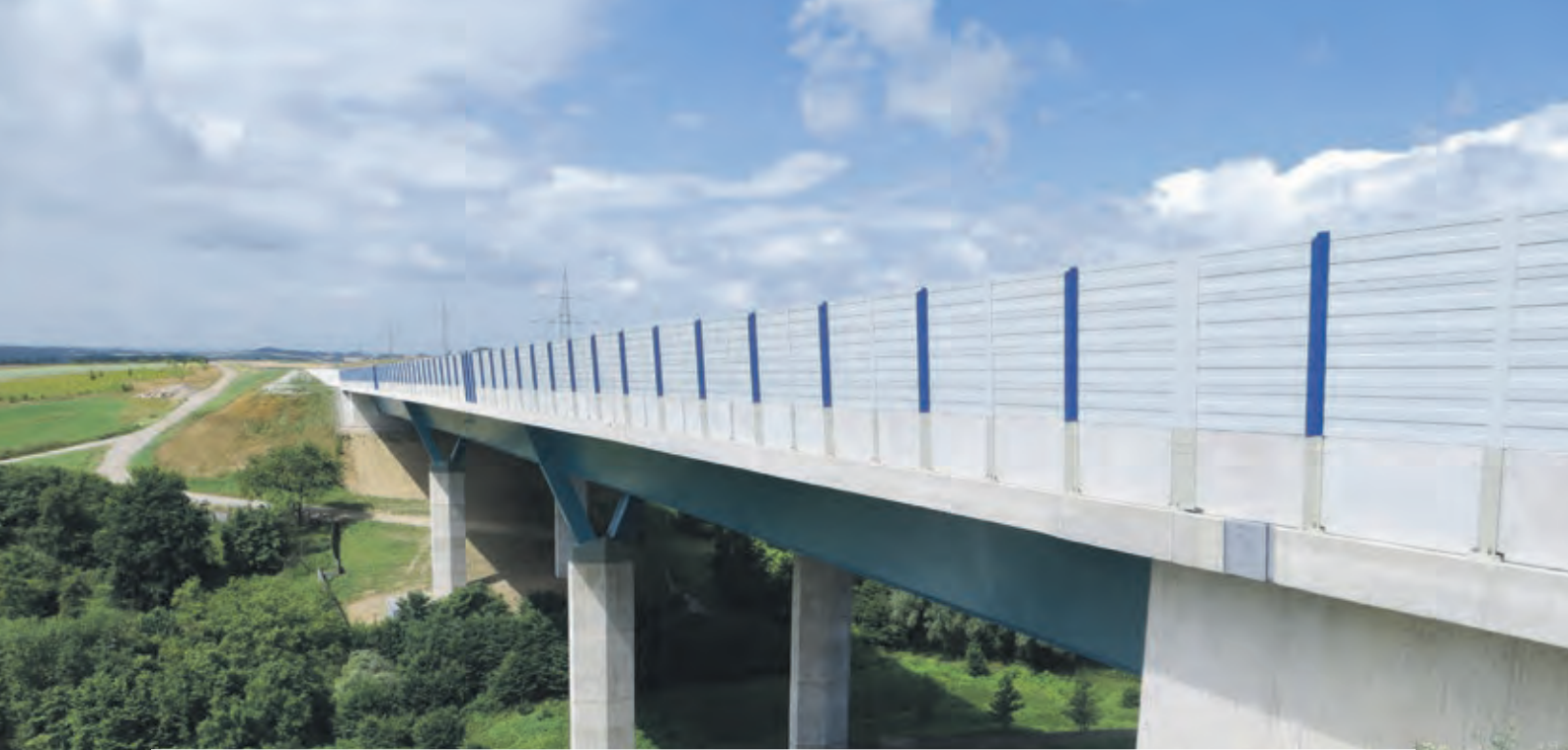
Talbrücke Ganslandsiepen, Kreis Mettmann, Nordrhein-Westfalen. Stahl-Stahlbeton-Verbundbrücke als dreifeldriges Brückenbauwerk mit einer Gesamtstützweite von 208 m. Bautechnische Prüfung: Prof. Dr.-Ing. G. Hanswille, HRA Ingenieurgesellschaft mbH Bochum. Bild oben: Landesbetrieb Straßenbau.NRW. Bild unten: HRA Ingenieurgesellschaft mbH Bochum.
