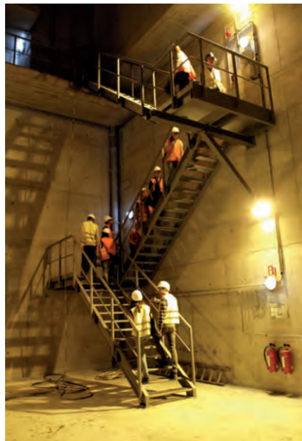
Bild 29 Begehung der Widerlagerkammer der Rethel- brücke Foto: Oliver Steinbock
