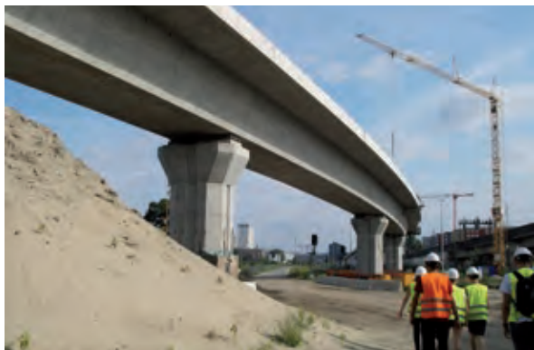
Bild 4 Ausbau der S-Bahn-Strecke S21 Foto: Oliver Steinbock
