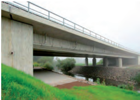
Brücke über den Schwarzbach bei Homburg-Einöd
