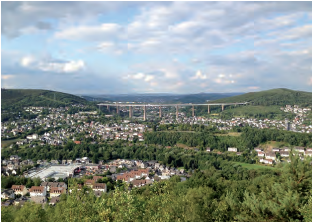
Bild 1 Siegtalbrücke im Zuge der Sauerlandlinie A 45
