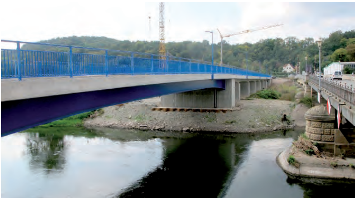
Neue (links) und alte Unstrutbrücke in Nebra
