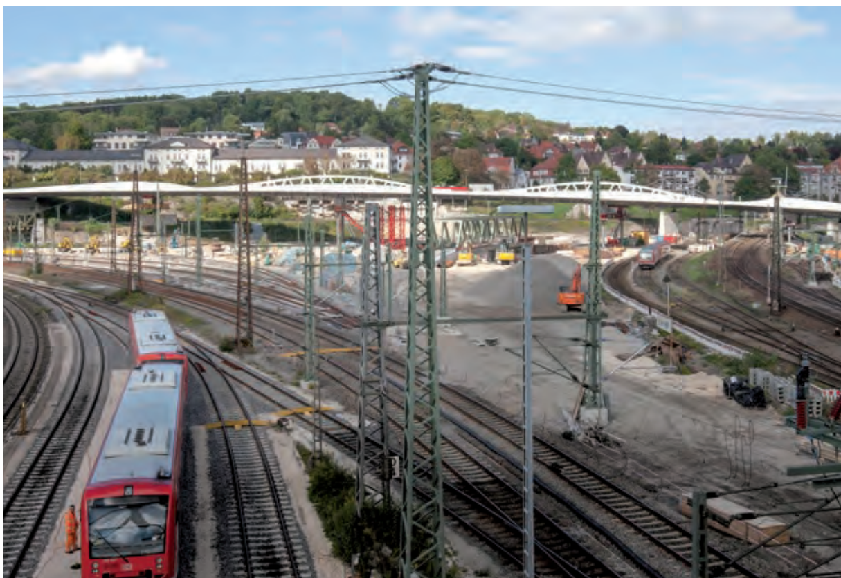
Bild 5 Brücke über dem DB-Gleisfeld nach Abschluss der Verscharbeiten 2017
