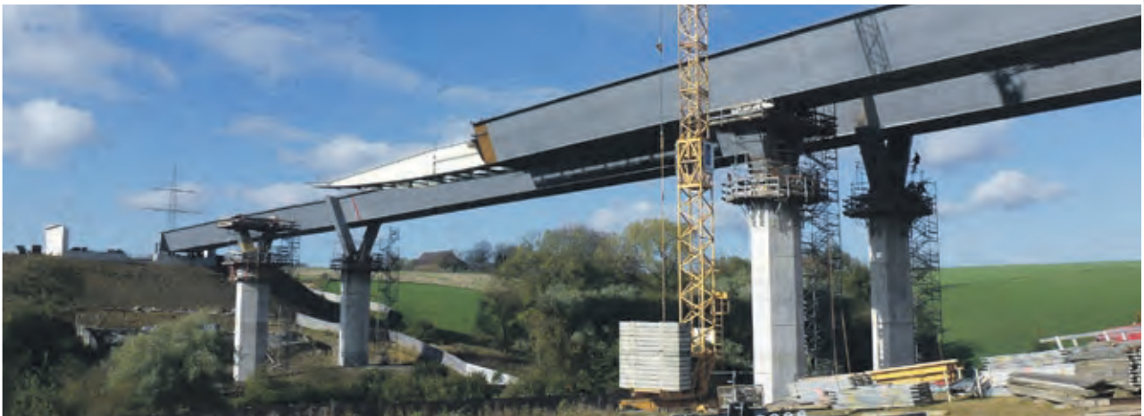
Talbrücke Ganslandsiepen, Kreis Mettmann, Nordrhein-Westfalen. Stahl-Stahlbeton-Verbundbrücke als dreifeldriges Brückenbauwerk mit einer Gesamtstützweite von 208 m. Bautechnische Prüfung: Prof. Dr.-Ing. G. Hanswille, HRA Ingenieurgesellschaft mbH Bochum. Bild oben: Landesbetrieb Straßenbau.NRW. Bild unten: HRA Ingenieurgesellschaft mbH Bochum.
