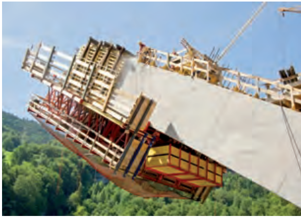
Bild 13 Freivorbaurüstung Bogen Foto: © LAP
