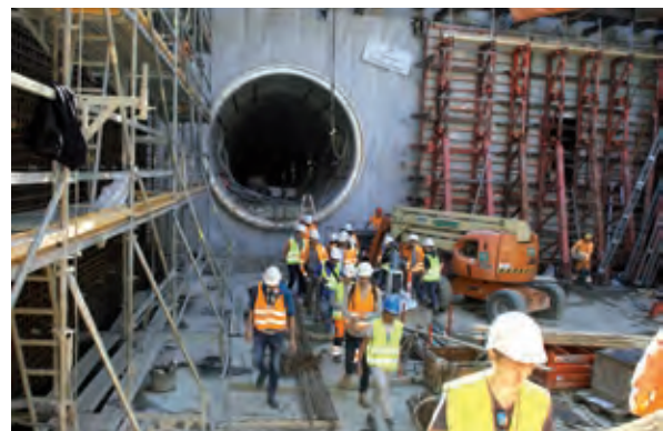
Bild 14 Besichtigung der Baustelle Nordhavn/Kopenhagen Foto: Oliver Steinbock
