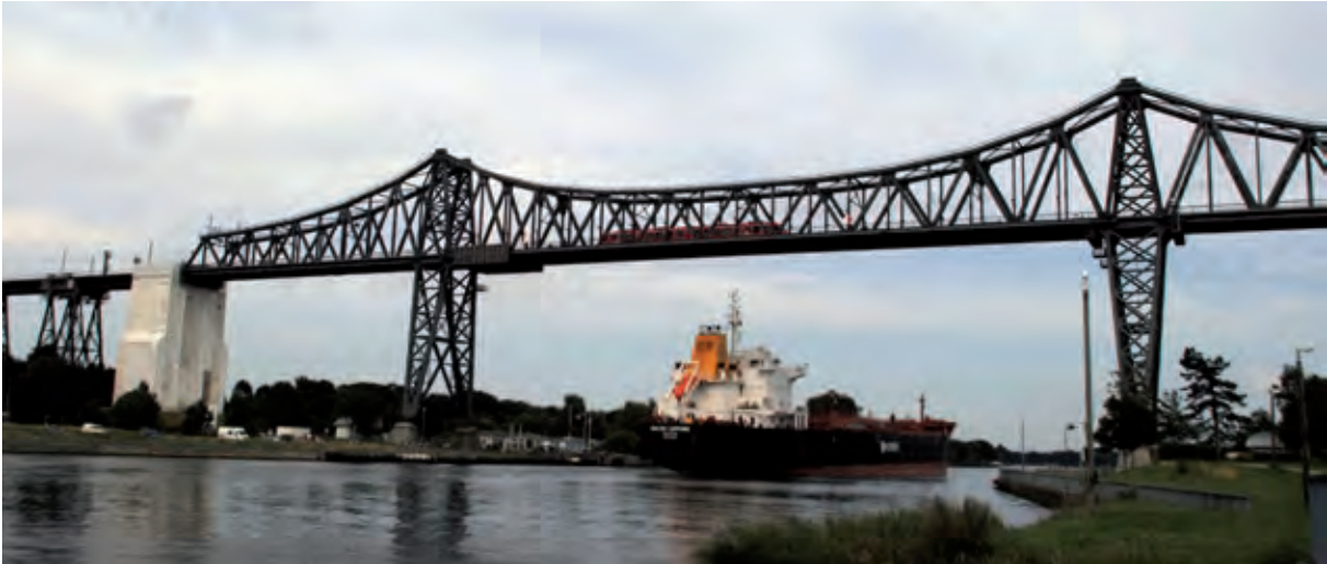
Bild 20 Rendsburger Hochbrücke während der Sanierung
