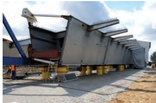
Bild 23 Besichtigung der Baustelle Langenfelder Brücke Foto: Oliver Steinbock
