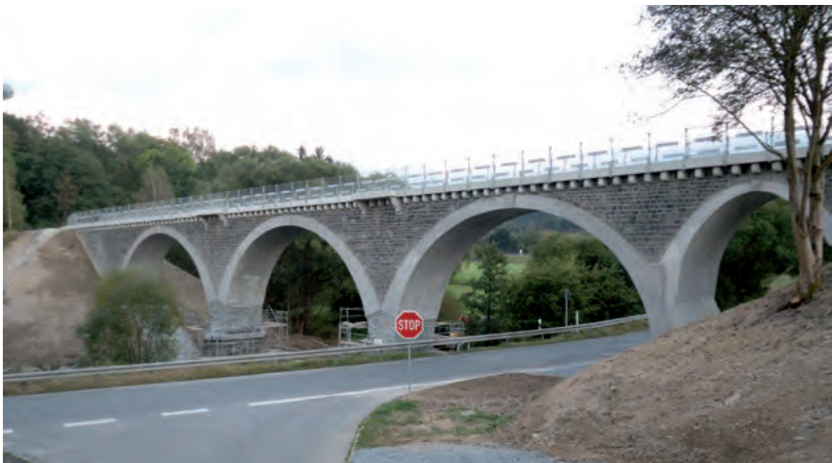
Bild 1 Mit Carbonbeton sanierte historische Betonbogenbrücke in Naila
