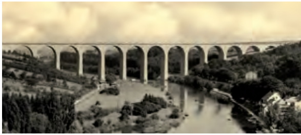
Bild 1 Errichtung der Lahntalbrücke im Zuge des Reichsautobahnbaus 1938/39 Foto: Bildverlag Foto-Heinz, Limburg
