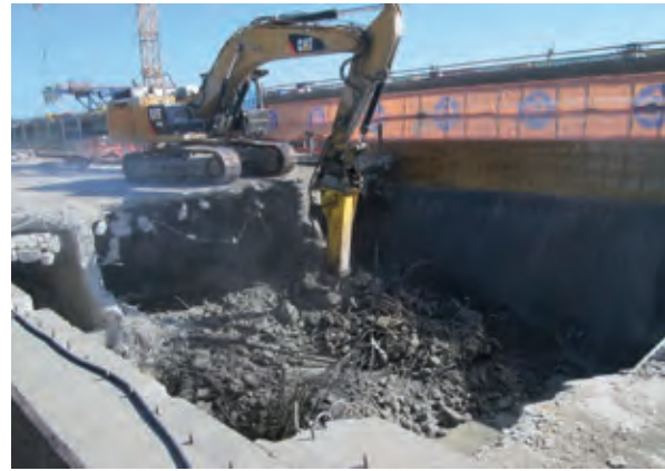
Bild 11 Rückbau des Überbaus im Schutze der Stahlwanne, die auf der Vorschubrüstung montiert ist Foto: DEGEGS
