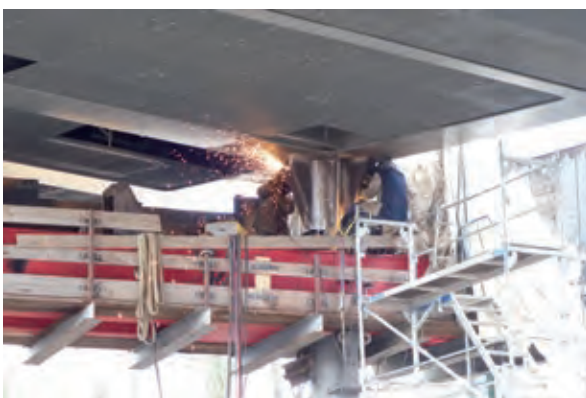
Bild 13 Unterseitiges Verschweißen der Pfeiler mit dem Überbau zum semi-integralen Tragwerk Foto: Jan Akkermann
