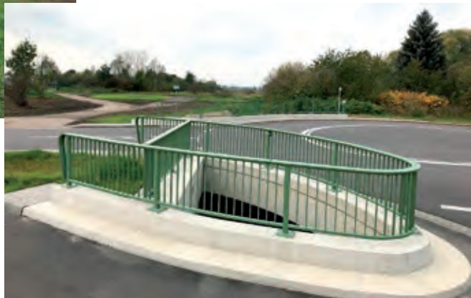
„Ökologisches Brückenaug“ mit Mini-Kreisverkehr bei der Kabelskebrücke
