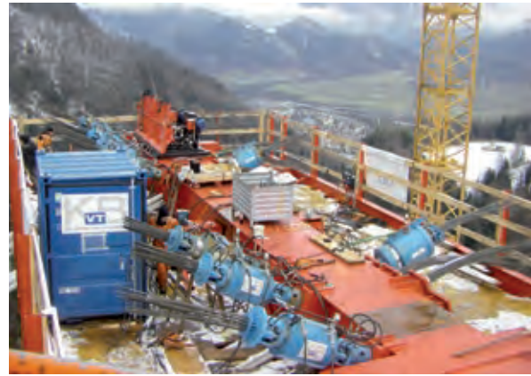
Bild 14 Spannen der Haltekabel Foto: © LAP
