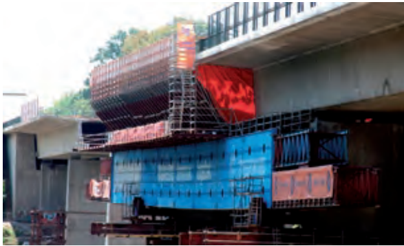
Bild 14 Verformung der Vorschubrüstung durch Vorspannen gegen den Überbau über Distanzstücke Foto: Marx Krontal GmbH
