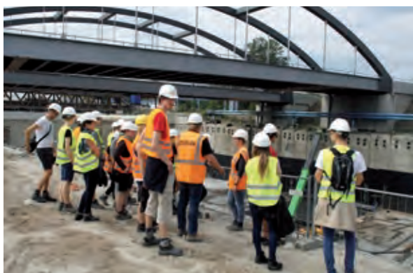
Bild 2 Exkursionsteilnehmer vor der offenen Baugrube nahe der Berliner Sonnenallee sowie den Stahlbogenbrücken Foto: Oliver Steinbock
