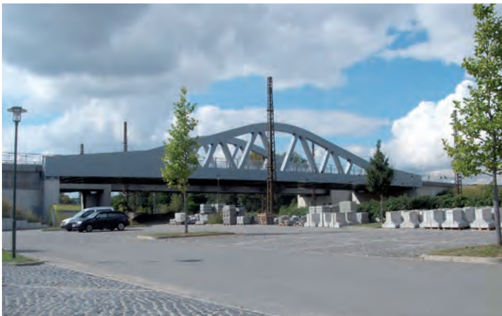
Brücke über die Anlagen der DB AG in Naumburg
