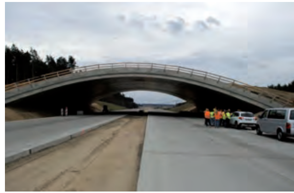
Bild 31 Wildbrücke über die Bundesautobahn A14 Foto: Oliver Steinbock
