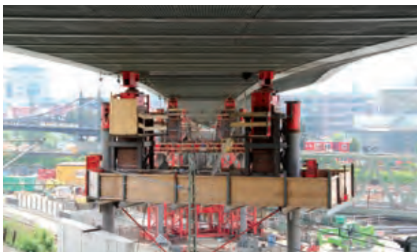
Bild 12 Vorrichtung zum ersten Abstapeln Foto: Udo Hoffmann
