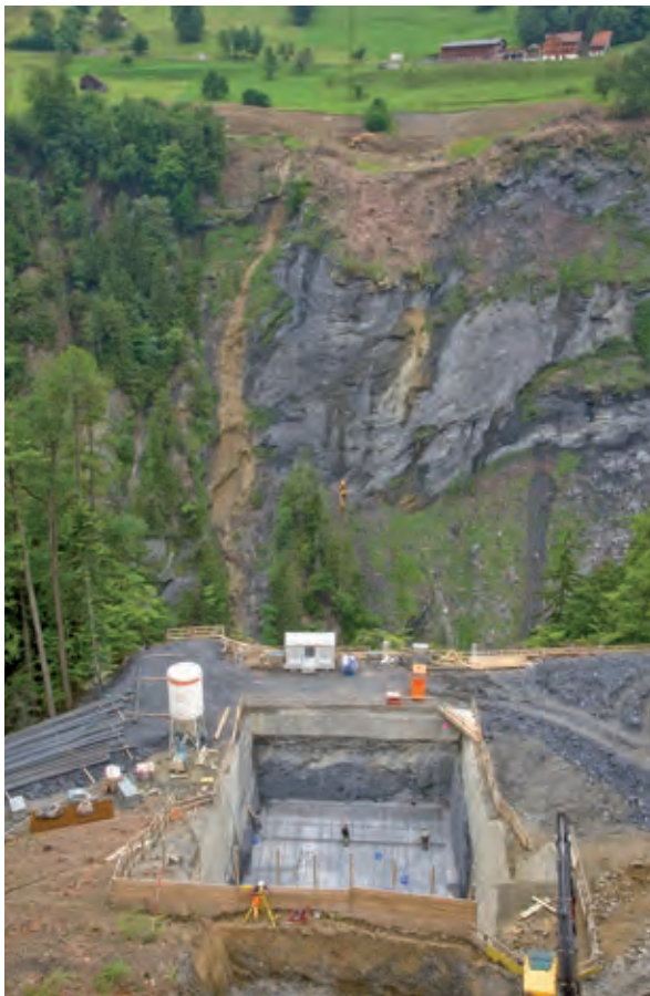
Bild 10 Zuwegung Kämpferseite Pfäfers Foto: © Tiefbauamt Kanton St. Gallen
