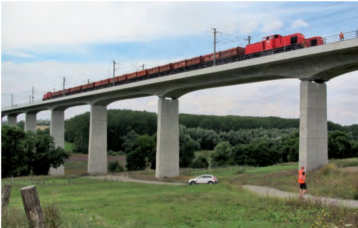
Bild 6 Belastungszüge bei den Probelastungen im August 2014
