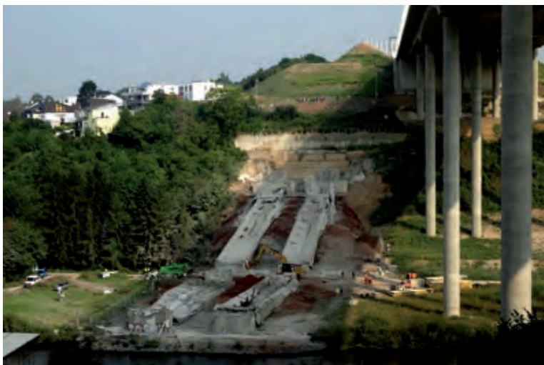
Bild 17 Ergebnis der erfolgreichen Sprengung
