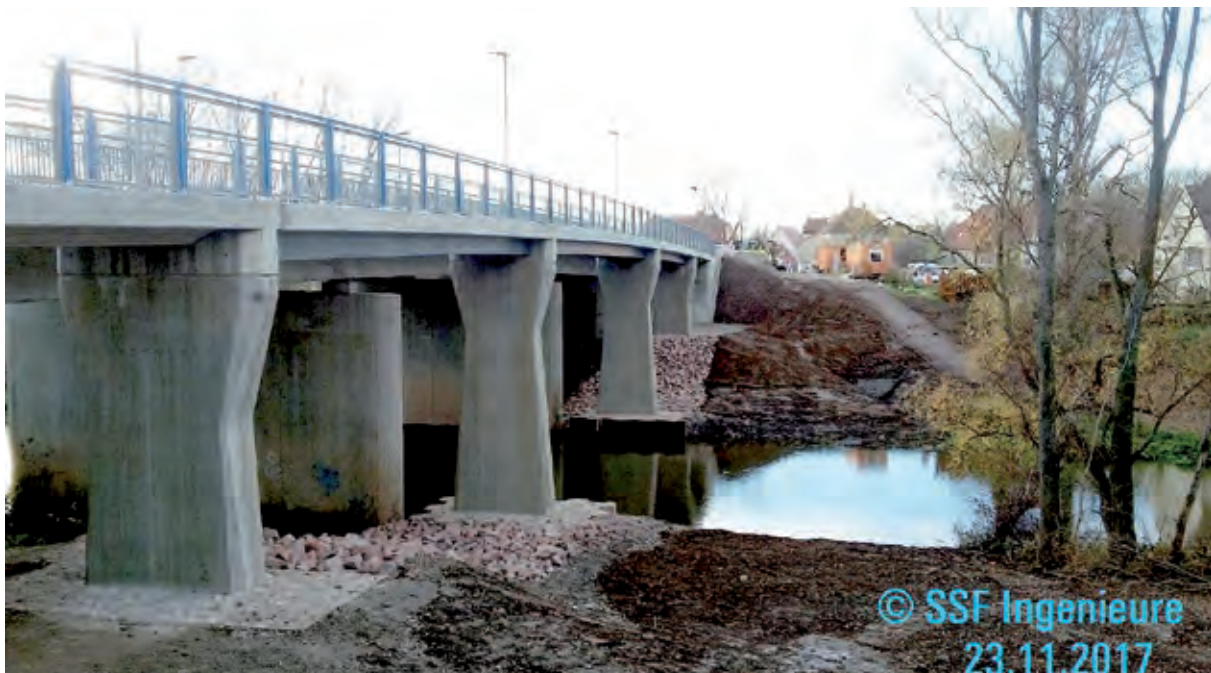
Neue Radwegbrücke über den Mittelkanal in Merseburg
