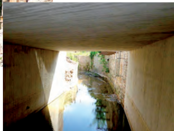
Untersicht der Mühlgrabenbrücke in Zeitz Foto: Landesstraßenbaubehörde Sachsen-Anhalt, RB Süd
