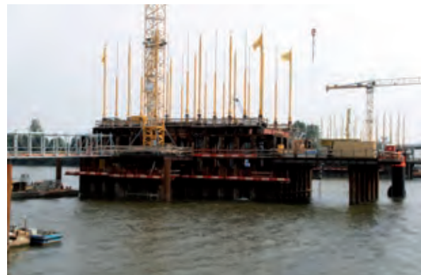
Bild 27 Besichtigung der Baustelle der neuen Hub- brücke Kattwyk Foto: Oliver Steinbock
