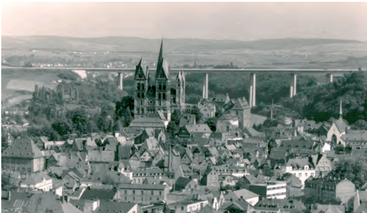
Bild 2 Ersatzbau 1964 als Spannbetonbrücke im Freivorbau errichtet
