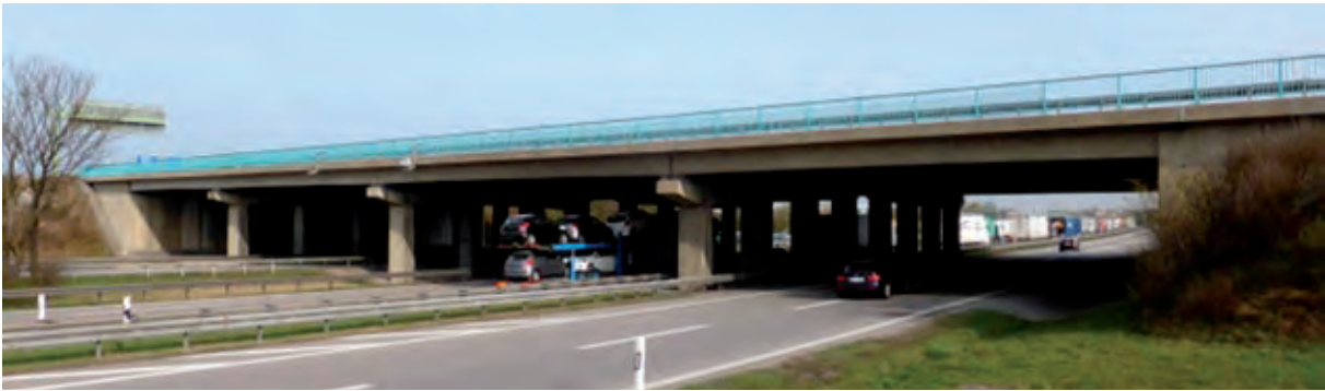
Bild 4 AK München Ost, BW 17, Baujahr 1973, Teilbauwerke 1999, 2004 Foto: Autobahndirektion Südbayern
