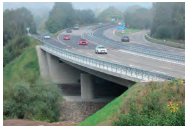
Brücke über den Schwarzbach bei Homburg-Einöd unter Verkehr Fotos: Straßenbauverwaltung Saarland
