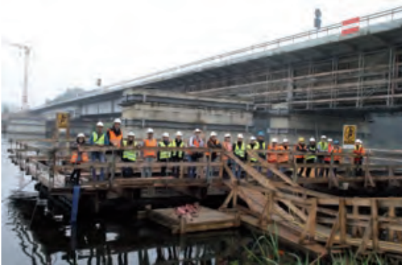
Bild 6 Baumaßnahmen am Petersdorfer See in Mecklenburg-Vorpommern Foto: Oliver Steinbock
