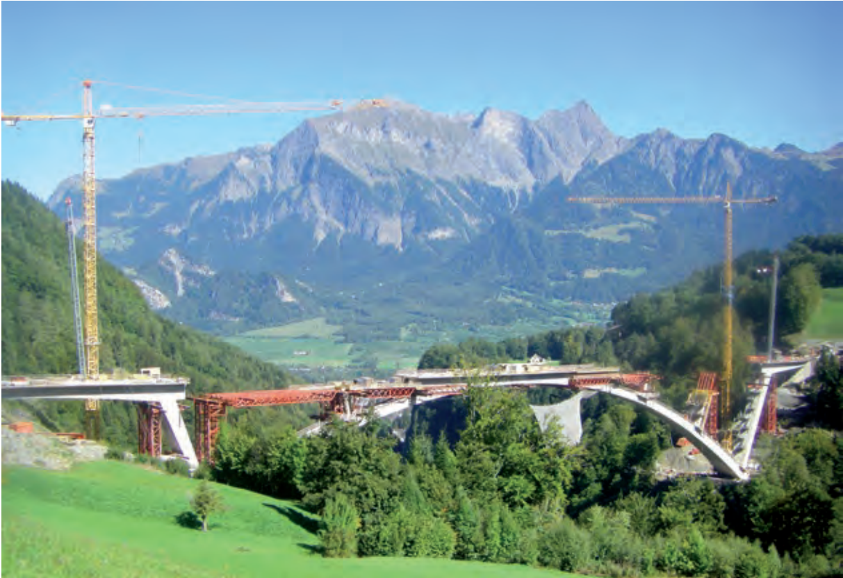
Bild 16 Herstellung des Überbaus parallel zu den Bogenständern
