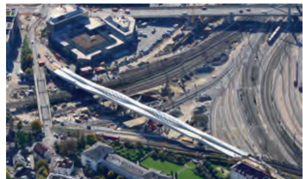
Bild 14 Brücke in endgültiger Lage nach dem Abstapeln Foto: Heinrich Wolf
