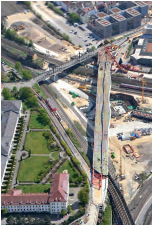
Bild 11 Einheben des letzten Schusses im April 2017 Foto: Heinrich Wolf
