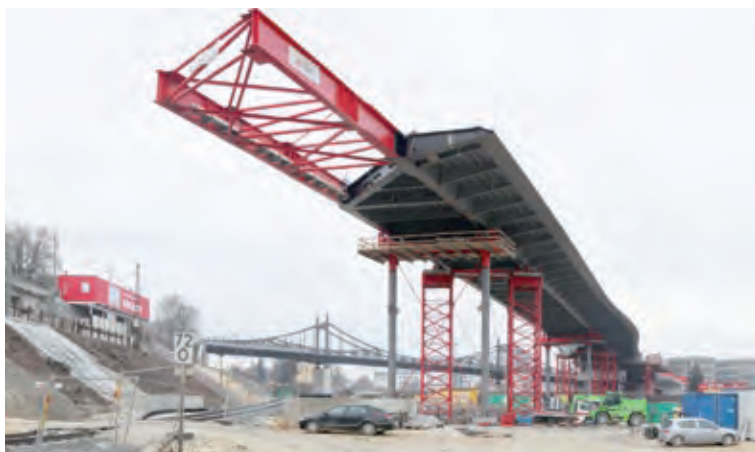
Bild 10 Längsverschub bei Achse 50
