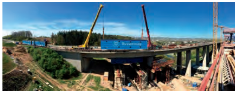
Bild 6 Einheben der Vorschubrüstung in vormontierten Einzelschüssen Foto: Thyssen Krupp, Wuppertal
