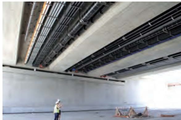
Bild 3 Untersicht einer Straßenüberführung in Berlin in Spannbetonbauweise Foto: Oliver Steinbock
