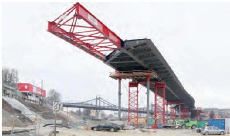
Bild 10 Längsverschub bei Achse 50
