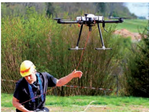
Bild 5 Seiltransport mit unbemanntem Flugsystem
