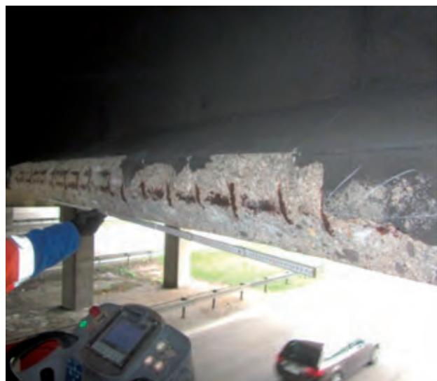
Bild 5 Schäden an den Stegen der Spannbetonträger über den Lkw-Spuren (AK München Ost, BW 17)
