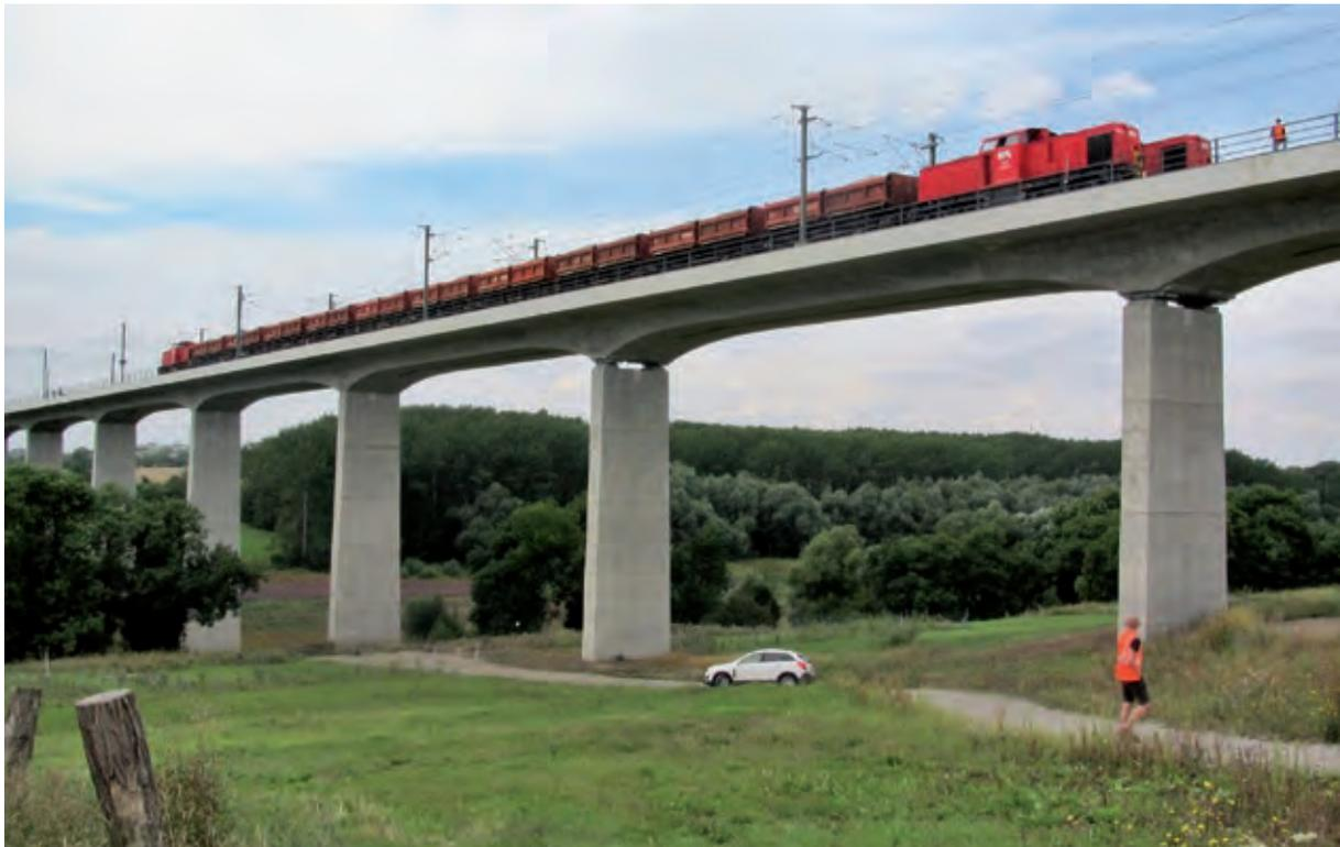
Bild 6 Belastungszüge bei den Probelastungen im August 2014
