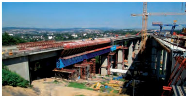
Bild 8 Fertigstellung der Vorschubrüstung mit Schutzwanne für den Abbruch des ersten Feldabschnitts von Überbaufeld 2 zu Überbaufeld 3
