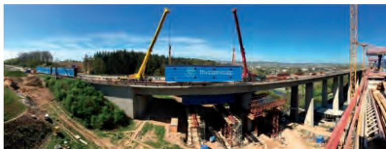
Bild 6 Einheben der Vorschubrüstung in vormontierten Einzelschüssen
