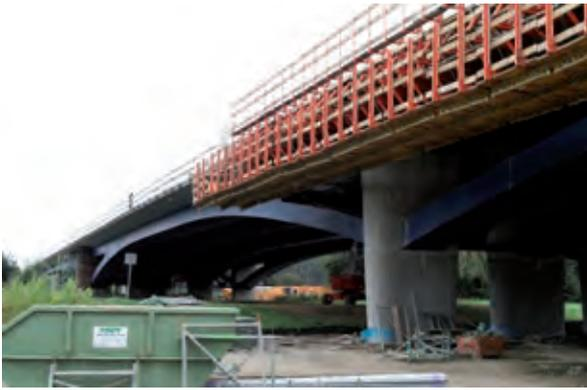
Bild 30 Stahlverbundbrücke über die Mürz-Elde-Wasserstraße Foto: Oliver Steinbock
