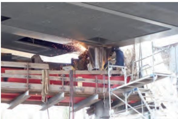
Bild 13 Unterseitiges Verschweißen der Pfeiler mit dem Überbau zum semi-integralen Tragwerk
