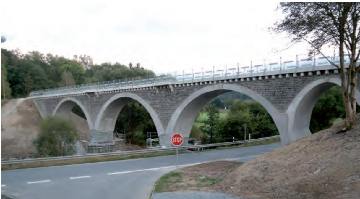
Bild 1 Mit Carbonbeton sanierte historische Betonbogenbrücke in Naila
