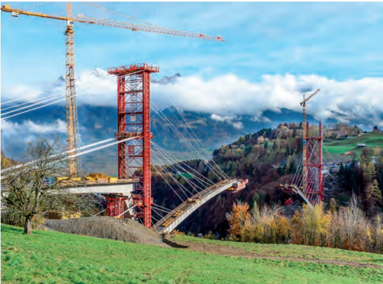
Bild 12 Freivorbau im Wochentakt; zu sehen sind die Hilfspylone und Abspannungen sowie rechts (Seite Pfäfers) der höchste freistehende Turmdrehkran Europas
