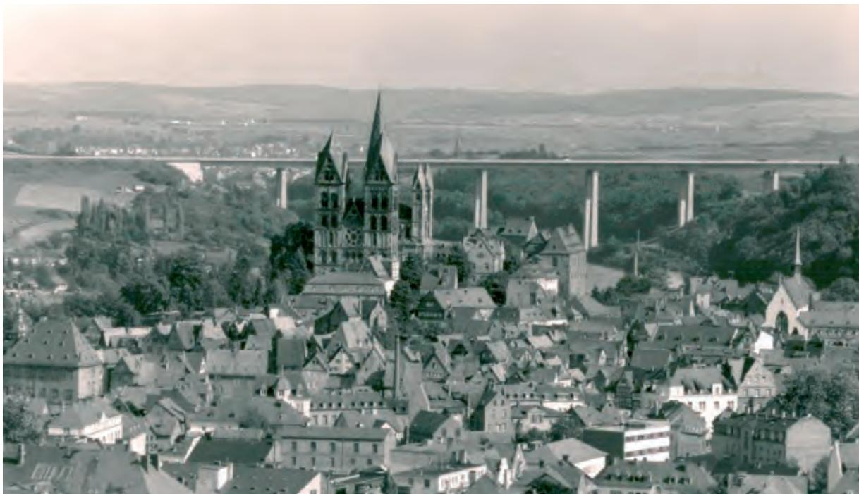
Bild 2 Ersatzbau 1964 als Spannbetonbrücke im Freivorbau errichtet
