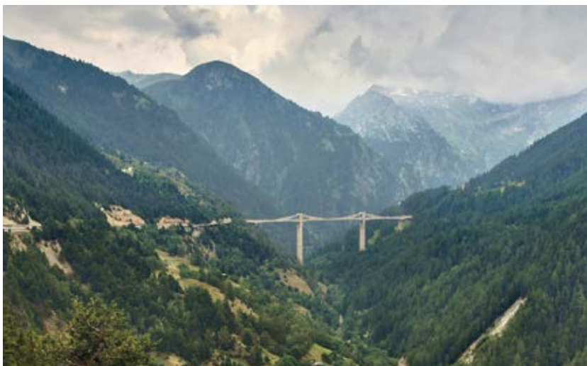
Bild 3 Ganterbrücke bei Ried-Brig im Juli 2010
