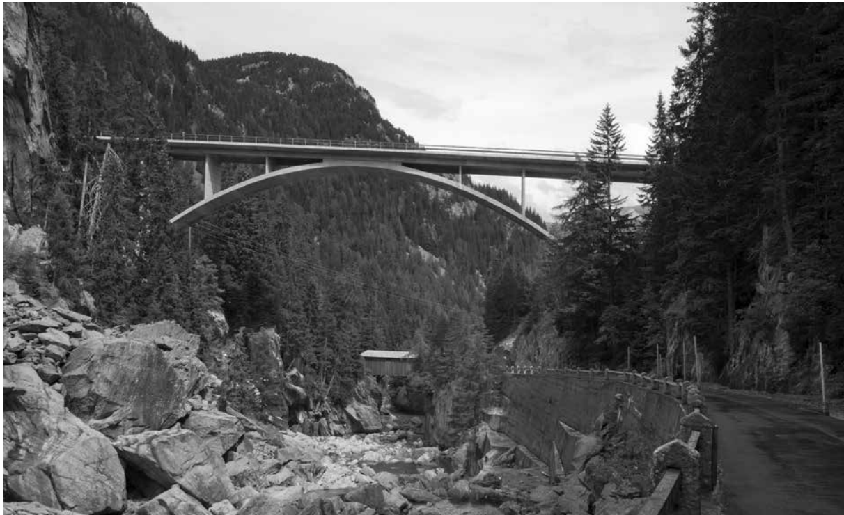
Bild 2 Crestawaldbrücke über den Hinterrhein bei Sufers
