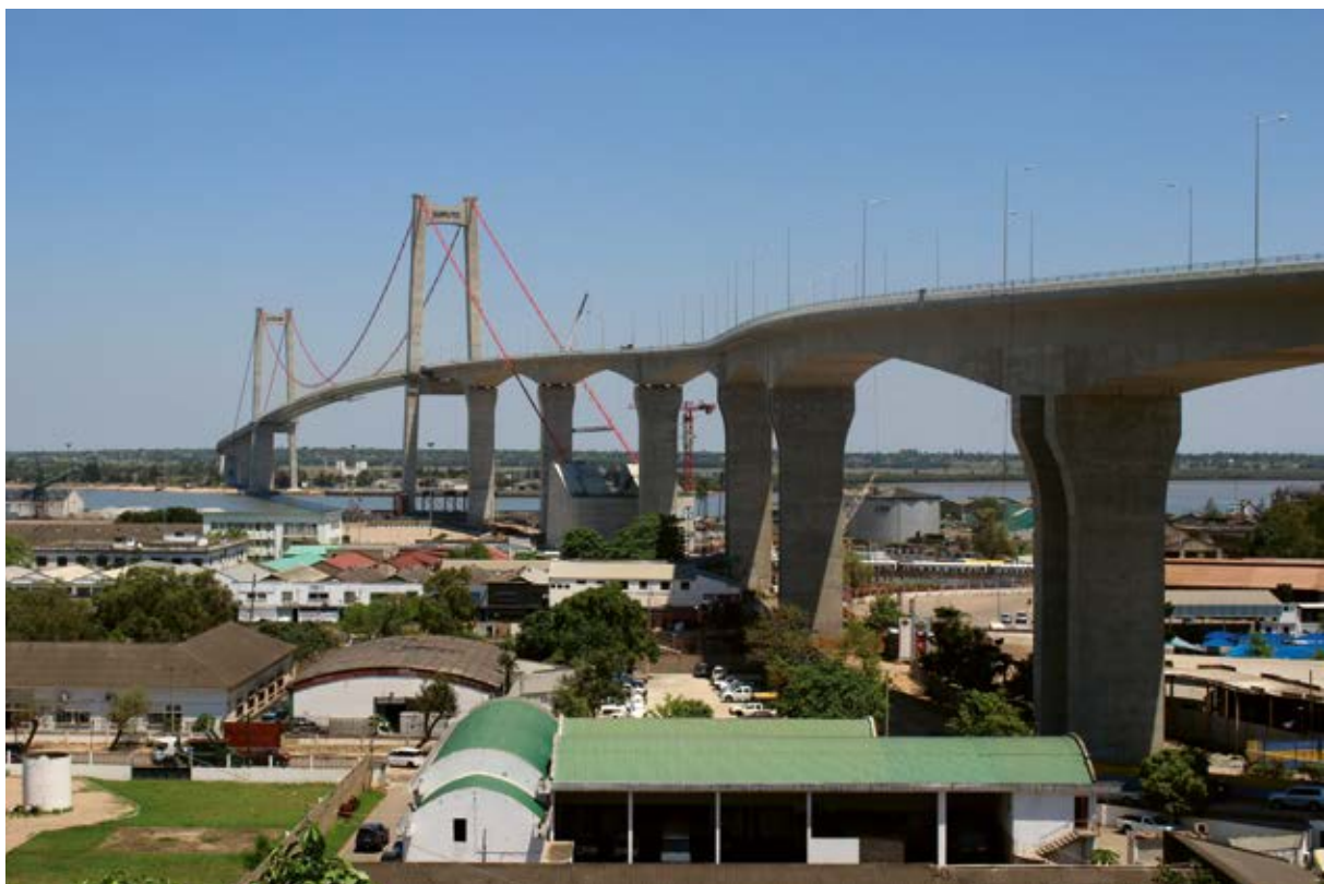
Bild 1 Nordzufahrt und Hauptbrücke
