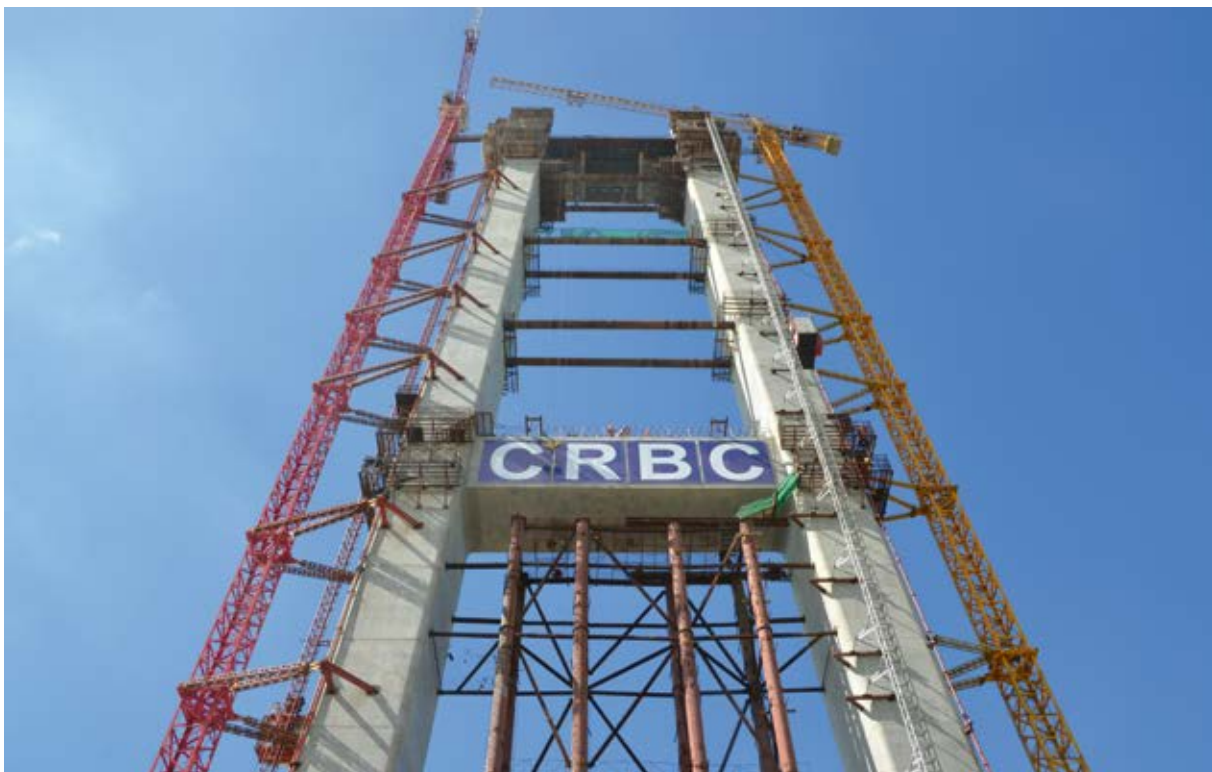
Bild 5 Pylon mit ca. 137 m Höhe mit dem unteren und oberen Querriegel im Bauzustand
