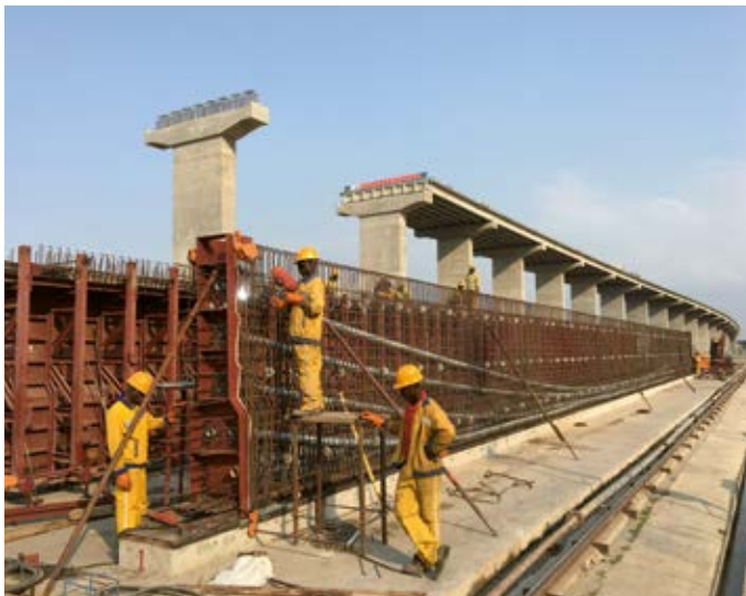
Bild 13 Fertigteilträger L = 30 m für die Vorlandbrücke Süd; Schalung (links) und Querschnitt (rechts)
