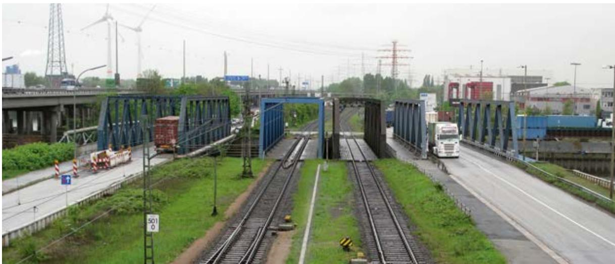
Bild 4 Die vier Bestandsbrücken (bis 2015) in der Frontalansicht; der westliche Brückenüberbau (rechts) stellt die einzige Straßenverbindung zu Hamburgs größtem Terminal, dem Containerterminal Burchardkai, dar. Diese Verkehrsverbindung soll zum einen im Zuge des Neubaus von zwei auf drei Fahrspuren verbreitert werden, zum anderen muss aber während der gesamten Bauzeit eine 2-spurige Verbindung erhalten bleiben. Die östliche Straßenbrücke (links) kann hierfür nicht genutzt werden.
