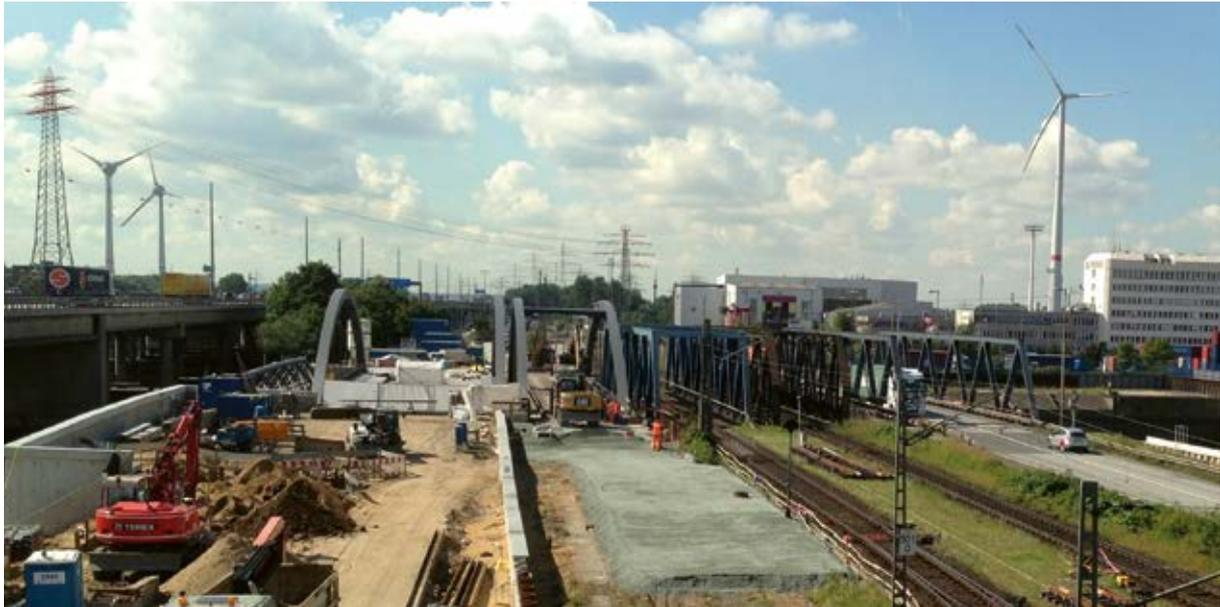
Bild 5 Bauphase 1: Die Überbauten der neuen östlichen Straßenbrücke und der neuen 1-gleisigen Bahnbrücke sind bereits eingehoben.
