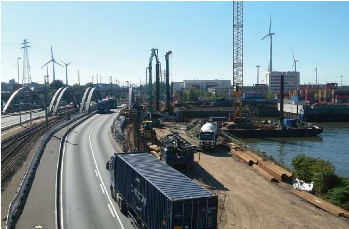
Bild 11 Bauphase 2, Stand der Bauarbeiten im November 2018. Drei der vier neuen Brückenüberbauten sind fertiggestellt und in Betrieb genommen. Die westliche Bahnbrücke (rechts) dient als Straßenbrücke für die provisorische Umfahrung. Die Widerlager für die westliche Straßenbrücke werden hergestellt. Foto: Thomas Witt / HPA
