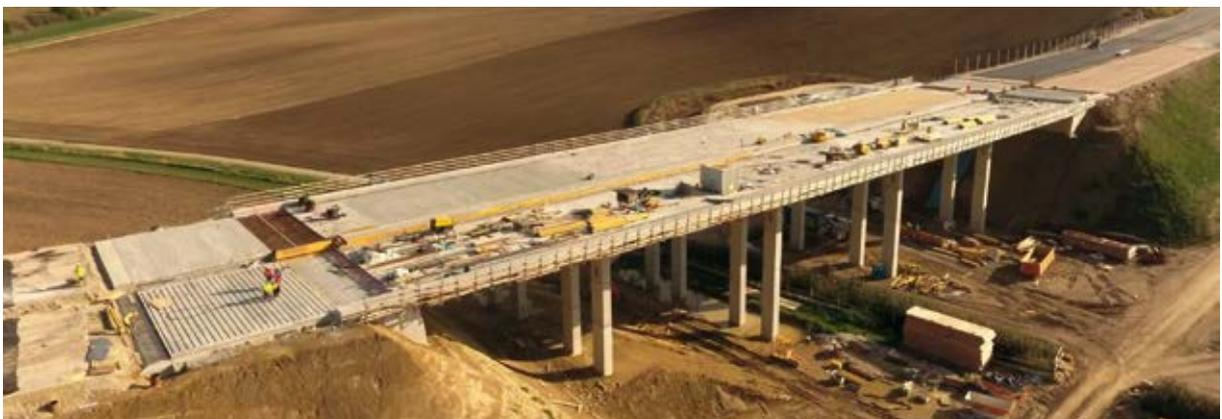
Bild 2 Einbau der Fahrwegübergangskonstruktionen an den jeweiligen Brückenden
