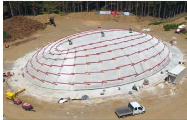
Bild 7 Ursprünglich ebene Platte (links) und fertiggestellte, umgeformte Betonschale (rechts) der Wildbrücke AM2
