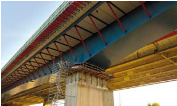
Bild 2 Typische Stahlverbund-Deckbrücken mit Teilfertigteilen: Ausführung mit Schrägstreben (Lenne-talbrücke, A45) und Ausführung mit Konsolen (Talbrücke Heidingsfeld, A3) Fotos: Gregor Gebert
