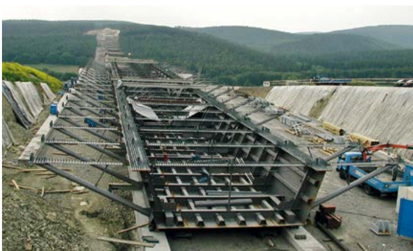
Bild 3 Einteiliger Stahlverbundquerschnitt: Reichenbachtalbrücke (A71) Foto: Gregor Gebert
