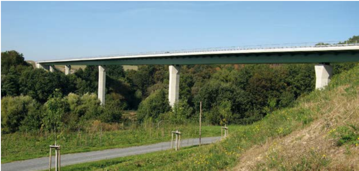
Bild 10 Ansicht der Bahretalbrücke mit Stützweiten von 36 – 52 – 72 – 76 – 64 – 52 m
