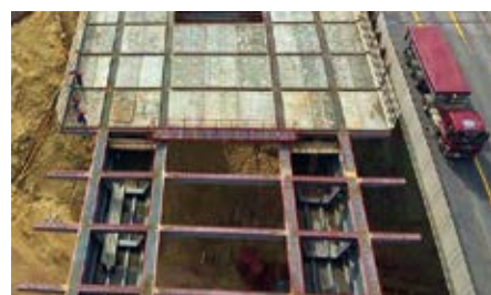
Bild 15 Langenfelder Brücke - Regelquerschnitt und Draufsicht auf den Trägerrost mit teilweise aufgelegten Fertigteilen, s. a. Bild 4 Zeichnung: DEGES/Schüßler-Plan, Foto: DEGES
