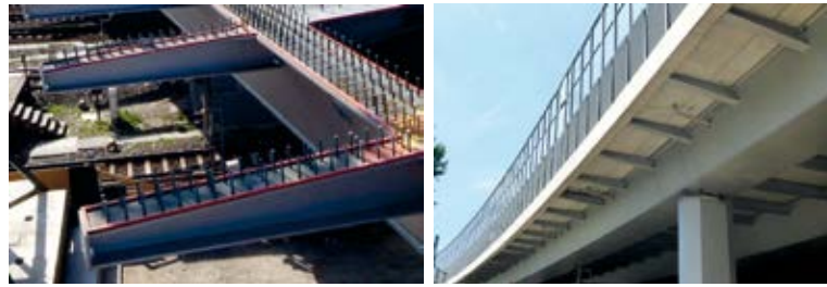
Bild 4 Langenfelder Brücke (A7) in Hamburg mit Konsolträgern und Teilfertigteilen Fotos: Gauthier
