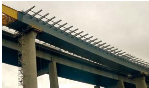
Bild 2 Typische Stahlverbund-Deckbrücken mit Teilfertigteilen: Ausführung mit Schrägstreben (Lenne-talbrücke, A45) und Ausführung mit Konsolen (Talbrücke Heidingsfeld, A3) Fotos: Gregor Gebert
