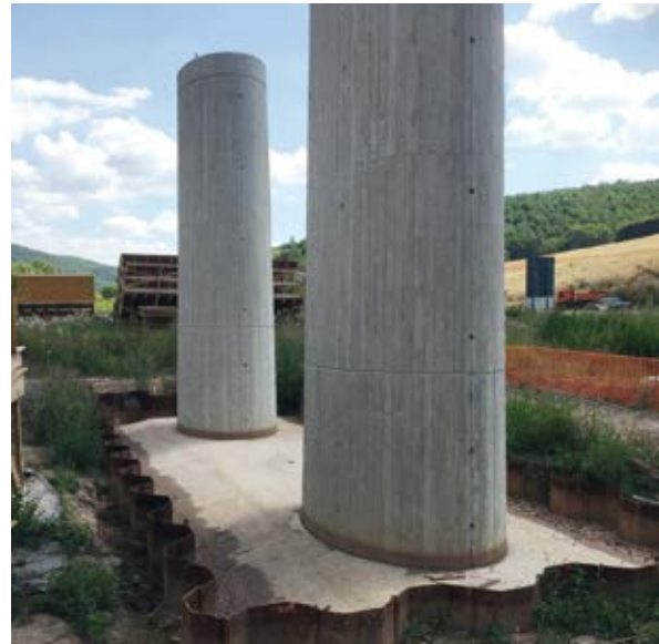
Bild 8 Vorbelastung Pfeilerfundamente mittels Systemblöcken aus Beton (links) und ohne Systemblöcke (rechts) Fotos: © HTI Greußen
