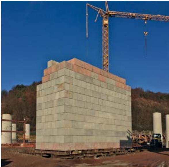
Bild 8 Vorbelastung Pfeilerfundamente mittels Systemblöcken aus Beton (links) und ohne Systemblöcke (rechts) Fotos: © HTI Greußen
