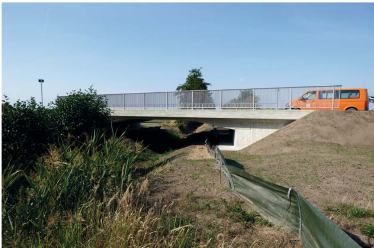
Brücke über den Haubegraben bei Oebisfelde
