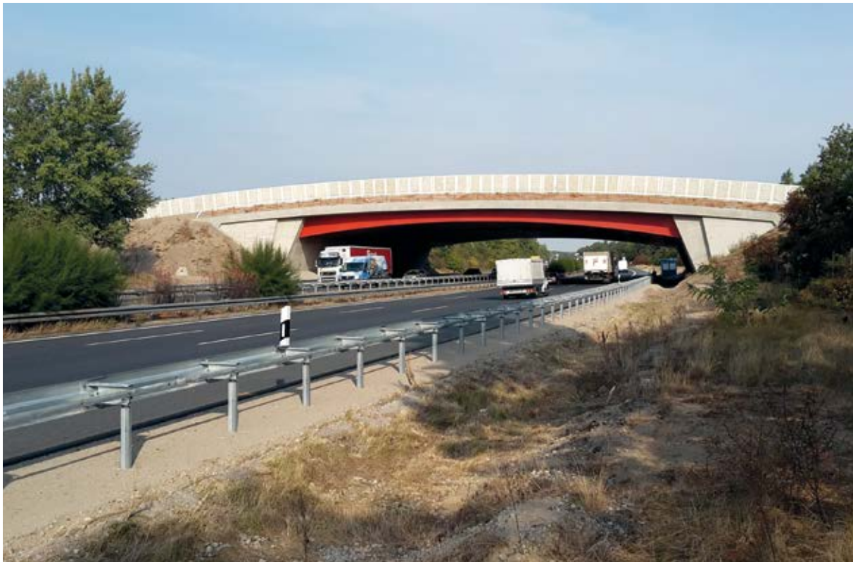
Grünbrücke über die A 9 bei Beelitz
