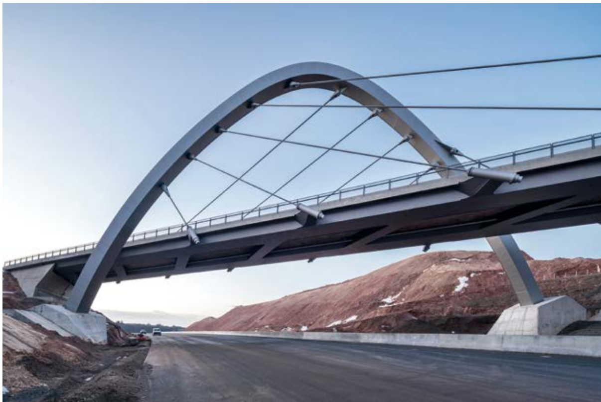
Seitenansicht der Monobogenbrücke nach Fertigstellung
