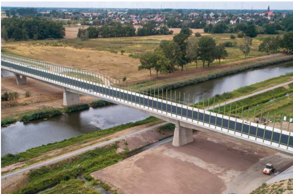
Luftbild der Brücke über die Schwarze Elster bei Bad Liebenwerda
