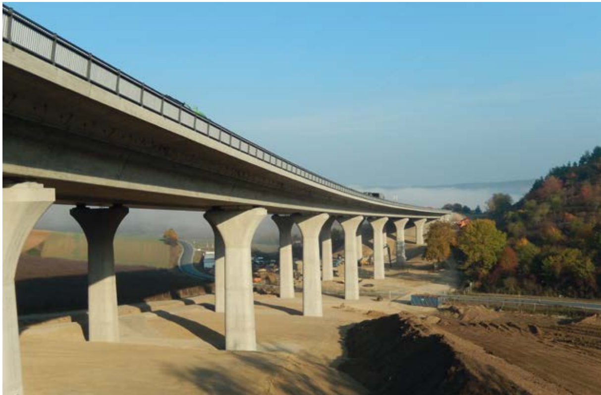
Talbrücke Klöffelsberg kurz vor der Fertigstellung
