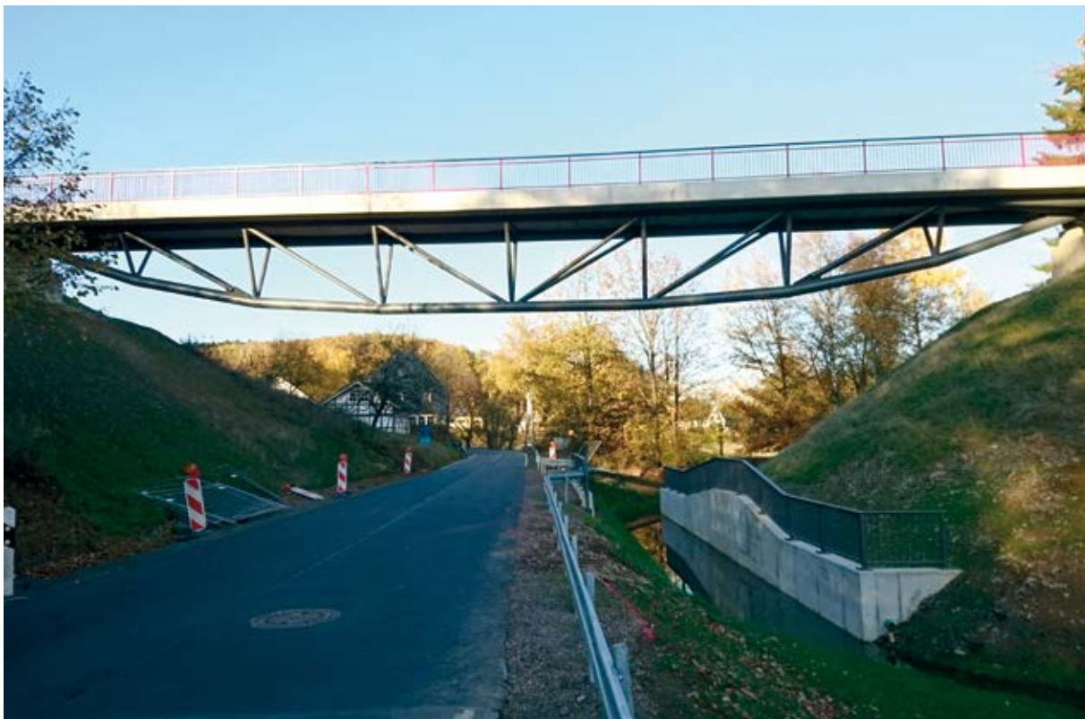
Brücke über den Bahntrassen-Radweg über die L 351 in Drolshagen-Eichenermühle
