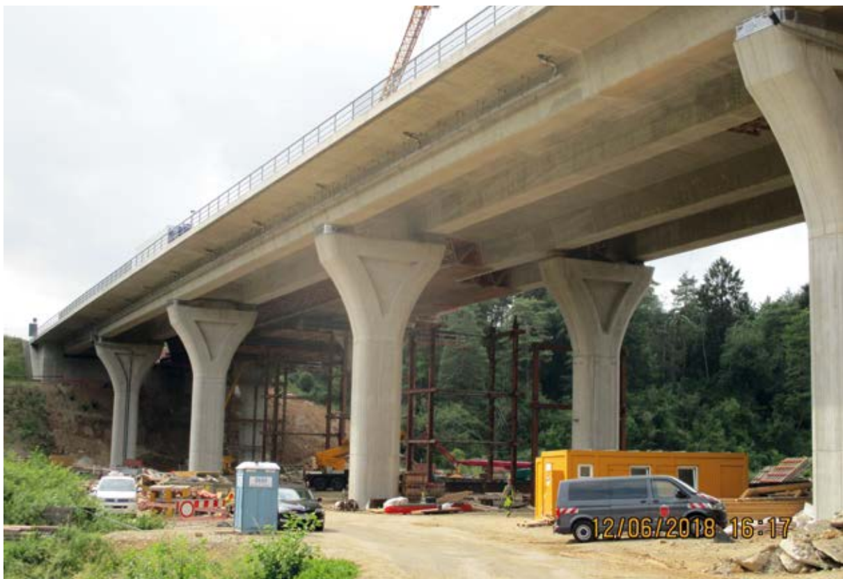
Talbrücke Geigerhaid im Bauzustand
