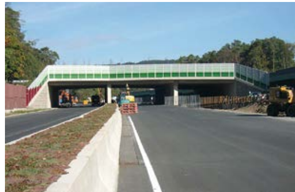
Seitenansicht der Brücke „Postweg“
