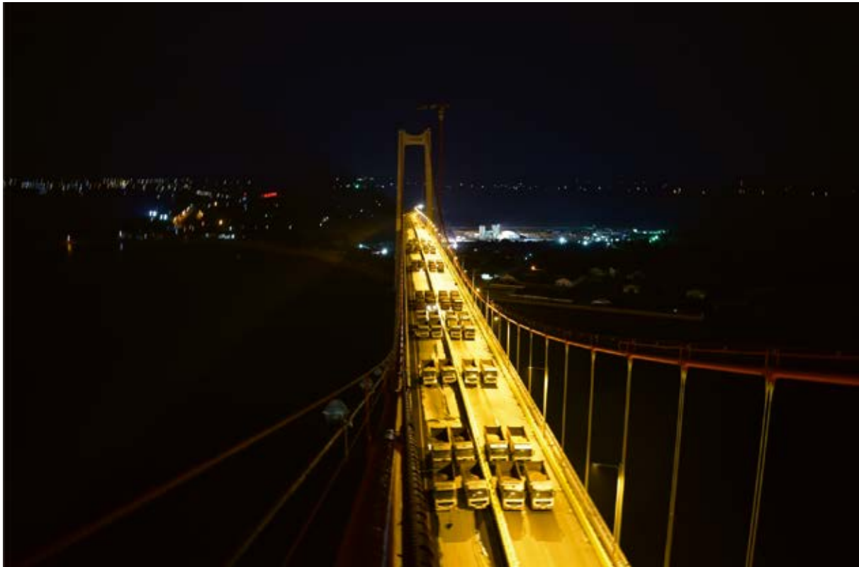
Bild 14 Belastungsversuch der Hauptbrücke mit 56 Lkw zu jeweils 25 t in der Nacht
