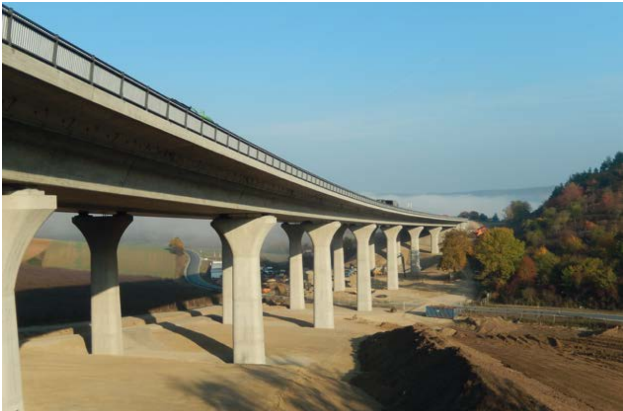
Talbrücke Klöffelsberg kurz vor der Fertigstellung
