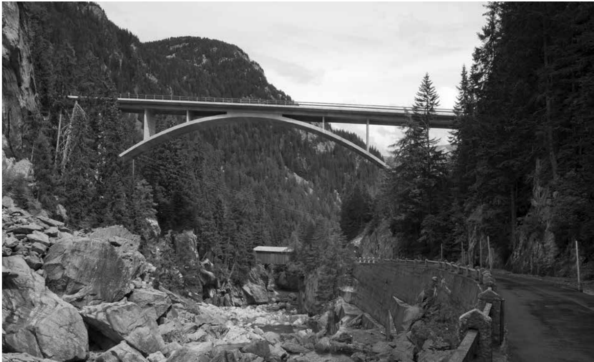
Bild 2 Crestawaldbrücke über den Hinterrhein bei Sufers
