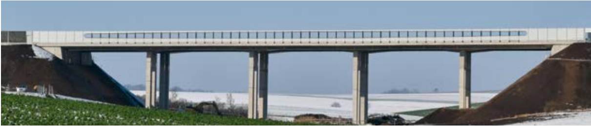
Bild 3 Satzengrabenbrücke kurz vor der Eröffnung im Dezember 2017
