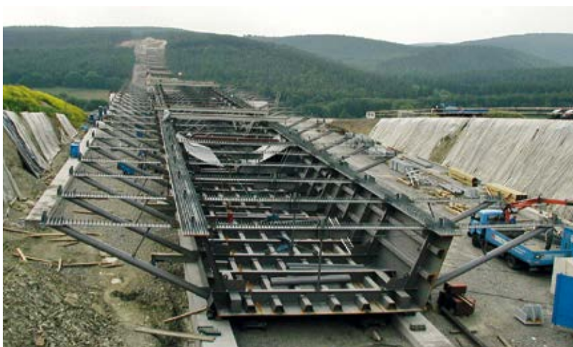
Bild 3 Einteiliger Stahlverbundquerschnitt: Reichenbachtalbrücke (A71) Foto: Gregor Gebert
