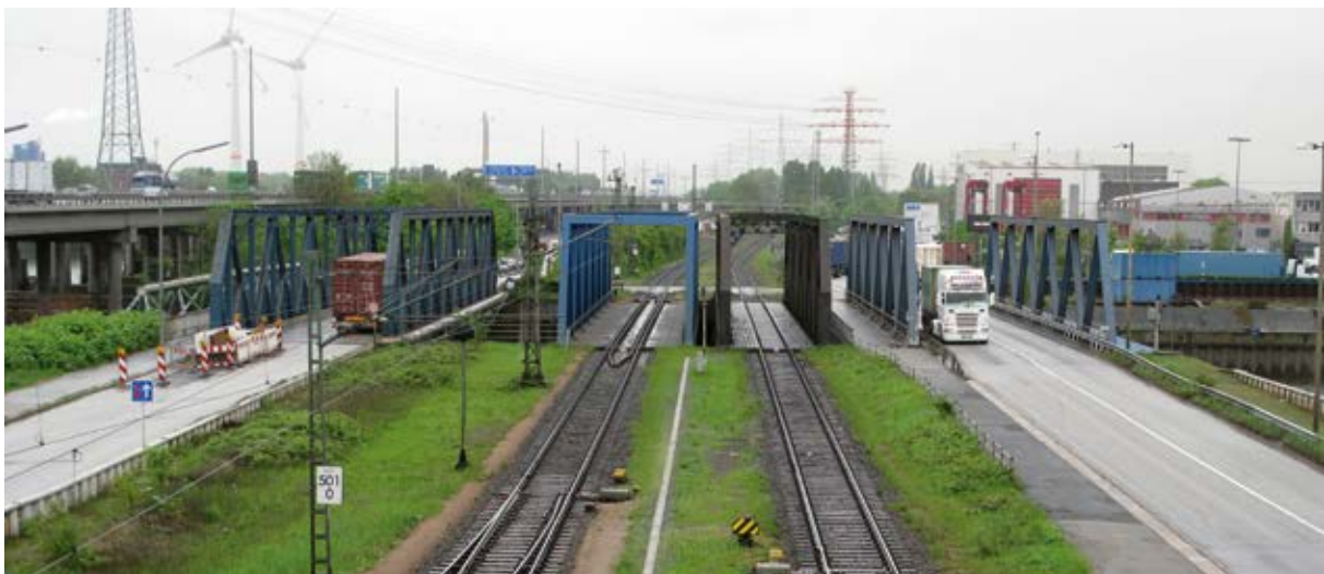
Bild 4 Die vier Bestandsbrücken (bis 2015) in der Frontalansicht; der westliche Brückenüberbau (rechts) stellt die einzige Straßenverbindung zu Hamburgs größtem Terminal, dem Containerterminal Burchardkai, dar. Diese Verkehrsverbindung soll zum einen im Zuge des Neubaus von zwei auf drei Fahrspuren verbreitert werden, zum anderen muss aber während der gesamten Bauzeit eine 2-spurige Verbindung erhalten bleiben. Die östliche Straßenbrücke (links) kann hierfür nicht genutzt werden. Foto: Thomas Witt / HPA
