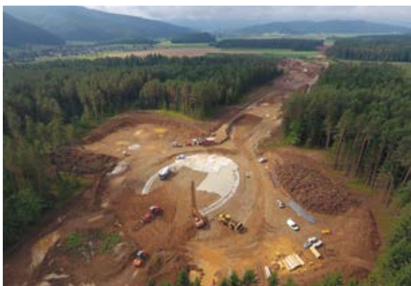
Bild 6 Herstellen der Platte zwischen den Fundamenten der Wildbrücke AM2 (links) und Verlegen der Schalelemente für die keilförmigen Aussparungen (rechts) Fotos: © Benjamin Kromoser
