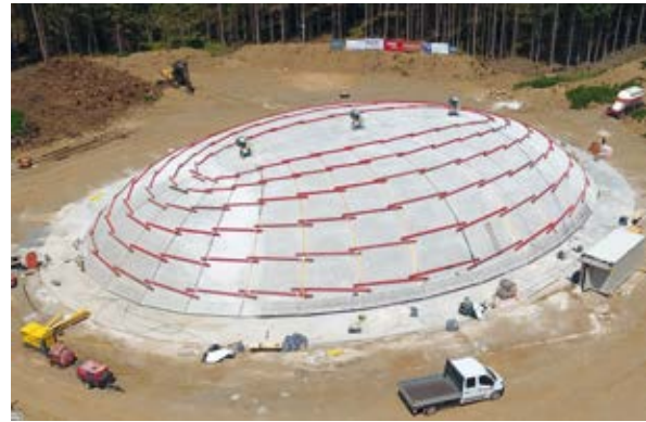
Bild 7 Ursprünglich ebene Platte (links) und fertiggestellte, umgeformte Betonschale (rechts) der Wildbrücke AM2 Fotos: © Benjamin Kromoser
