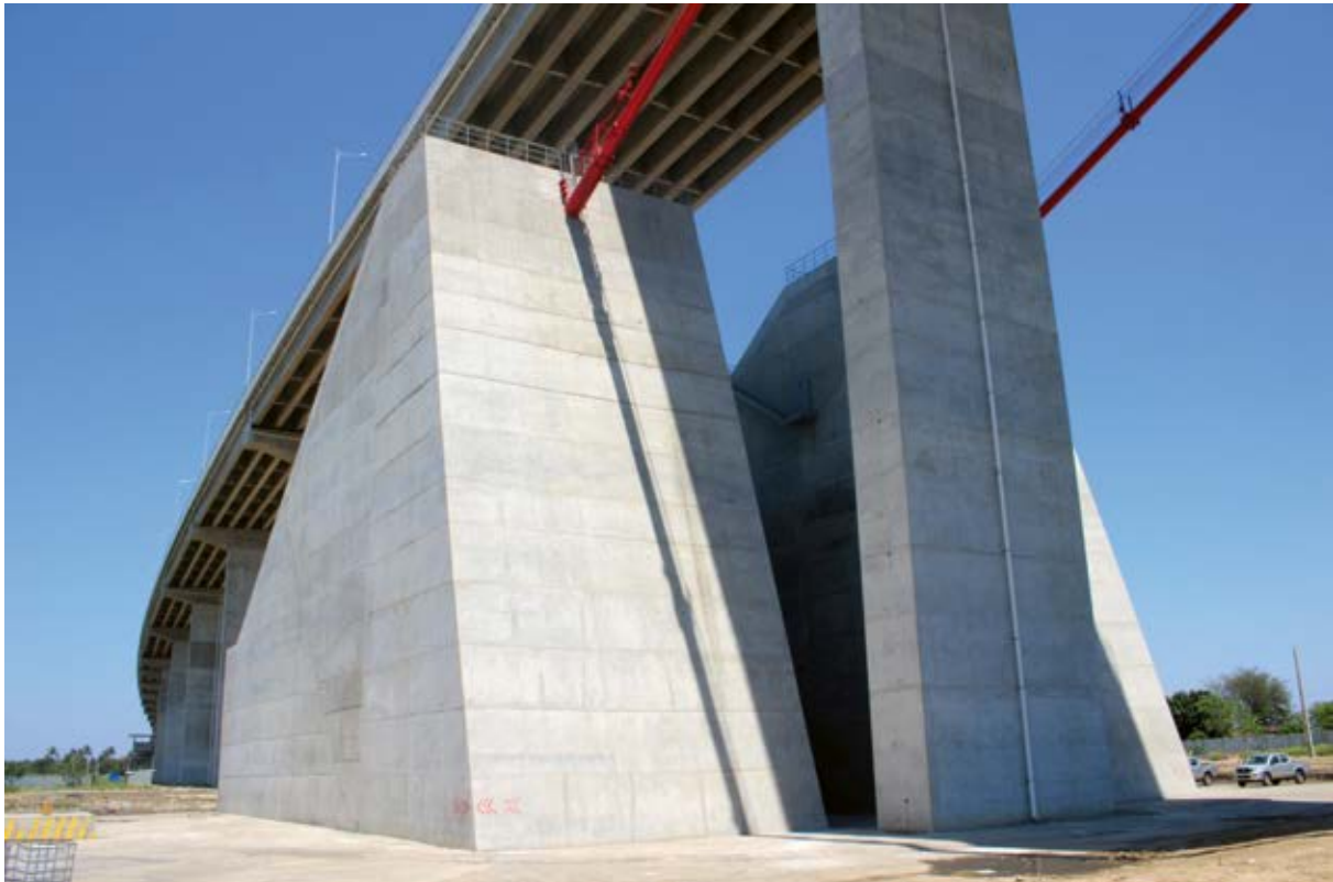
Bild 6 Verankerungsblock Süd mit ca. 27 m Höhe über Gelände
