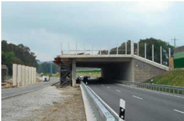
Brücke im Bau, hier 1. Bauabschnitt
