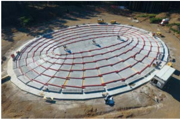
Bild 7 Ursprünglich ebene Platte (links) und fertiggestellte, umgeformte Betonschale (rechts) der Wildbrücke AM2 Fotos: © Benjamin Kromoser
