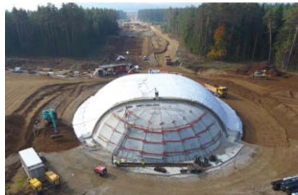
Bild 8 Aufbringen des bewehrten Aufbetons (links) und Hinterfüllen des Brückentragwerkes (rechts) Fotos: © Benjamin Kromoser
