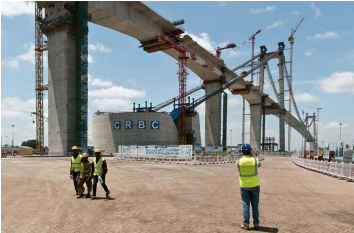
Bild 4 Nördlicher Ankerblock, Brücke im Freivorbau und deren Stützen N13, N14 und N15
