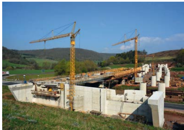
Bild 4 Netratallbrücke im Bauzustand, Zeitpunkt Bewehren des 2. Bauabschnitts, Überbau West Foto: © HTI Greußen
