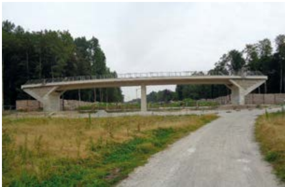
Ansicht der Brücke Paulinenweg
