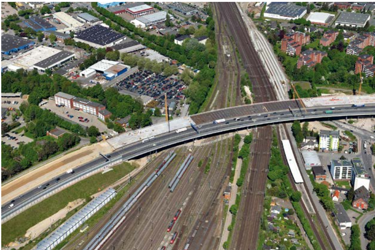
Luftbild der Langenfelder Brücke
