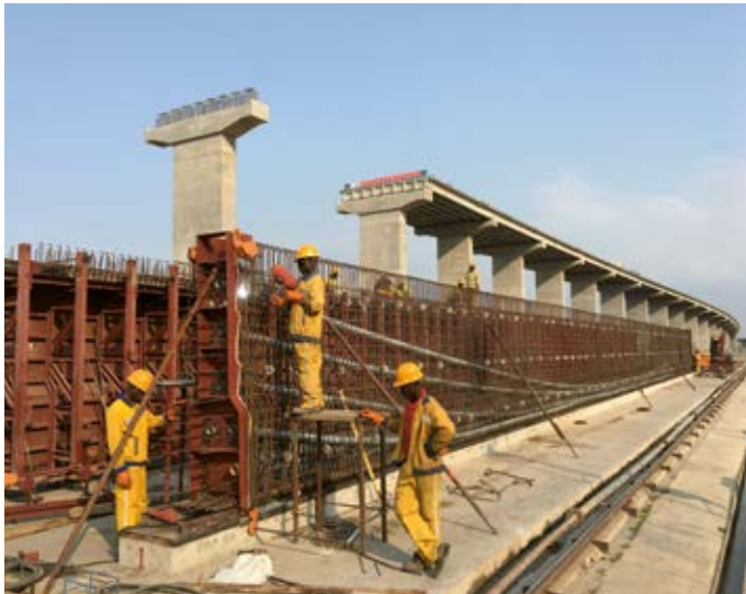
Bild 13 Fertigteilträger L = 30 m für die Vorlandbrücke Süd; Schalung (links) und Querschnitt (rechts)
