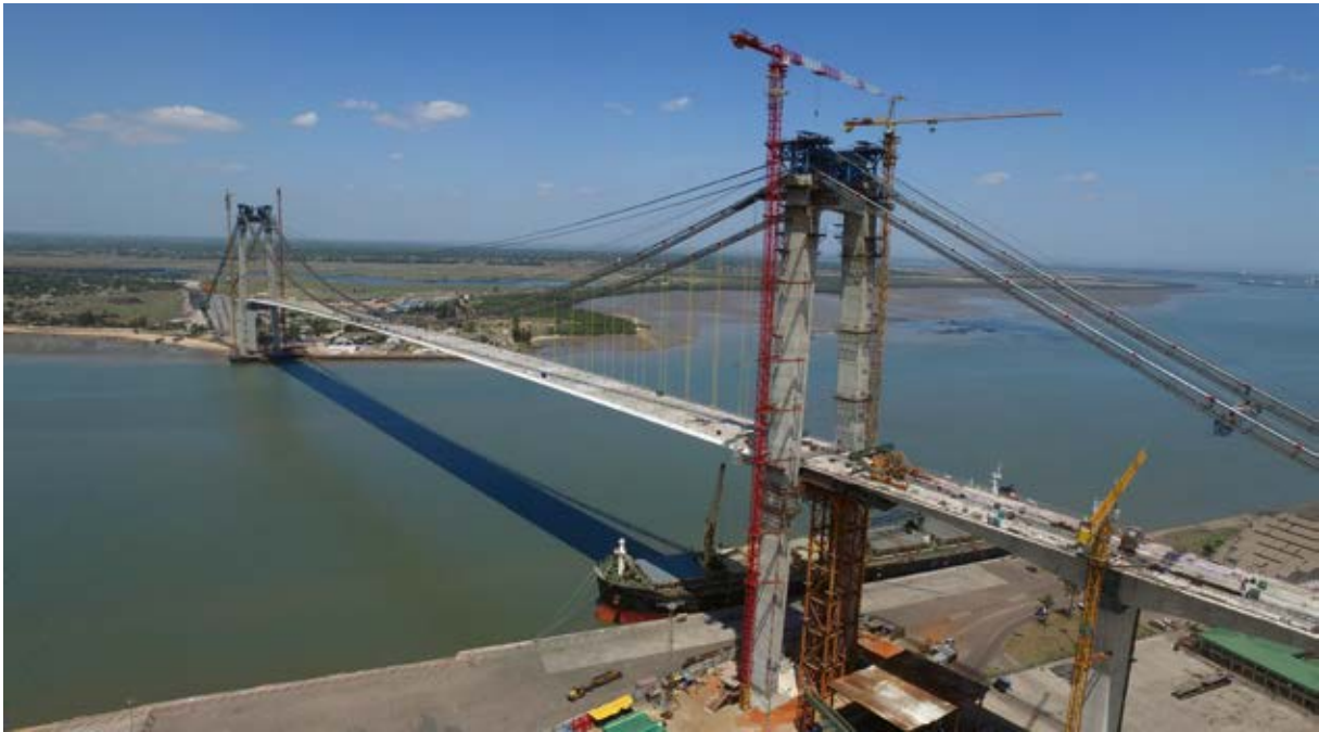
Bild 8 Stahlbrücke von Nord nach Süd über der Kaianlage des internationalen Hafens
