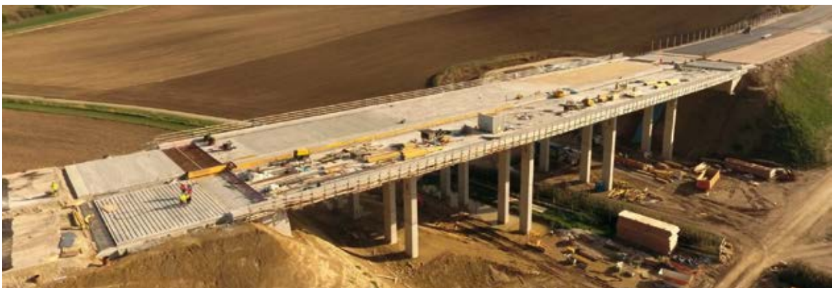
Bild 2 Einbau der Fahrwegübergangskonstruktionen an den jeweiligen Brückenden
