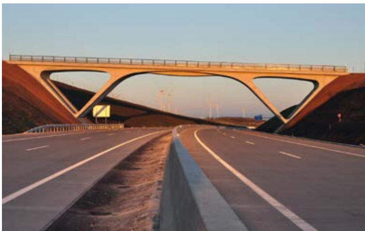
Bild 3 Beispiele materialoptimierter Überbauformen; von oben nach unten: An- und Untersicht der Überführung im Zuge der A3 in Wendlingen-Kirchheim, Überführung A5 Ü20 Grafiken: schlaich bergemann partner (oben u. mitte), © Dr. Michael Kleiser (unten)
