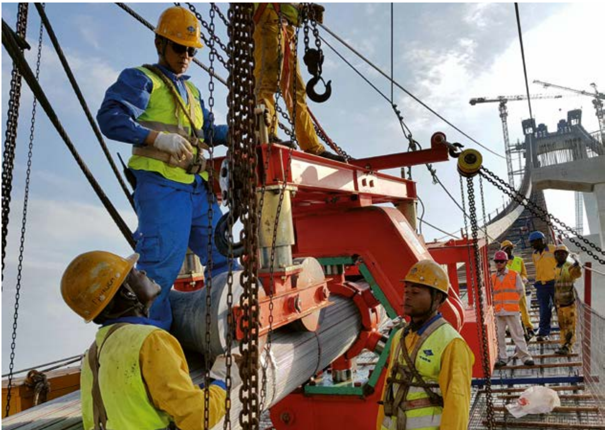
Bild 9 Montagearbeiten der Hauptkabel vom Catwalk aus
