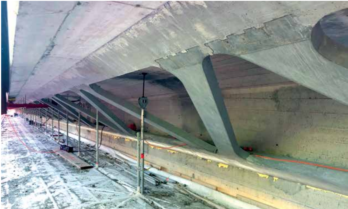
Bild 3 Ansicht des UHFB-Fachwerks
